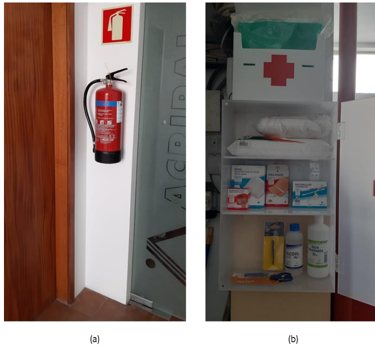
Figura 21 – Exemplo de um (a) extintor atualizado, corretamente posicionado, com sinalética identificação e (b) primeiros socorros atualizados
