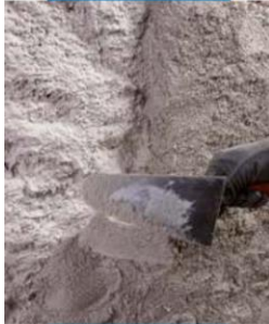
Applying Mape-Antique MC over Mape-Antique Rinzafo
