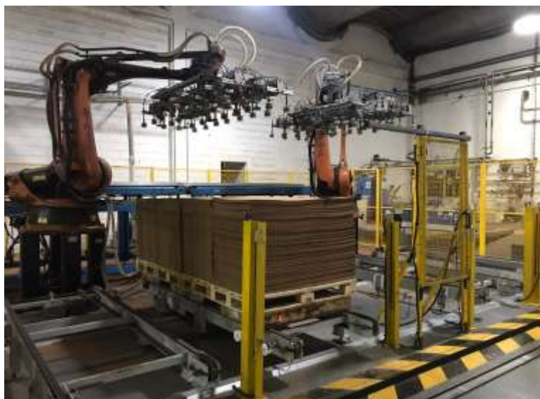
Figura 21 - Entrada de material na lixagem
