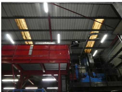
Figura 32 – Exemplo dos painéis acrílicos na cobertura existentes na instalação.
