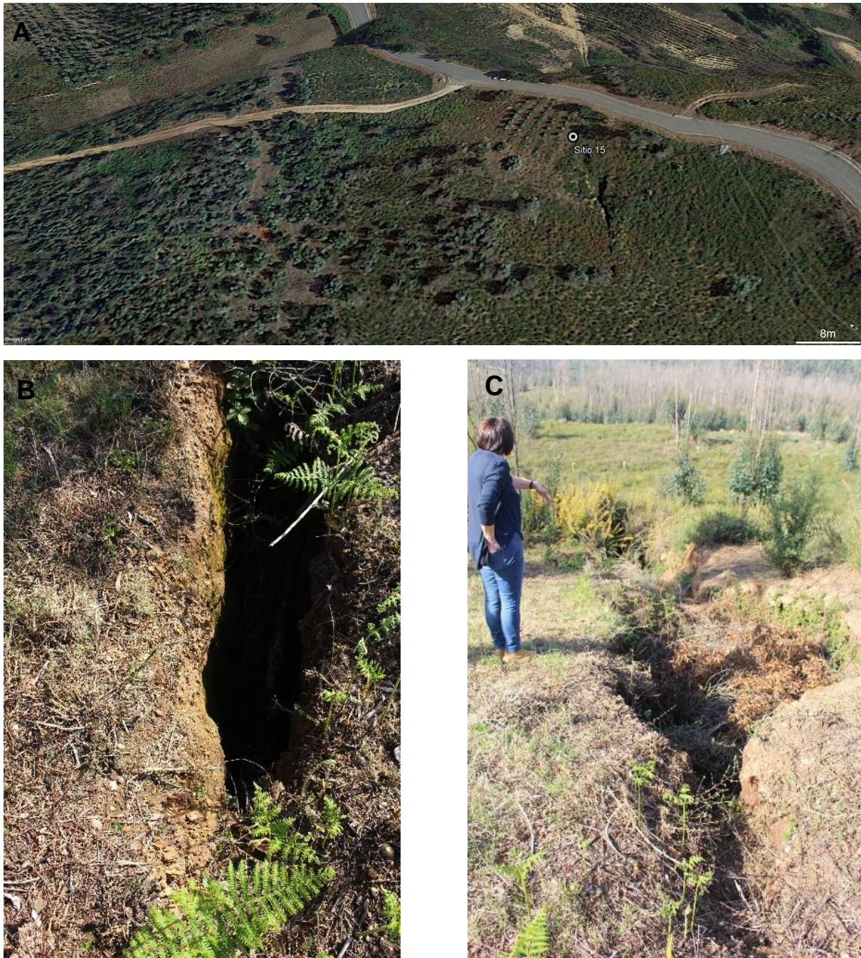
Figura 31 - Sítio 15 A. Imagem aérea ilustrando a distribuição das sanjas na porção nordeste da área pesquisada no Sítio 15. Editada do Google Earth® B. sanja vista de cima; C. sanja e sua extensão para norte
