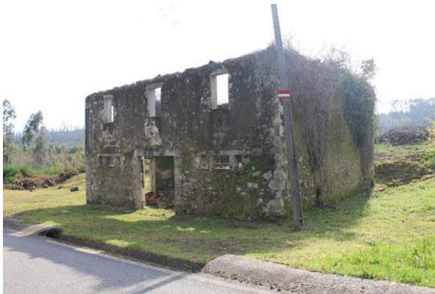
Figura 42 - Ruína das instalações da Companhia que centralizava o comércio mineiro na região.
