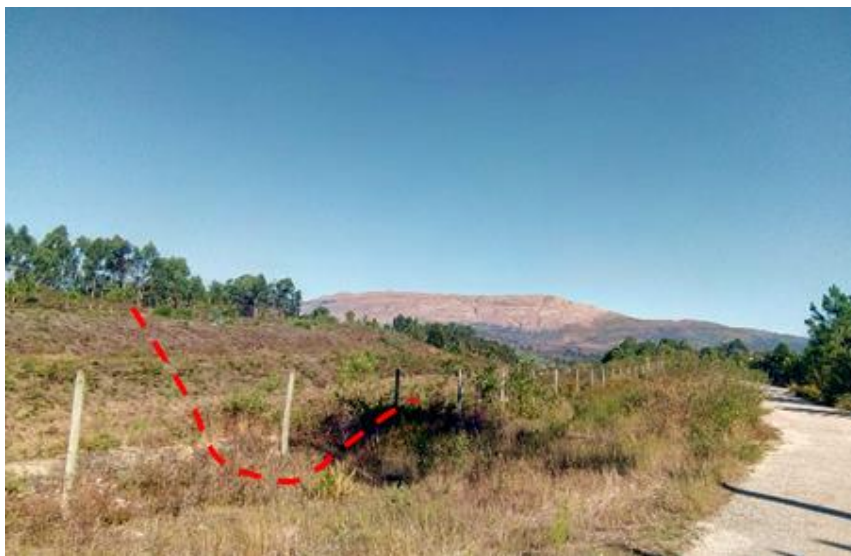
Figura 20 - Sítio 3 - Vale do Cobalta está situado à esquerda, em tracejado vermelho está delineado o formato do vale, aterrado para construção da autoestrada.
