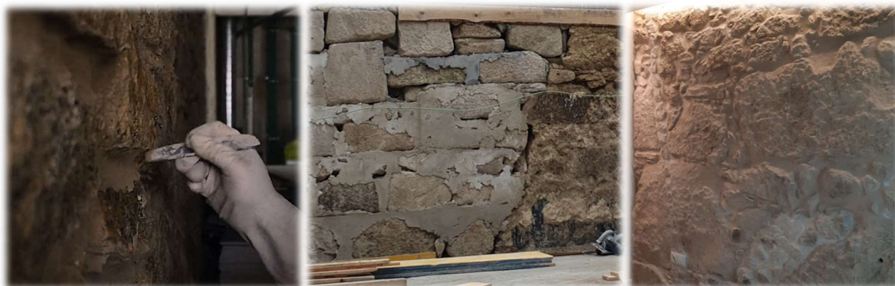
Figura 23 – Reabilitação de paredes à vista
