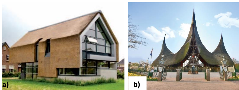
Figura 7 – Construção contemporânea com cana (a) Fonte: foto The Dutch Federation of Thatchers (Lautkankare, 2007); maior cobertura com cana já conhecida (b)(Eftepedia, 2021).
