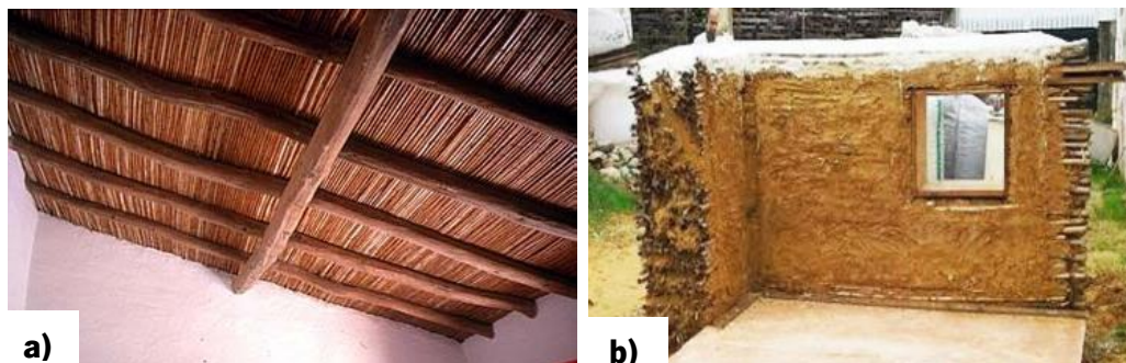
Figura 11 – Uso da cana na construção de telhados no Alentejo (a) (Correia, 2002); protótipo de Reed-cob (b)(Carneiro et al., 2017).
