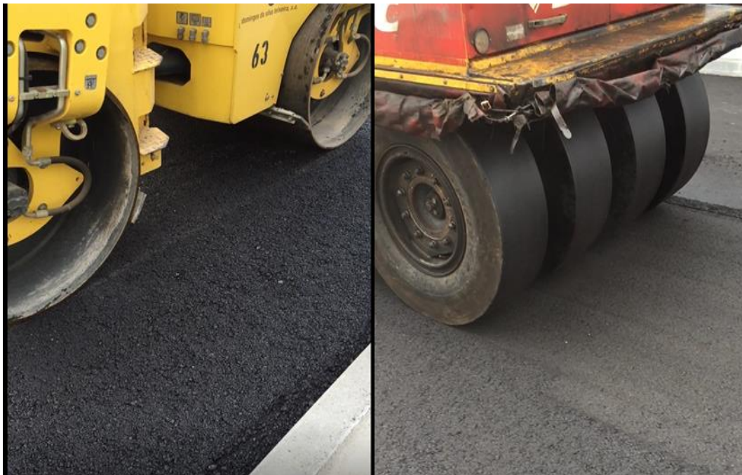
Figura 49. Compactação de pavimento no trecho experimental
