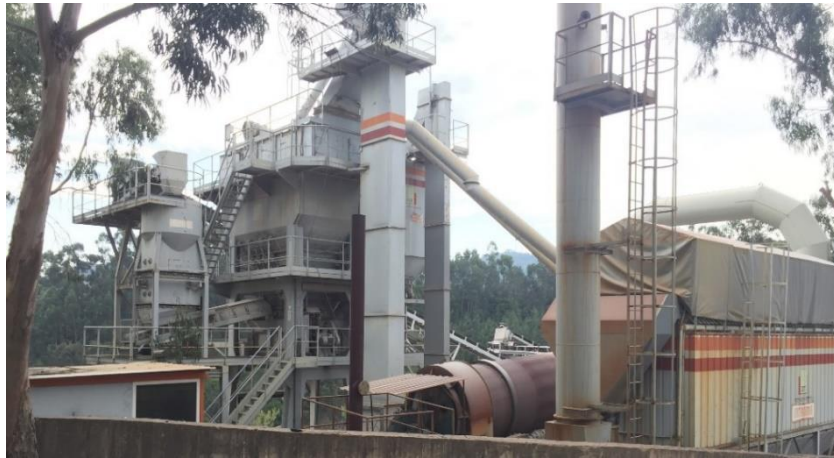
Figura 46. Central betuminosa descontínua utilizada no trecho
