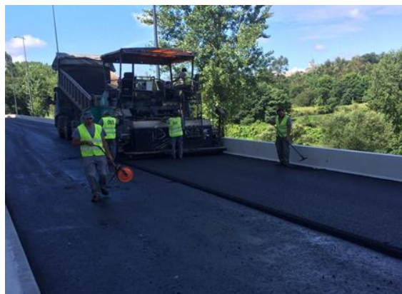
Figura 48. Pavimentadora espalhando mistura no trecho experimental
