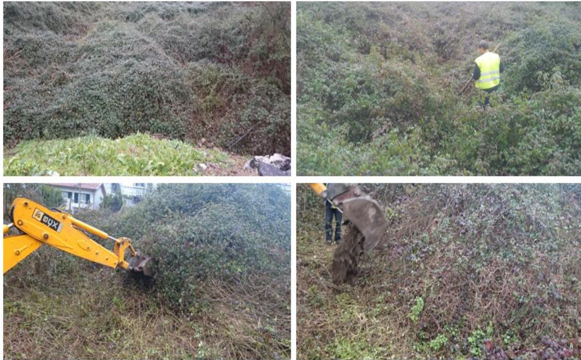
Figura 4-8: Exemplo de trabalhos de desmatação.
