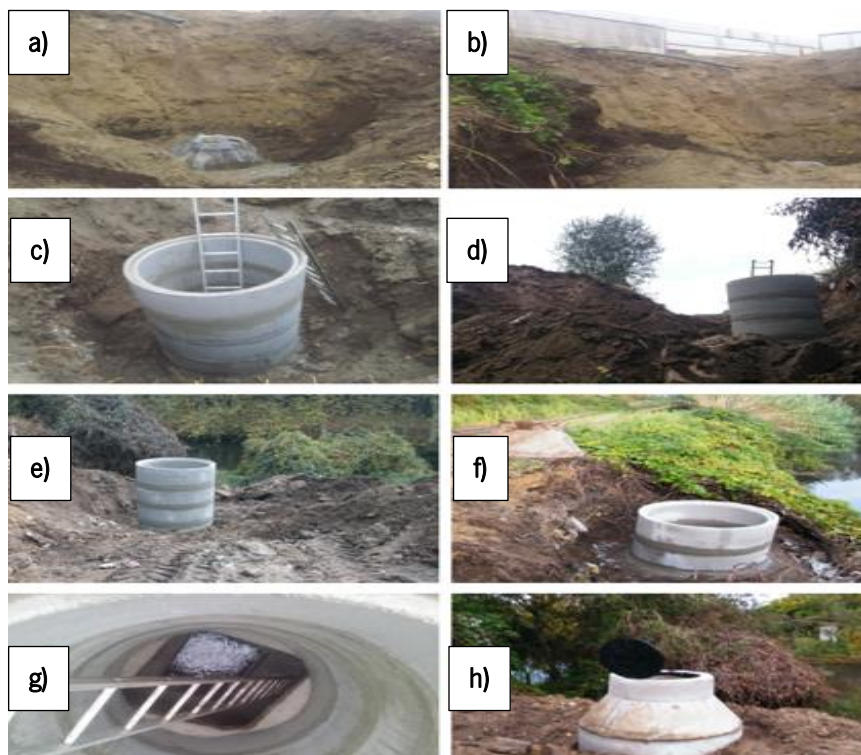
Figura 4-10: a) e b) Câmara enterrada e c) a h) Elevação de câmara de visita.
