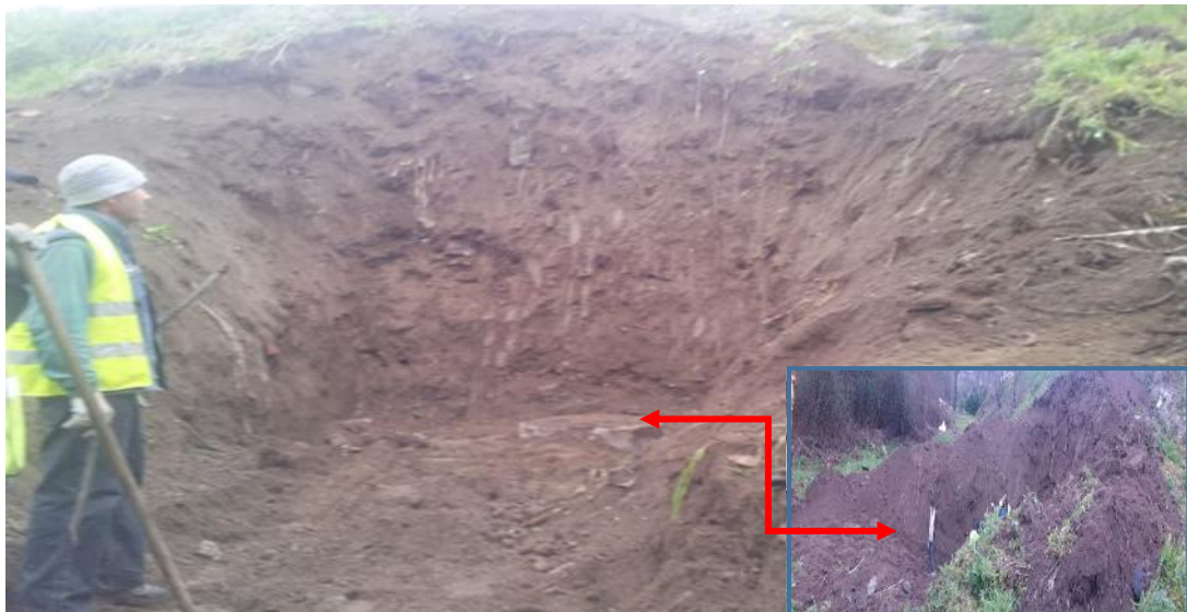
Figura 3-11: Escavação para acesso a câmara de visita.
