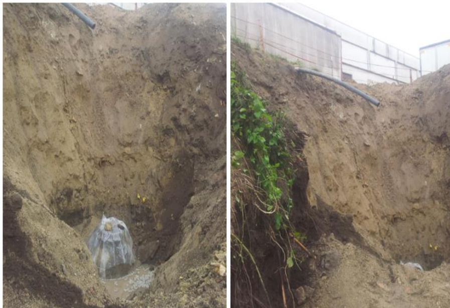
Figura 4-5: Exemplo de câmara de visita soterrada.
