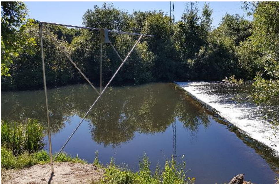
Figura 3-22: Estrutura para colocação de sensores de monitorização em linhas de água.
