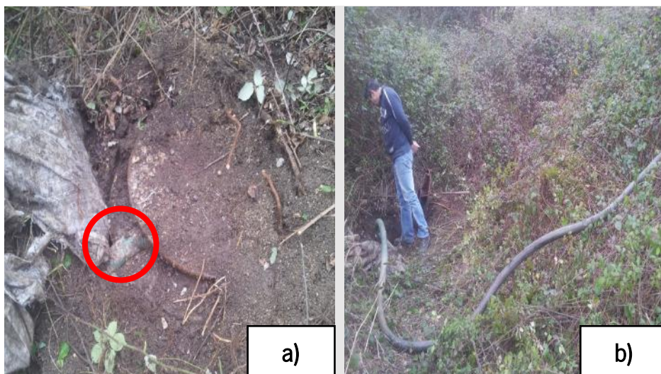
Figura 3-15: a) Tubagem amovível enterrada (ligação ilícita); b) Após desaterro de ligação indevida.
