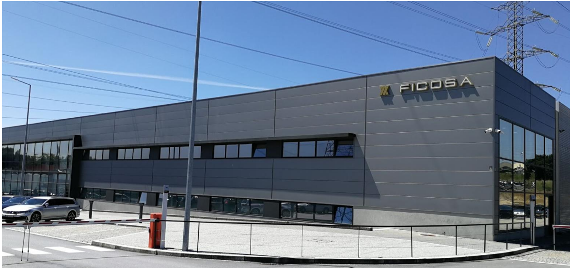
Figura 7 – FicoCables, edifício novo (UAP4)
