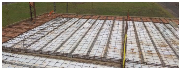
Figura 39: Laje treliçada (FA3)
