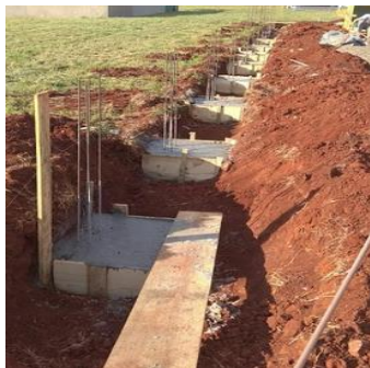
Figura 43: Representação de uma sapata – canteiro de obra (FA3).
