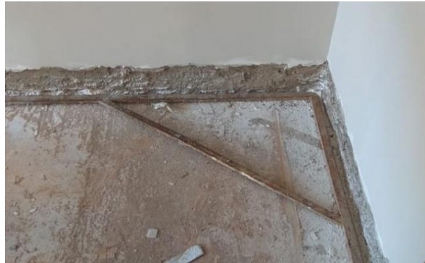
Figura 35: O esquadro – canteiro de obra (FA2)
