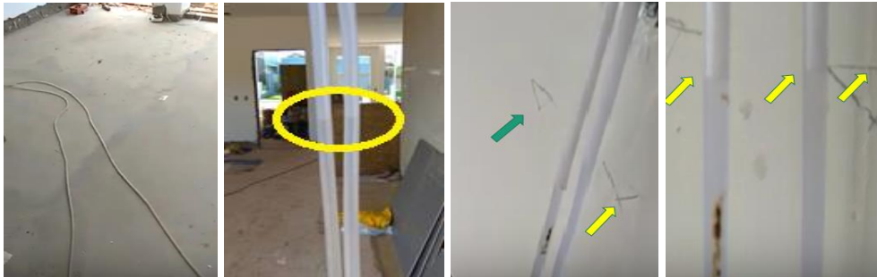
Figura 37: Uso da mangueira de nível – canteiro de obra (FA2)
