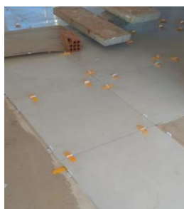
Figura 38: Noção de área para o assentamento cerâmico – canteiro de obra (FA2)
