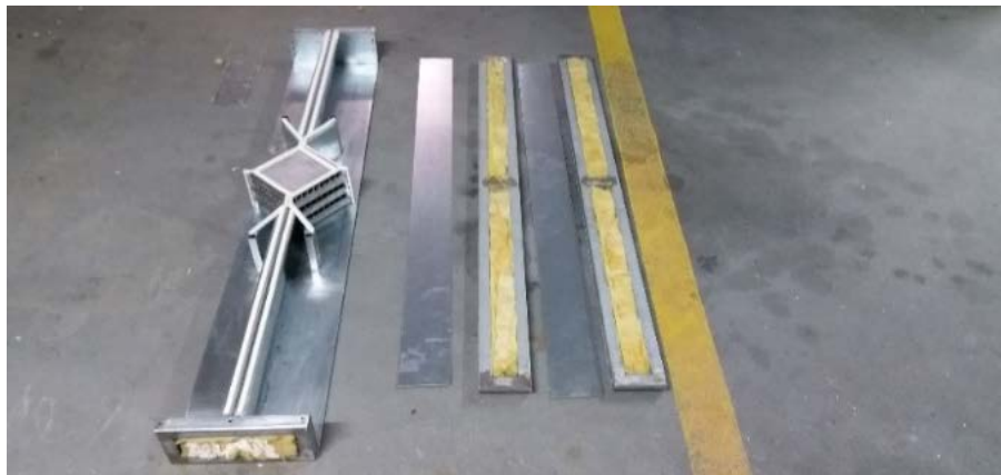
Figura 3.18. Montagem dos fechamentos duplos.
