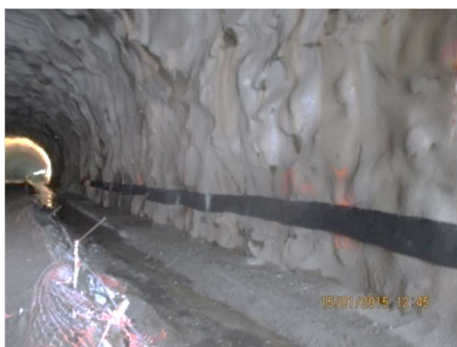
Fig.380-Hasteais ainda não revestidos [31]
