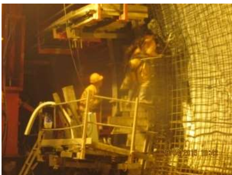
Fig.261-Montagem de topo de cofragem [31]
