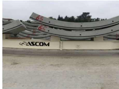
Fig.199-Aduelas já betonadas no exterior [277]
