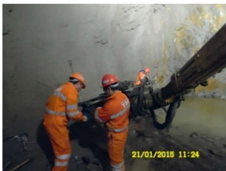
Fig.222-Reparação de varas [31]
