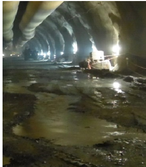
Fig.365-Pavimento com irregularidades [31]
