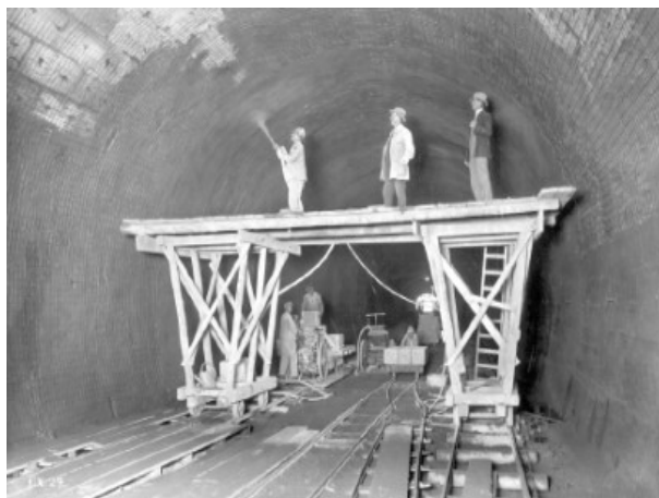
Fig.36-Projeção de betão no Túnel Ulmberg, em Zurique, em 1927 [39]
