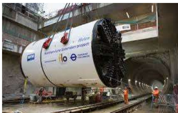
Fig.7-Estaleiro da Northern Line Extension [34]
