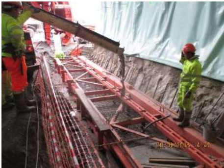
Fig.133-Cofragem de rebaixo[31]
