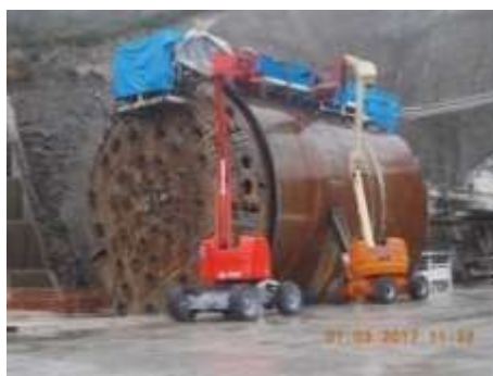
Fig.237-Desmontagem de tuneladora [58]
