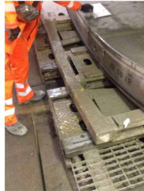
Fig.302-Aproximação da aduela a eretor [277]
