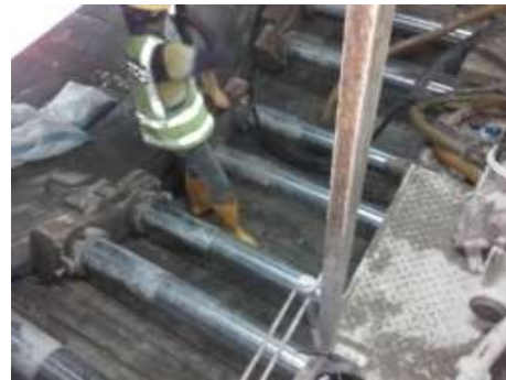
Fig.304-Trabalhos junto a grippers [277]
