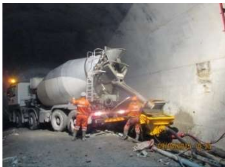
Fig.139-Distribuição de betão [31]
