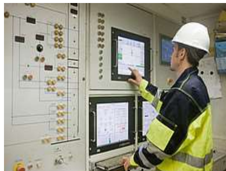
Fig.215-Cabina de controlo de tuneladora [319]
