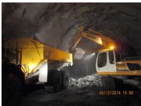
Fig.167-Carga e remoção de escombros [31]
