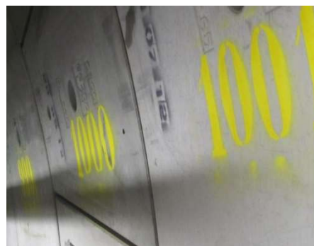
Fig.296-Aduela pré-fabricada [236]
