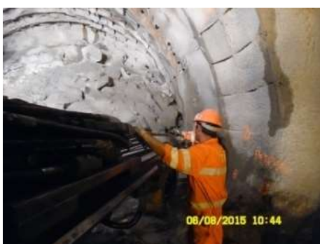
Fig.285-Substituição de varas de furação[31]
