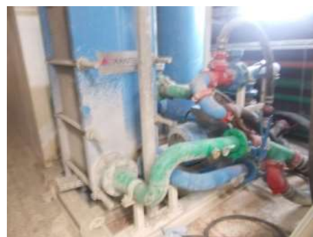
Fig.185-Circuitos de soluções estabilização [58]
