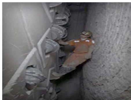
Fig.252-Substituição de discos de corte [205]
