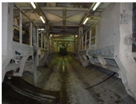
Fig.364-Pavimento com aduela betonada [334]
