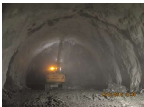
Fig.177-Levantamento de poeiras em picagem [31]
