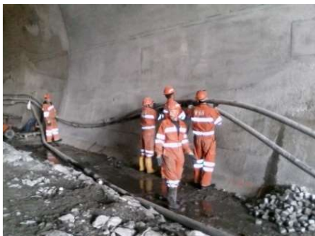
Fig.204-Reposicionamento de tubagens [31]
