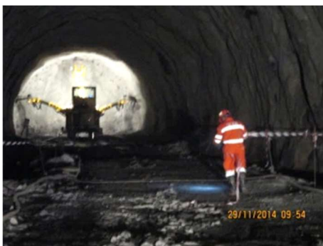
Fig.224-Hasteais e abóbada não revestidos [31]
