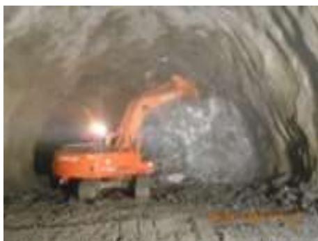
Fig.323-Trabalhos em face de escavação [31]
