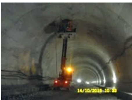
Fig.242-Reparação de betão [31]
