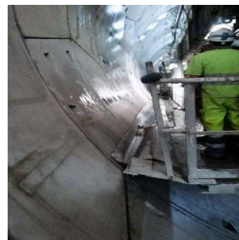
Fig.268-Espaçamento tuneladora/hasteal [58]
