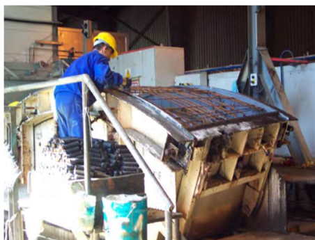
Fig.191-Montagem de cofragem aduela [277]
