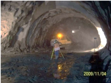
Fig.390-Mapeamento de frente de escavação[31]
