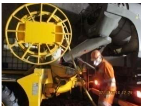
Fig.127-Descarga de betão [31]
