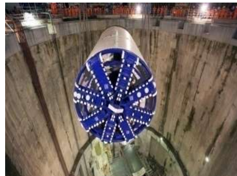
Fig.398-Estrutura de tuneladora [236]
