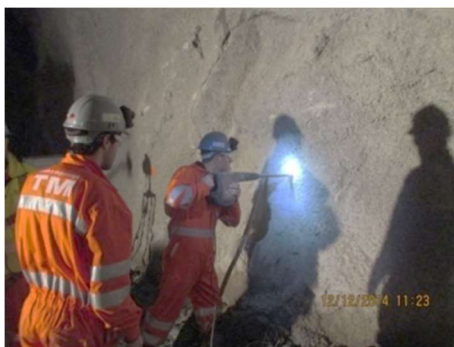
Fig.367-Furação para provete [31]
