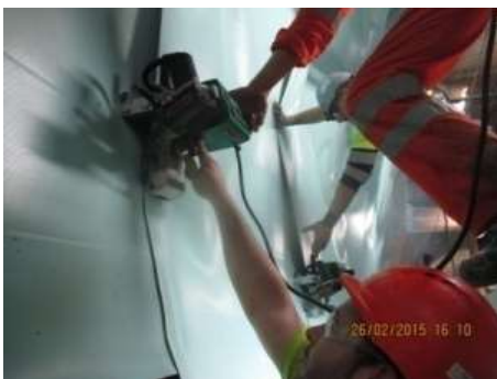
Fig.386-Termosoldadura de telas [31]
