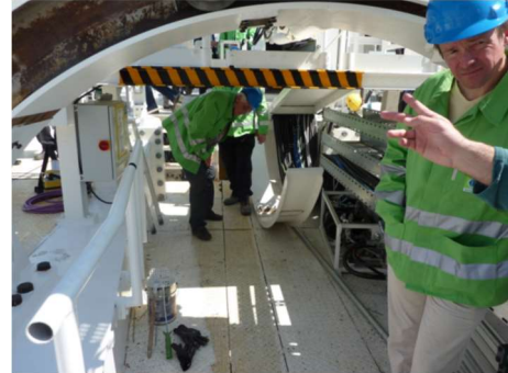
Fig.385-Panorama zona de trabalhos [127]
