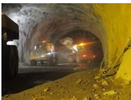
Fig.125-Carregamento de escombros [31]
