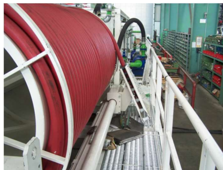
Fig.109-Instalações elétricas da tuneladora [127]
