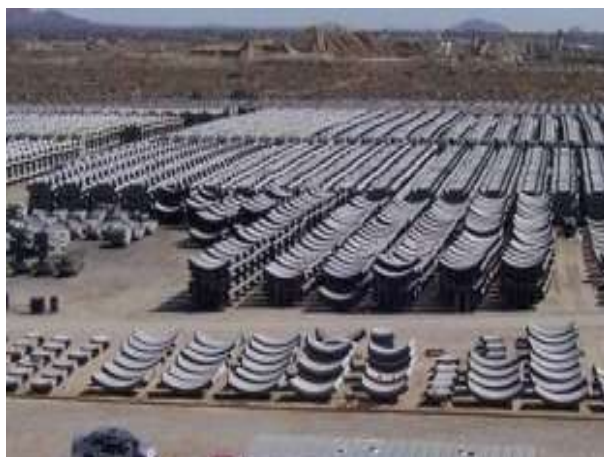
Fig.52-Espaço necessário para armazenamento de aduelas pré-fabricadas [15]
