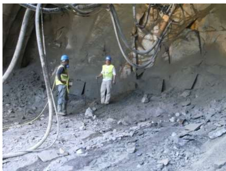
Fig.218-Projeção de betão [31]
