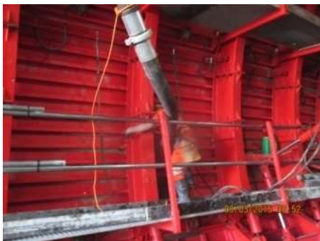
Fig.307-Manuseamento de mangueira de betão [31]
