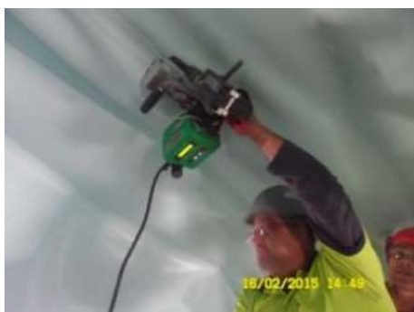
Fig.151-Termossoldadura [31]
