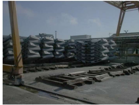
Fig.357-Zona de preparação de aduelas [334]
