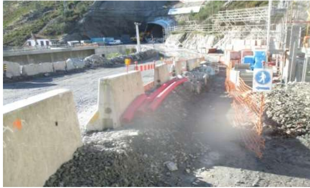
Fig.77-Separação vias de circulação [303]
