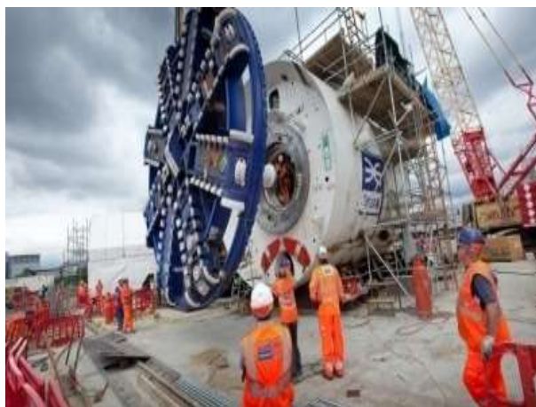
Fig.51-Montagem de cabeça de tuneladora [236]
