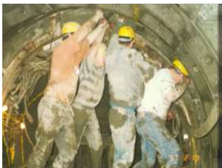
Fig.287-Montagem de cambotas [284]
