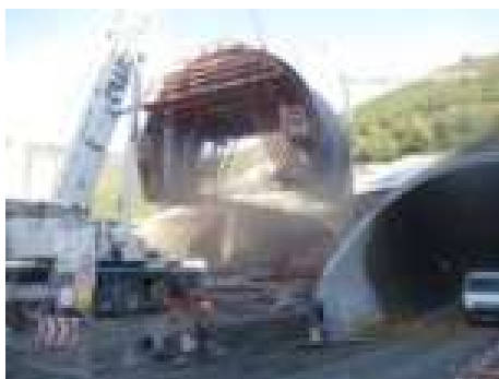
Fig.230-Movimentação de molde de cofragem [31]
