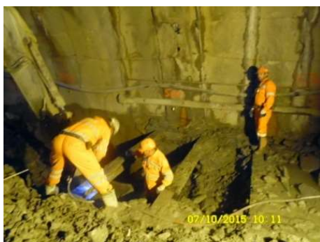
Fig.212-Trabalhos junto a face escavação [31]
