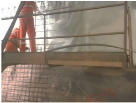
Fig.153-Corte de varões para armaduras [31]
