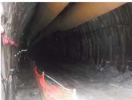
Fig.120-Mangas de ventilação[31]
