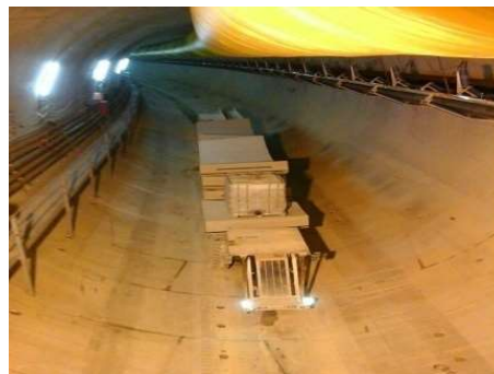
Fig.140-Aduela pré-fabricada [277]
