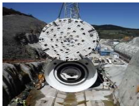
Fig.231-Movimentação cabeça de tuneladora [58]
