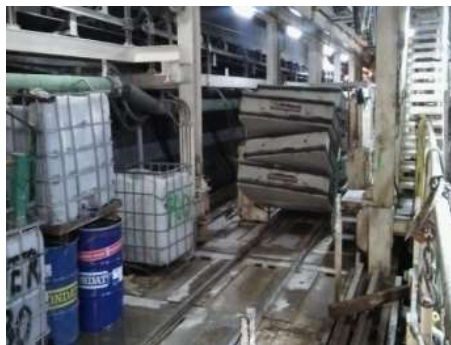
Fig.308-Transporte mecânico de aduelas [58]
