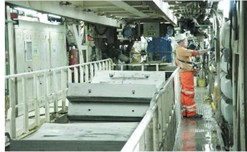
Fig.396-Zona de receção de aduelas [277]
