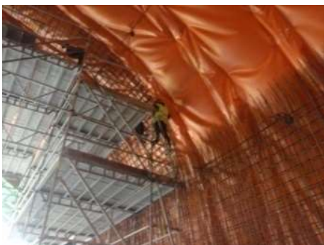
Fig.259-Montagem de armaduras da abóbada [31]
