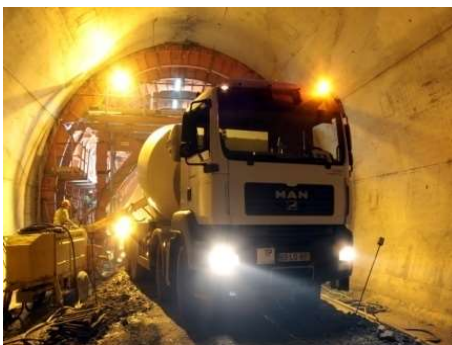
Fig.388-Finalização de betonagem [31]
