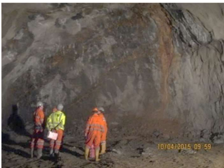
Fig.392-Trabalhadores próximos do maciço [31] ,
