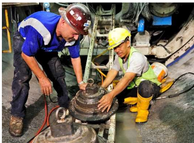
Fig.408–Substituição de discos [205]
