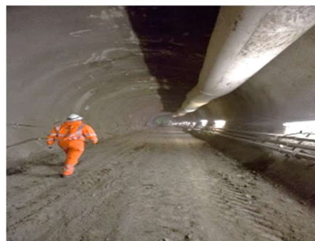
Fig.250-Estado de pavimento após aterro [236]
