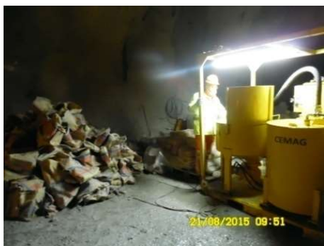
Fig.147-Sacos de cimento para estabilização [31]
