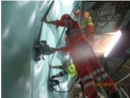
Fig.118-Montagem de telas [31]
