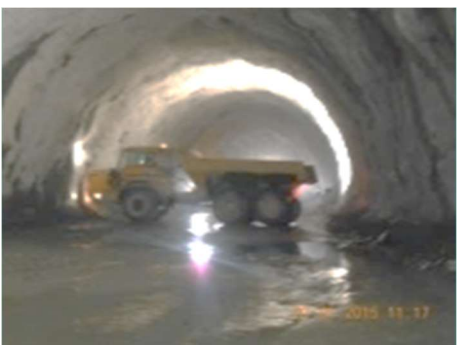
Fig.399-Retirada de escombro [31]
