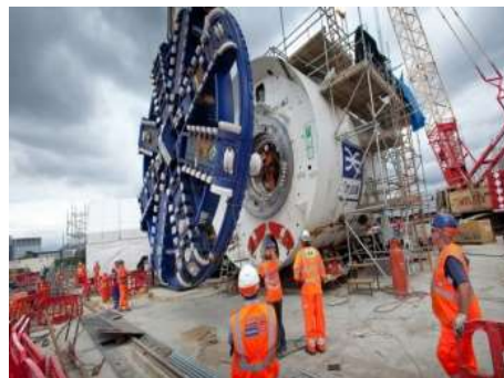
Fig.284-Cabeça de corte [236]
