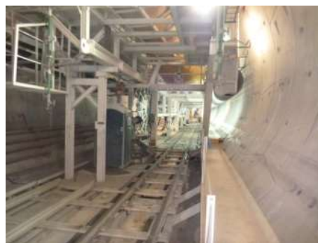
Fig.282-Automatização de tuneladora [58]
