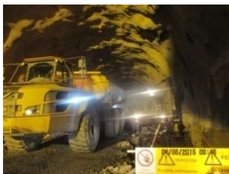
Fig.173-Circulação de dumpers [31]
