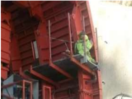
Fig.257-Montagem de molde betonagem [31]
