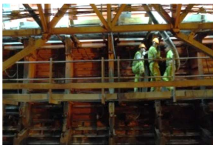
Fig.318-Posturas para montagem de cofragem [31]
