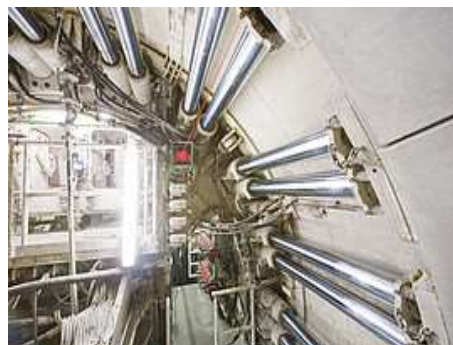
Fig.343-Grippers para avanço de escavação [319]
