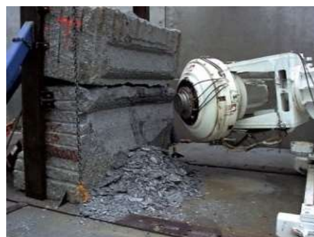
Fig.170-Resíduos gerados por disco de corte [325]
