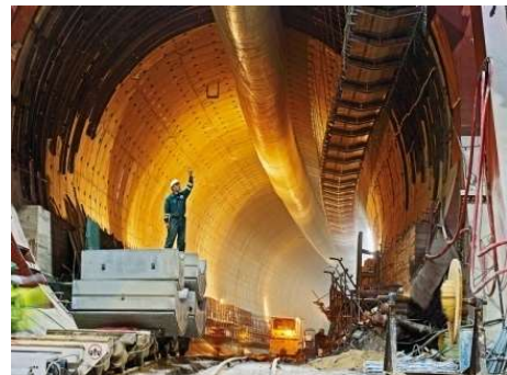
Fig.136-Chegada de aduelas a obra [319]
