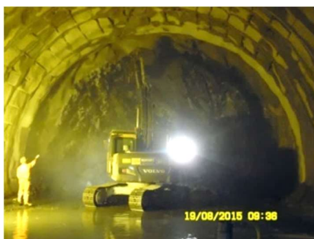
Fig.216-Saneamento mecânico [31]
