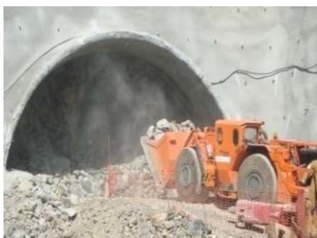
Fig.169-Carregamento de escombro [31]
