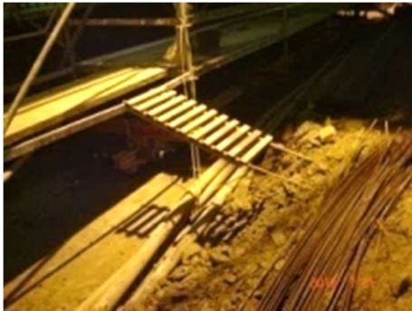
Fig.269-Acesso a estrutura de montagem [31]
