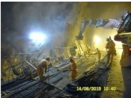
Fig.291-Movimentação de cofragem [31]
