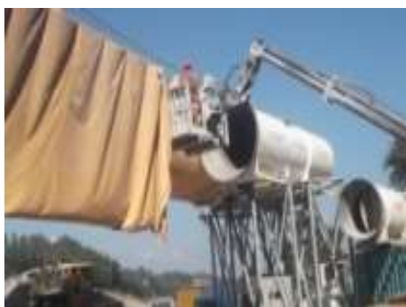
Fig.297-Manutenção de mangas ventilação [31]
