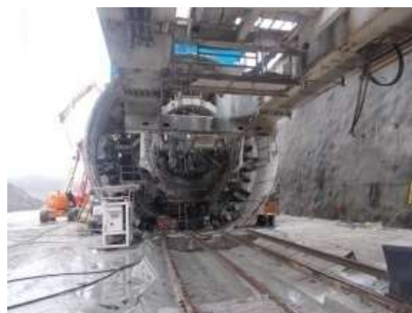
Fig.166-Interior de cabeça de corte [58]
