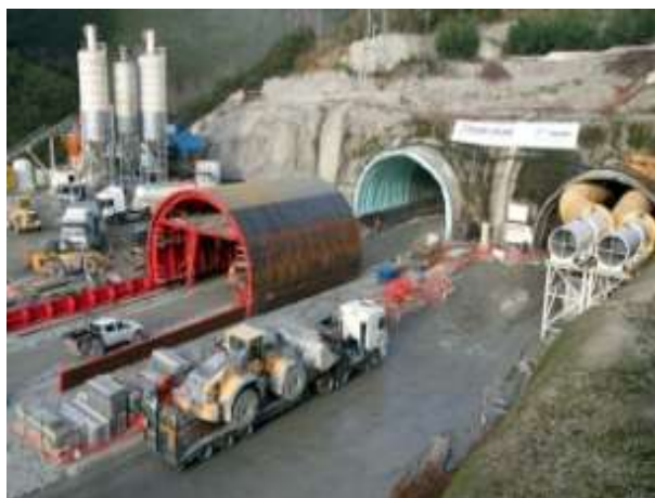
Fig.49-Montagem de equipamento em estaleiro [31]
