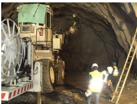
Fig.251-Escada em face escavação [31]
