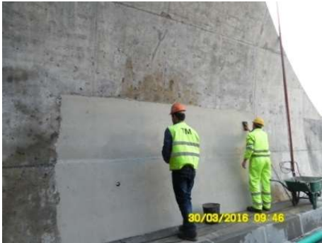
Fig.198-Reparação de revestimento definitivo [31]
