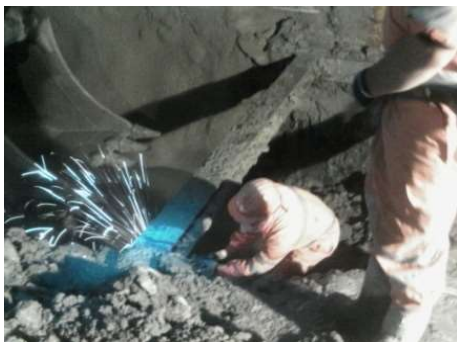
Fig.192-Corte de perfil de pé de cambota [31]
