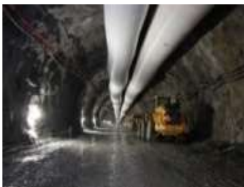
Fig.3-Túnel do Marão–vista geral [31]
