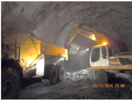
Fig.350-Carregamento de escombro [31]
