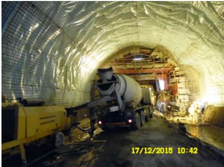
Fig.238-Autobetoneira para betonagem [31]
