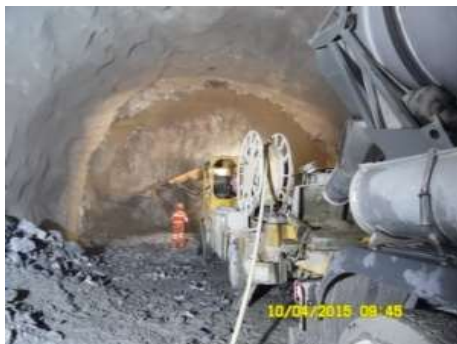
Fig.333-Revestimento primário [31]
