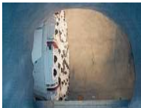
Fig.349-Cabeça de corte [31]
