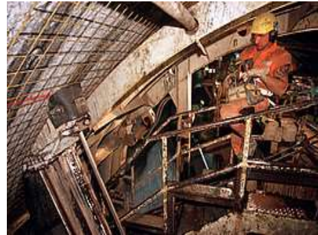
Fig.132-Plataforma aplicação de pregagens [319]
