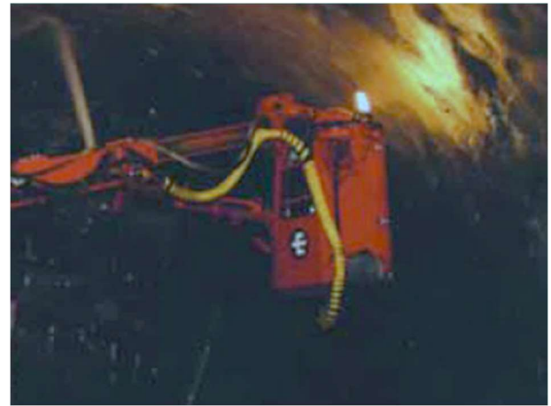
Fig.181-Cabine fechada junto a abóbada [124]
