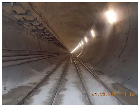
Fig.330-Alinhamento de carris de tuneladora[58]
