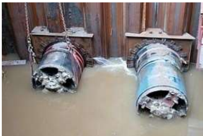
Fig.83-Afluência de água em emboquilhamentos [319]
