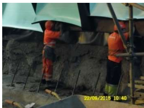
Fig.311-Trabalho junto a varões [31]
