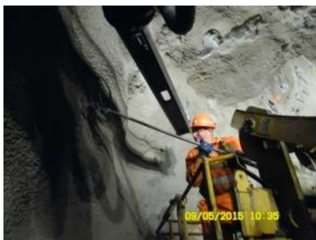
Fig.281-Montagem de dispositivo de estabilização [31]
