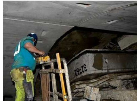
Fig.119-Posicionamento de aduelas[236]
