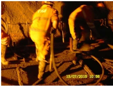
Fig.371-Vibração de betão em sapata de hasteal [31]
