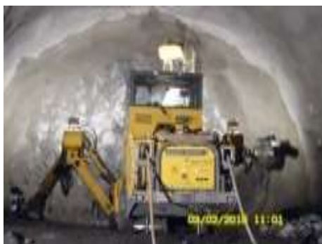
Fig.348-Picagem de maciço rochoso [31]
