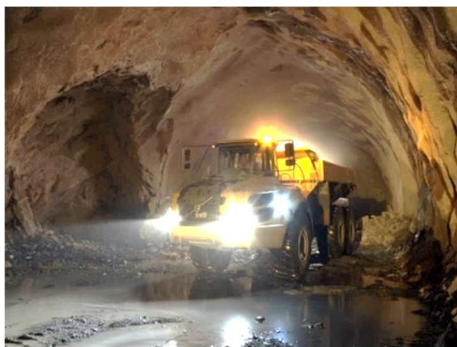
Fig.325-Remoção de escombros com dumper [31]
