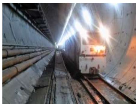
Fig.381-Paredes revestidas em tuneladora [58]
