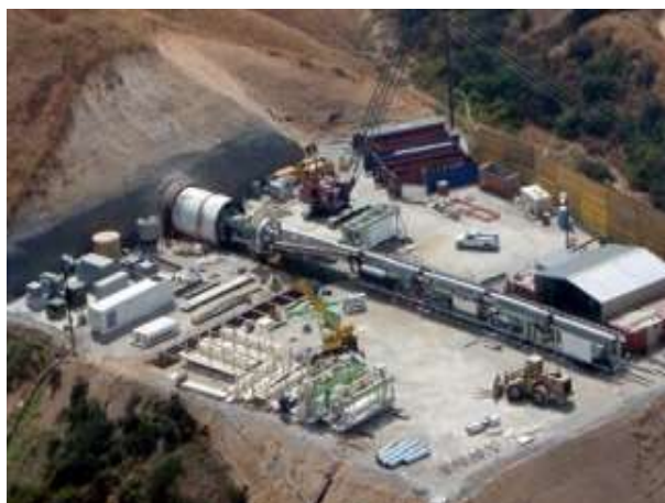
Fig.50-Exemplo de estaleiro necessário para o MET [15]
