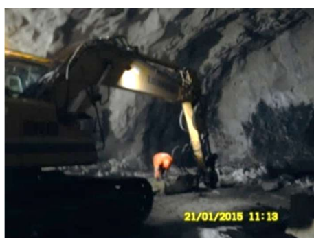
Fig.171-Manobrador fora de cabine [31]
