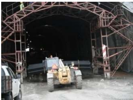
Fig.275-Chegada de materiais a estruturas [31]
