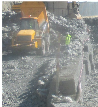
Fig.248-Muro de gabiões em bordadura talude [31]
