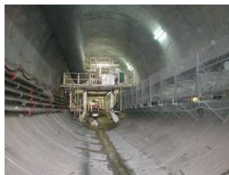
Fig.298-Backup de tuneladora [334]
