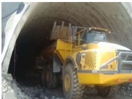
Fig.329-Alinhamento de circulação de dumper [31]
