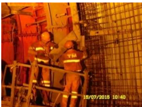
Fig.305-Montagem de cofragem [31]
