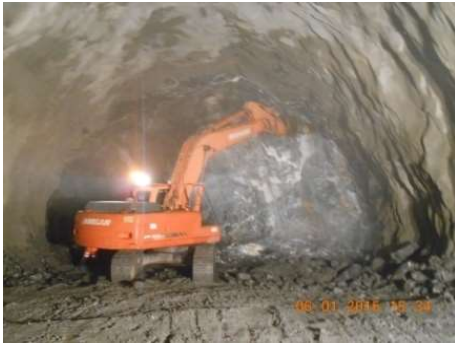
Fig.129-Saneamento mecânico [31]
