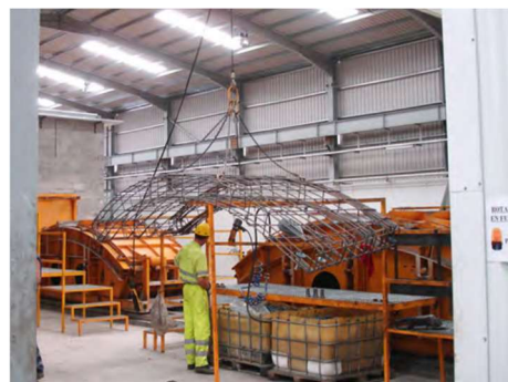
Fig.260-Montagem de armadura de aduela [234]
