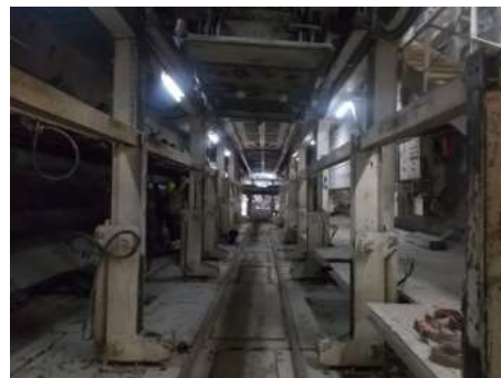
Fig.276-Zona de descarga de materiais [58]
