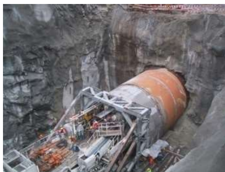
Fig.362-Corpo de tuneladora [334]
