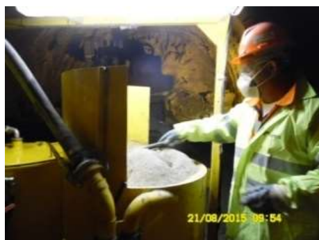
Fig.184-Caldas de cimento para grouting [31]
