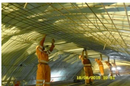
Fig.317-Montagem de armadura de abóbada [31]
