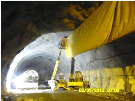
Fig.244-Manutenção de manga de ventilação [31]
