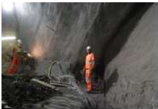
Fig.226-Escavação com face inclinada [38]
