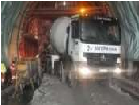
Fig.403-Betonagem de molde [31]
