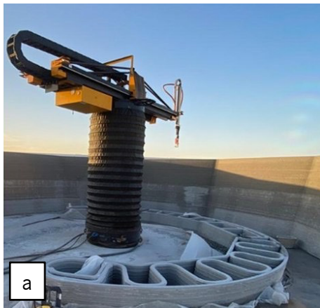
Figura 23 – (a) Impressora Apis Cor, (b) Modelo sendo construído com a impressora 3D Apis Cor (Apis cor, n.d.)
