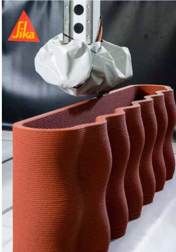
Figura 25 – Modelo sendo construído com a impressora 3D da Sika® (SIKA, n.d.)
