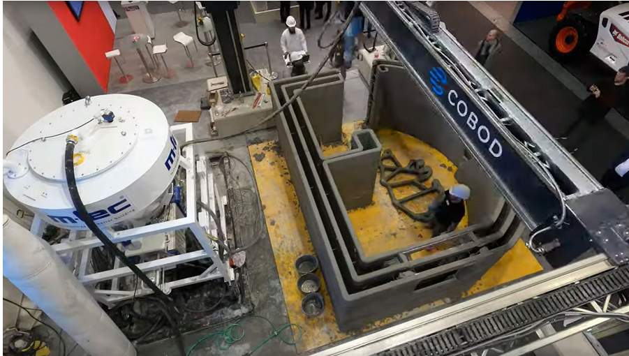
Figura 18 – Processo de operação da Impressora BOD2.
