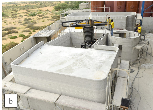
Figura 23 – (a) Impressora Apis Cor, (b) Modelo sendo construído com a impressora 3D Apis Cor (Apis cor, n.d.)
