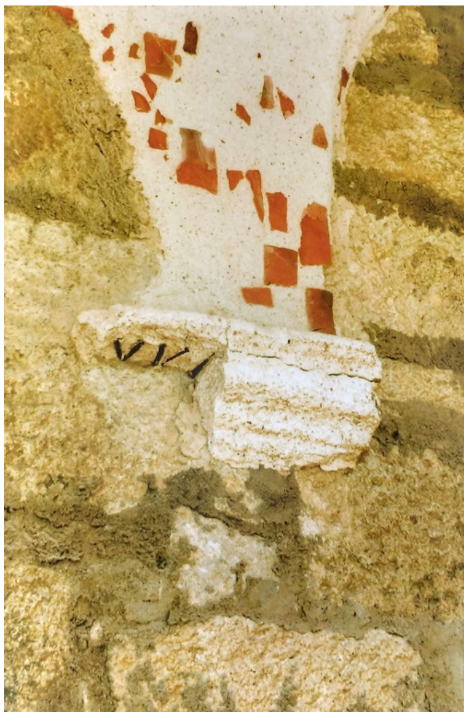
Figura 135 - Pormenor da falsa mísula do arco abatido do teto da galeria térrea da ala norte do claustro. Fotografia de Inês d'Orey cedida pela DRCN.
