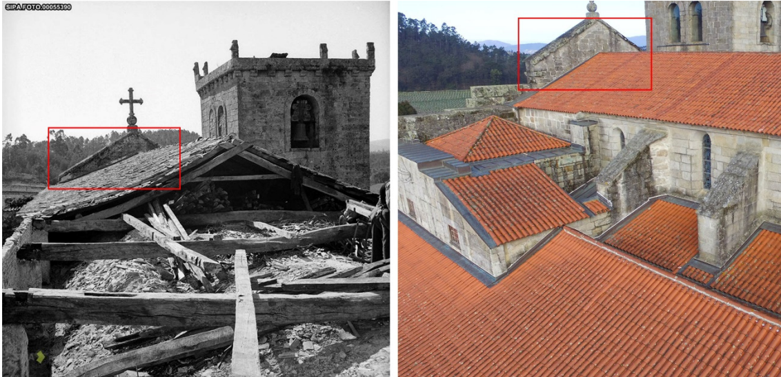
Figura 118 - Pormenor da localização do telhado antes (esquerda) e depois (direita) da intervenção da DGEMN na década de 40 do século XX. Fonte da fotografia da esquerda: monumentos.pt / CC BY-NC-ND-3.0.
