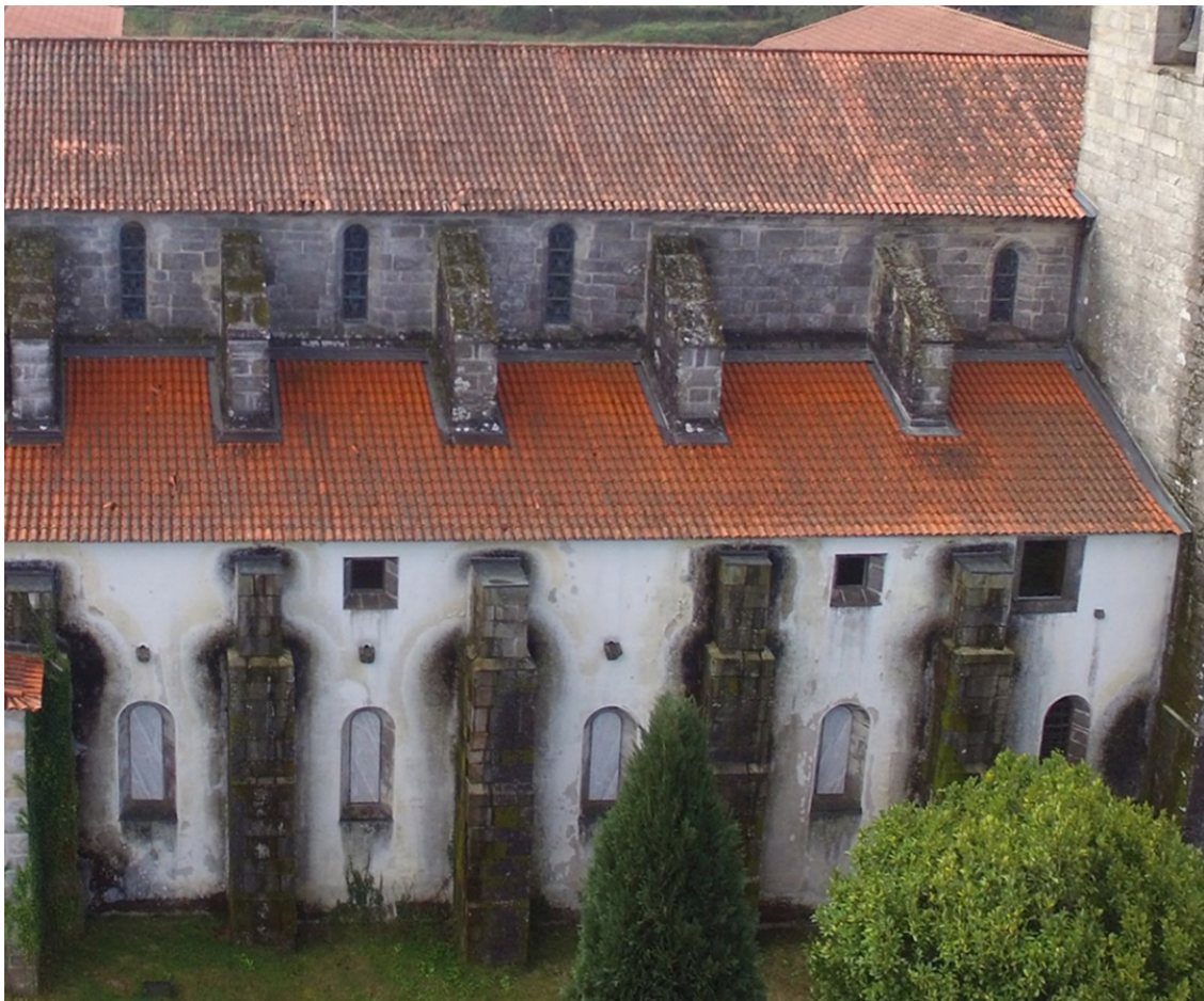
Figura 110 - Perspetiva exterior da do alçado norte da parede norte do corpo da igreja. Fotografia cedida por João Ribeiro.
