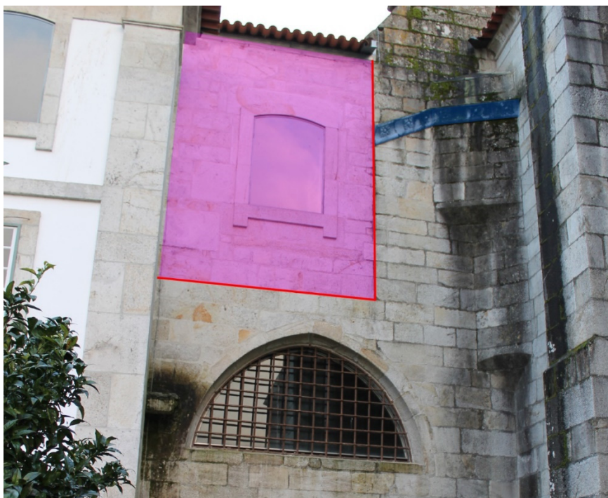
Figura 101 – Pormenor da empreitada de reformulação do claustro sul que afetou o braço sul do transepto. Em pormenor é possível observar a estrutura do século XVIII, o interface de rotura efetuado no transepto quinhentista e os arranques que identificam uma solução de cobertura idêntica à da capela norte.
