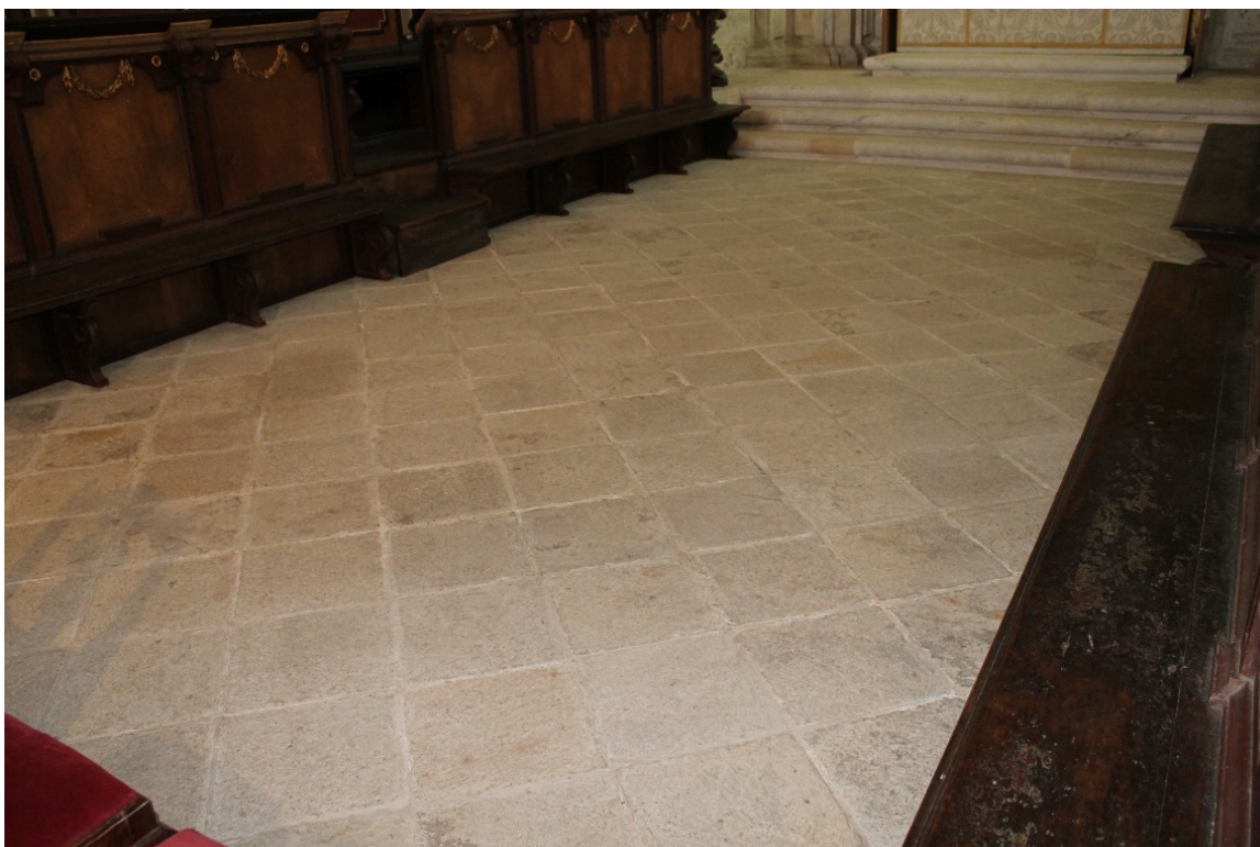
Figura 60 – Perspetiva geral do pavimento da capela-mor.
