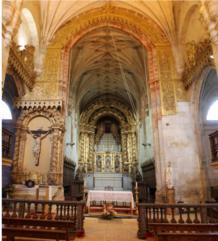
Figura 87 – Perspetiva geral da parede nascente do espaço do cruzeiro.
