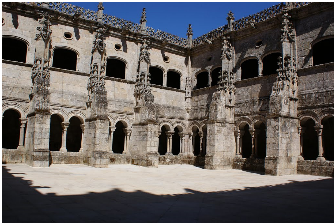
Figura 40 – “Claustro dos Bispos” do Mosteiro de San Esteban de Ribas de Sil (Nogueira de Ramuín).
