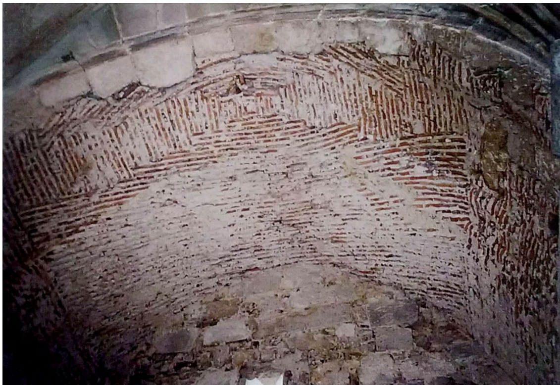
Figura 95 - Abóbada do prolongamento da capela norte do transepto. 131
