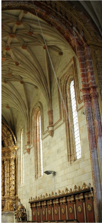
Figura 61 – Perspetiva geral da parede lateral norte da capela-mor.
