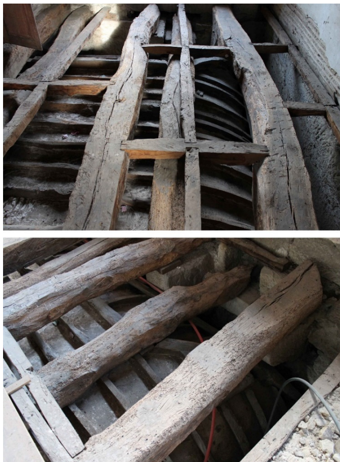
Figura 149 - Pormenores da estrutura do teto da sacristia e do vigamento do pavimento do dormitório.
