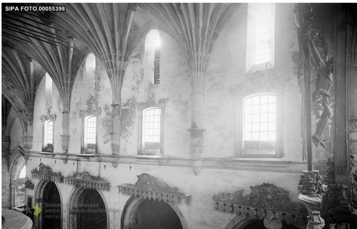
Figura 119 - Registo fotográfico do interior da igreja antes da intervenção da DGEMN na década de 40 do século XX com as janelas edificadas no século XVIII. Fonte: monumentos.pt / CC BY-NC-ND-3.0.
