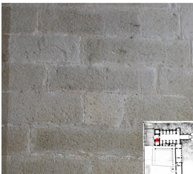
Figura 169 - Pormenor de silhares em granito leucocrático com variação cromática, localizados no paramento norte da torre sul.
