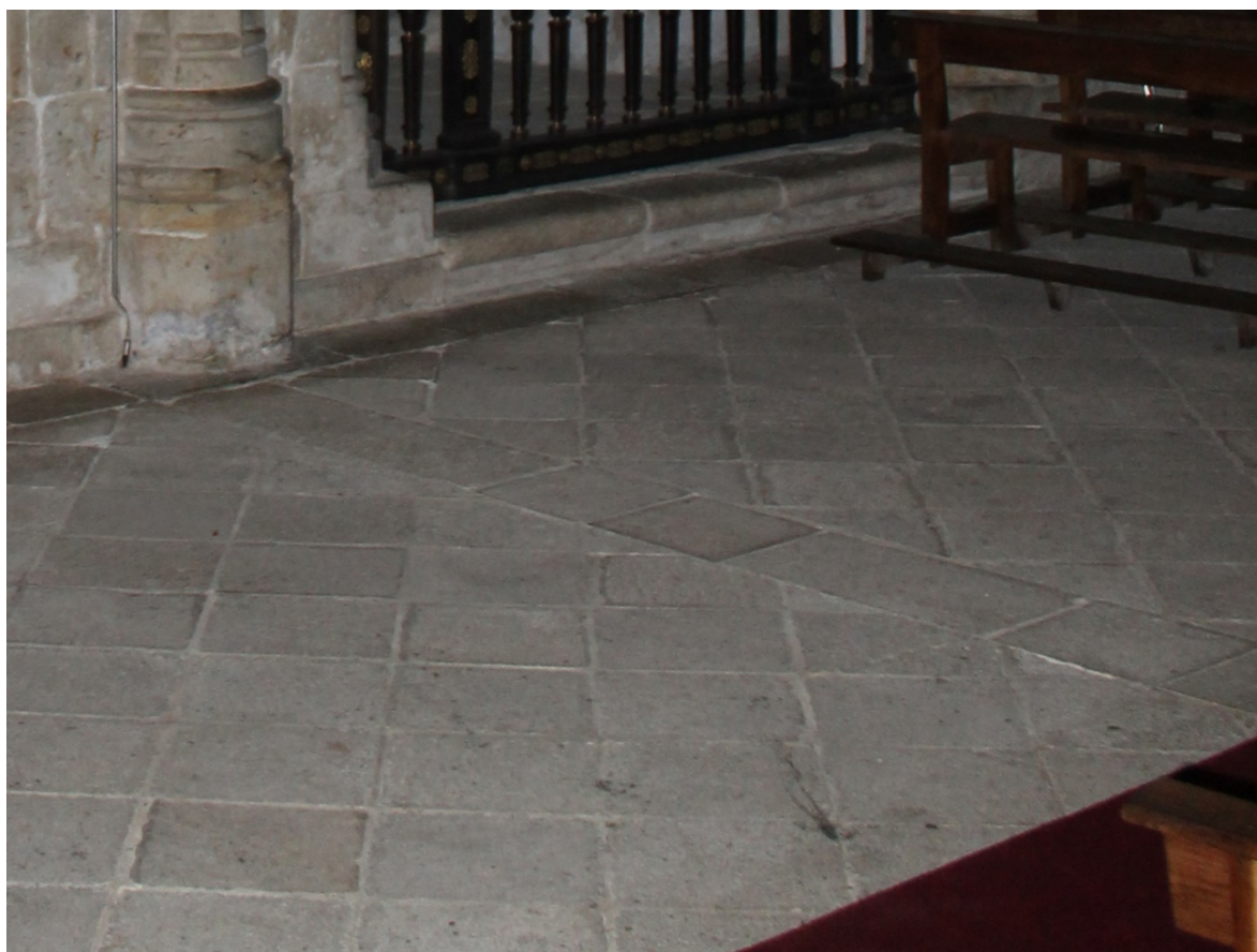
Figura 112 - Pavimento da nave (A-3-4).
