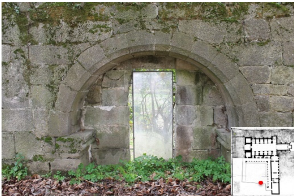
Figura 172 - Pormenor do arcossólio localizado na parede sul do claustro sul, constituído por silhares em granito biotítico.
