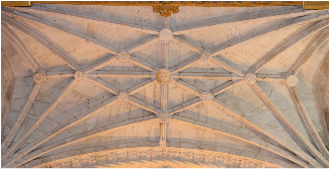
Figura 94 - Pormenor da abóbada do cruzeiro.
