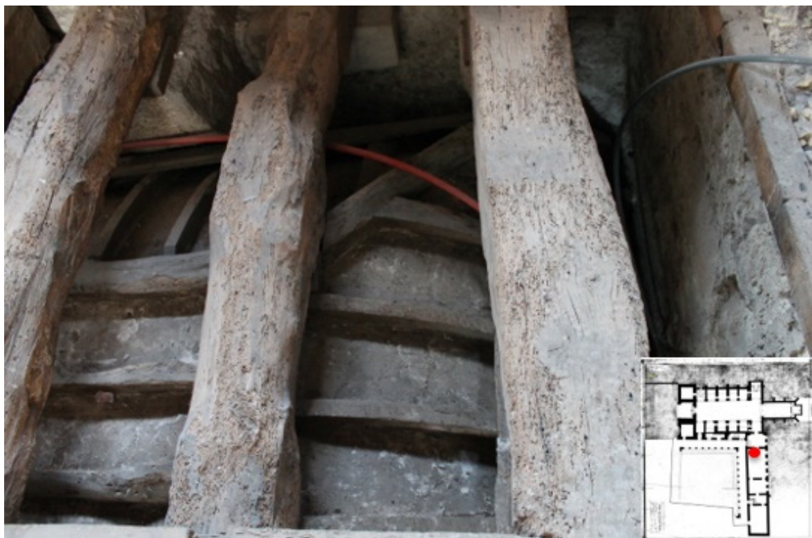
Figura 179 – Pormenor do tipo de vigas em tronco afeiçoado do pavimento da parte norte do piso superior da ala este do claustro sul.
