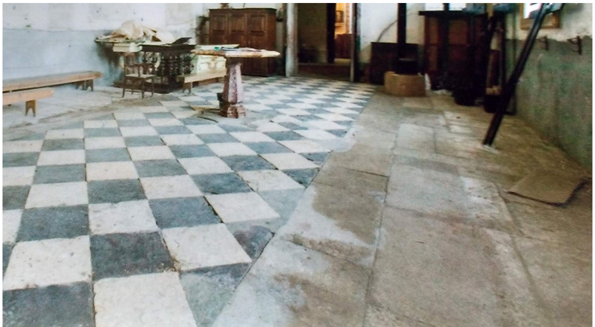
Figura 144 - Pormenor do pavimento da sacristia. Fotografia de Inês d'Orey cedida pela DRCN.
