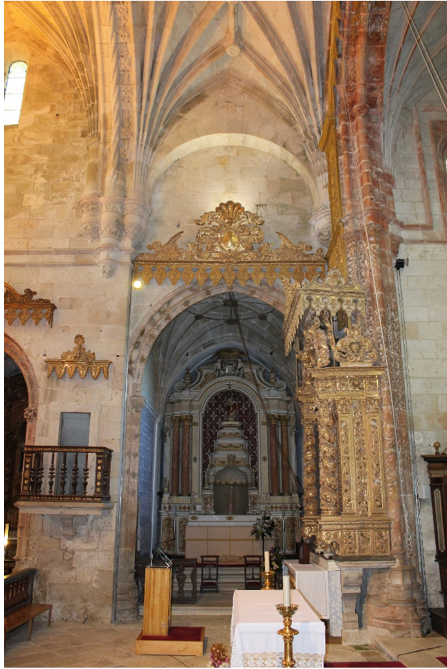
Figura 90 – Perspetiva geral da capela do braço norte do transepto.
