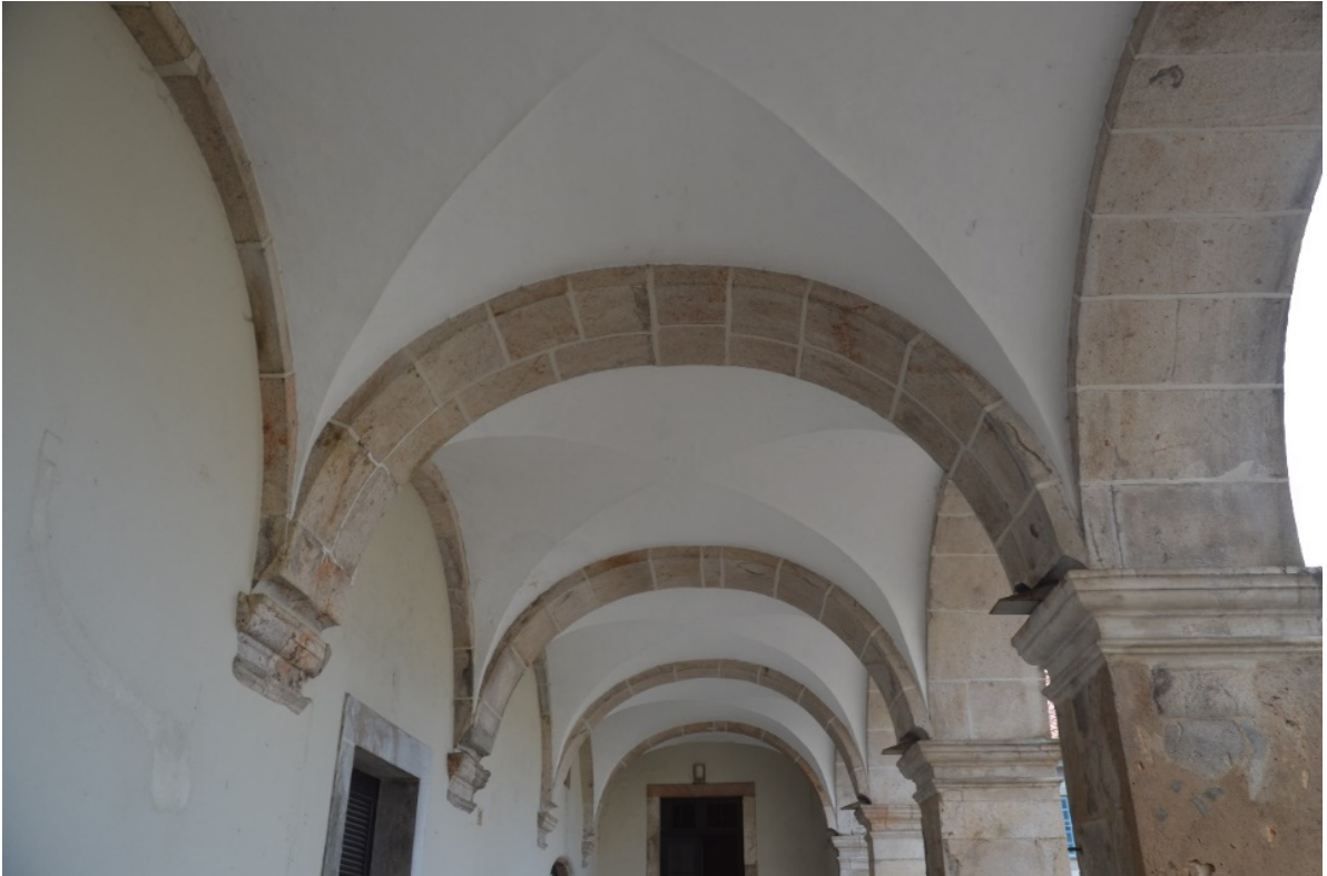
Figura 160 - Pormenor das abóbadas da galeria térrea da ala nascente do claustro. Fotografia cedida por João Ribeiro.
