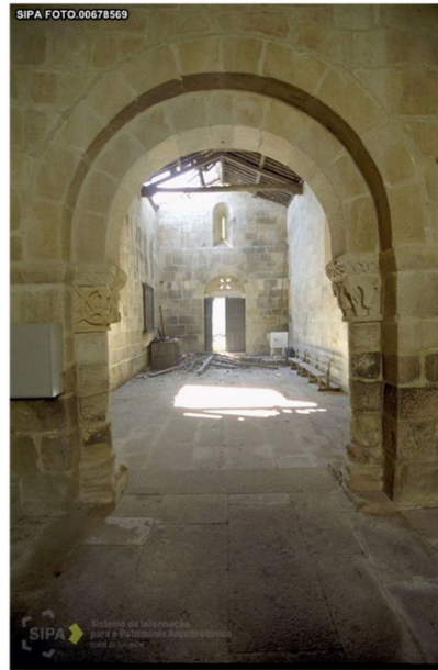
(vista do interior)
