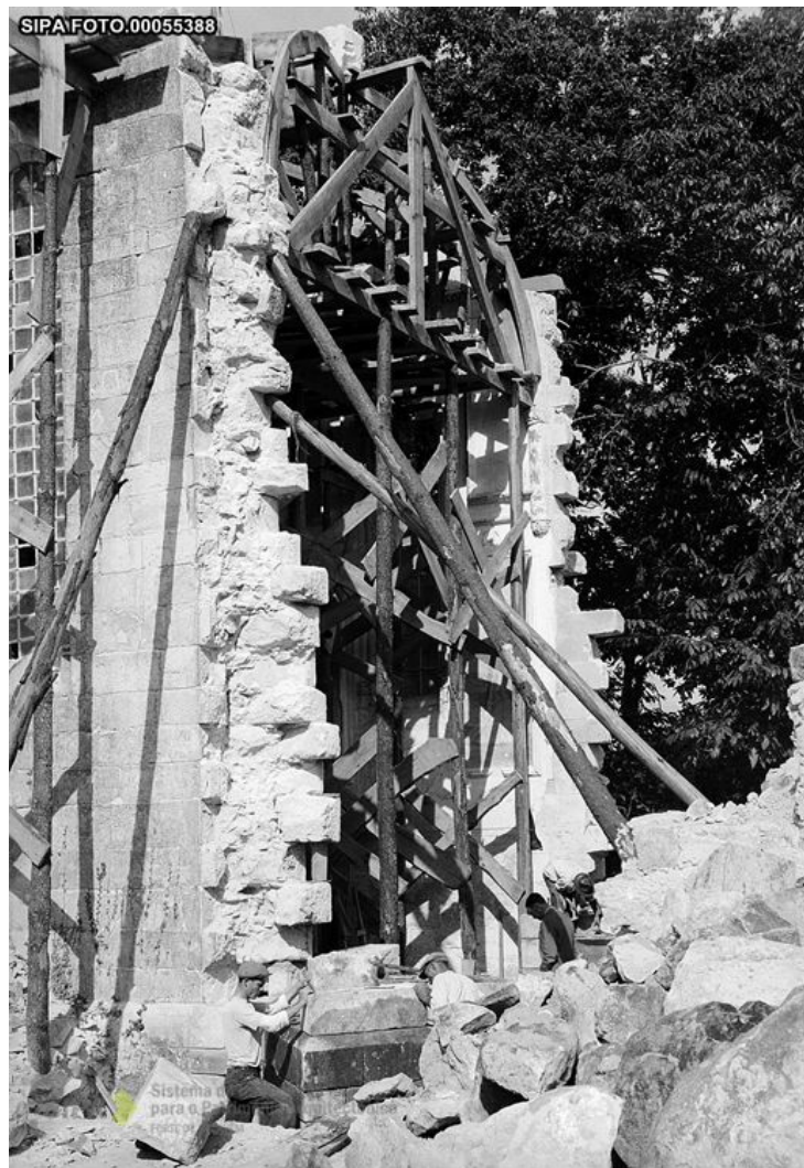
Figura 67 - Colocação dos cimbres no decurso do processo de remontagem da abóbada pela DGEMN entre 1941 e 1945. Fonte: monumentos.pt / CC BY-NC-ND-3.0.
