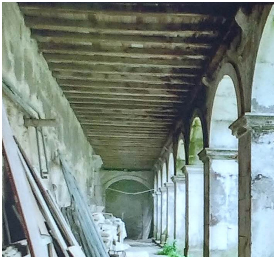
Figura 148 - pormenor do vigeamento do piso da galeria superior da ala nascente, visto da galeria inferior. Fotografia de Inês d'Orey cedida pela DRCN.
