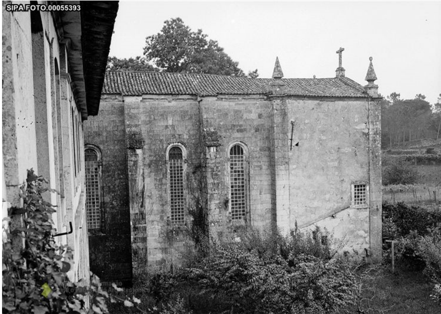
Figura 56 - Fotografia da capela-mor anterior à intervenção da DGEMN com o prolongamento de 1697 em evidência. Fonte: monumentos.pt / CC BY-NC-ND-3.0.
