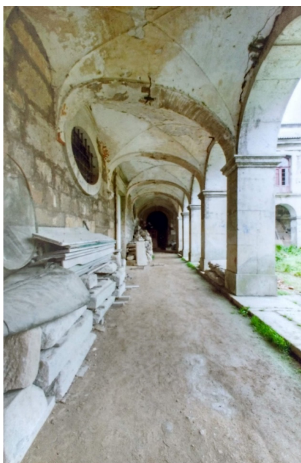
Figura 133 - Pormenor do aparelho da parede interior da galeria térrea da ala sul do claustro. Fotografia de Inês d'Orey cedida pela DRCN.
