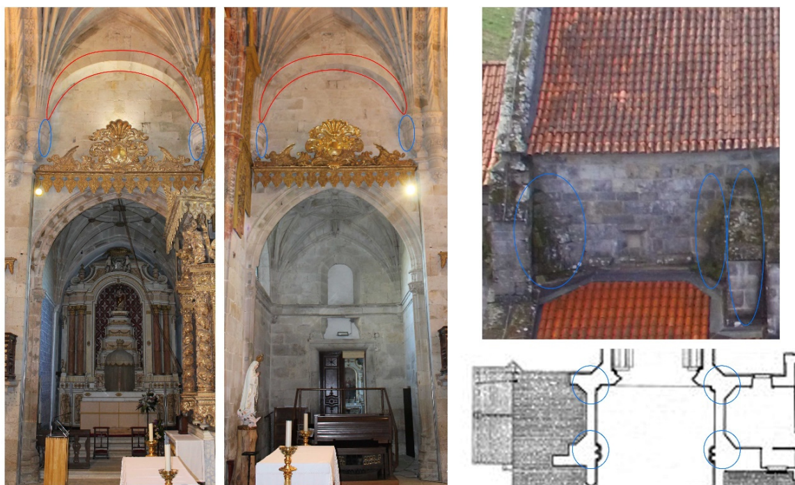
Figura 92 - Elementos de carga das paredes do cruzeiro (vermelho: arco de escação; azul: mísulas e contrafortes).
