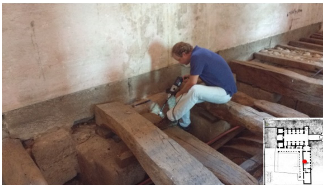
Figura 177 – Procedimento de recolha de amostras com broca oca para análises dendrocronológicas no piso superior da ala este do claustro sul.
