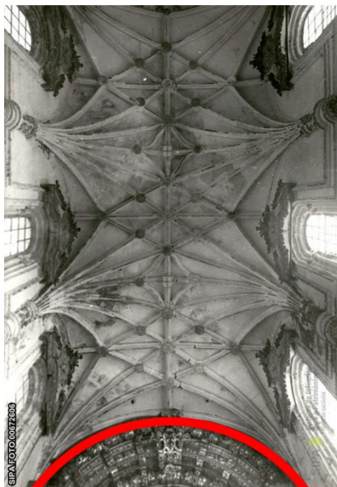
Figura 77 - Foto da parte interior da abóbada antes da intervenção de 1941-1945. Fonte: monumentos.pt / CC BY-NC-ND-3.0.
