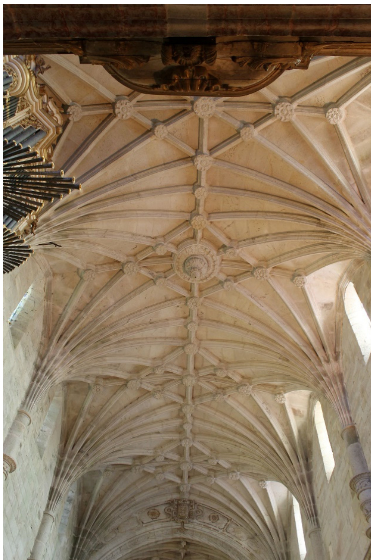
Figura 115 – Perspetiva geral da abóbada da nave (A-3-5).
