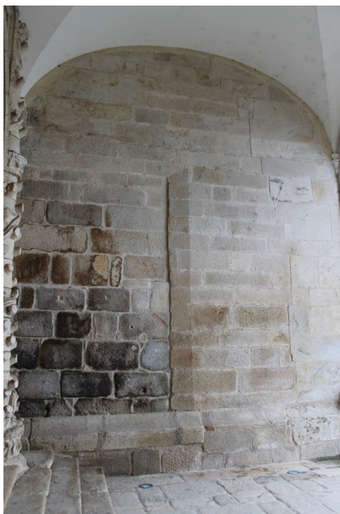
Figura 33 - Paramento norte da torre sul do Convento de Vilar de Frades (Barcelos). Parte deste paramento poderá corresponder à estrutura românica.
