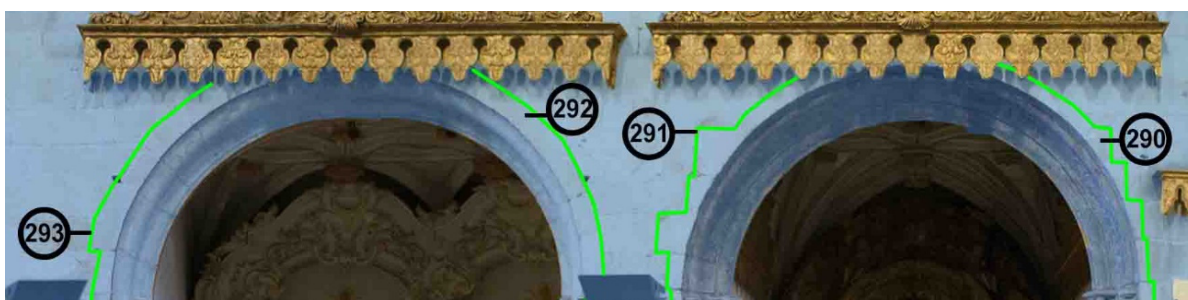
Figura 116 - Pormenor da forma de integração dos arcos das capelas laterais com o paramento.
