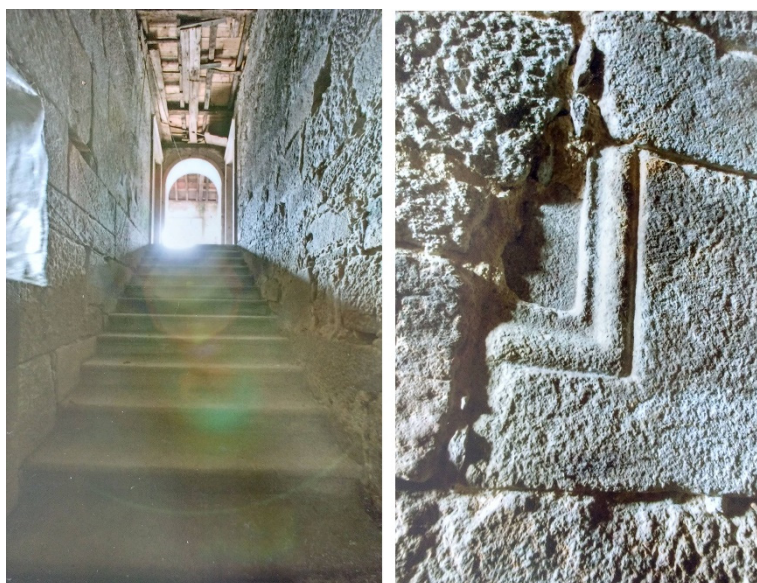
Figura 154 - Pormenor de elementos construtivos reutilizados na parede da escadaria sul da ala nascente. Fotografia de Inês d'Orey cedida pela DRCN.
