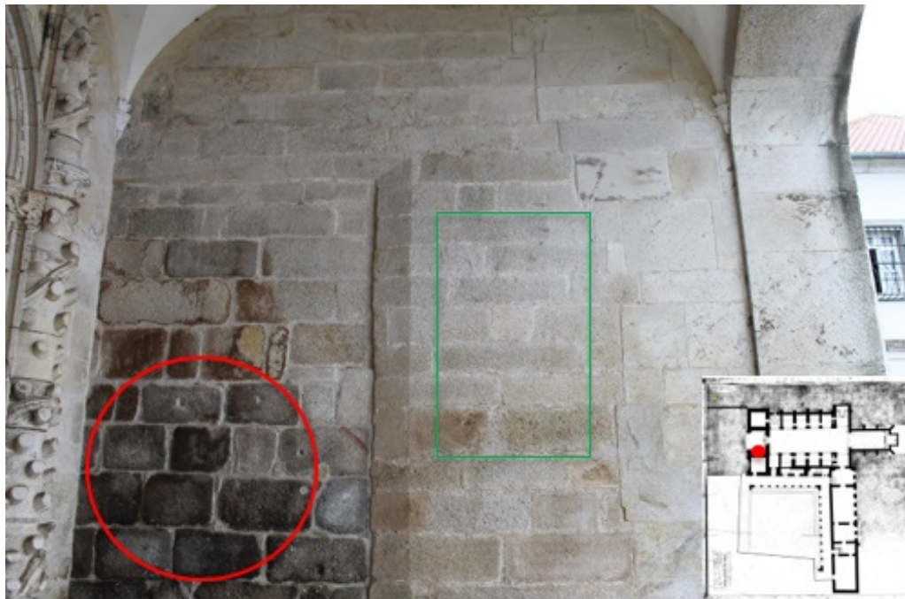
Figura 171 - Pormenores do alçado norte da torre sul da igreja, onde foi possível identificar a presença de granito biotítico (a vermelho) e granito leucocrático (a verde) no mesmo paramento.
