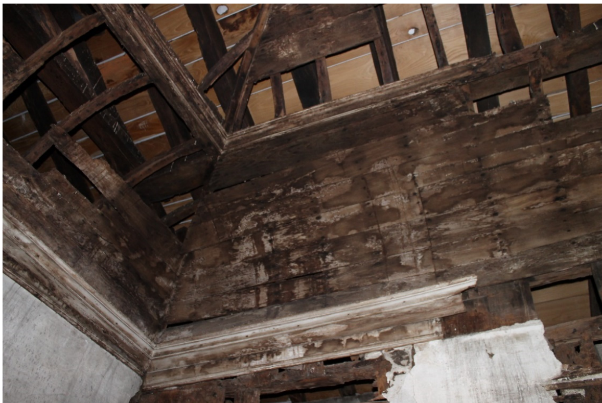
Figura 146 - Pormenor do teto em madeira com estrutura em ferro da capela do dormitório da ala nascente do claustro.
