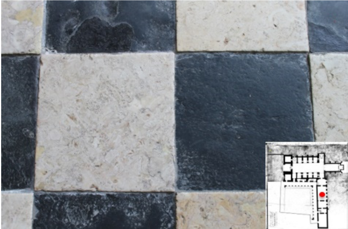
Figura 173 - Pormenor do pavimento central da sacristia exibindo um “xadrez” de lajes regulares em lioz (calcário) e ardósia (xisto).
