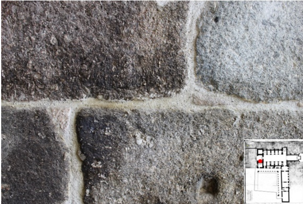
Figura 170 - Pormenor da constituição do aparelho de uma porta entaipada com silhares em granito biotítico de duas micas com feldspato, localizada no paramento norte da torre sul.
