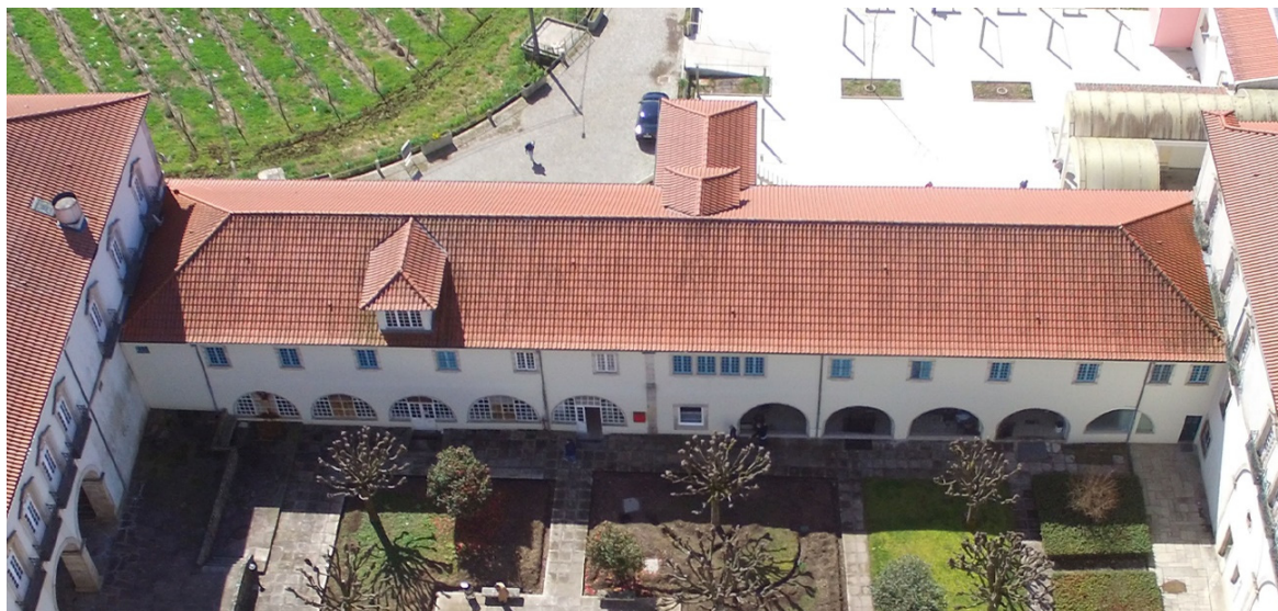
Figura 164 - Fachada norte da ala sul do claustro sudoeste. Fotografia cedida por João Ribeiro.
