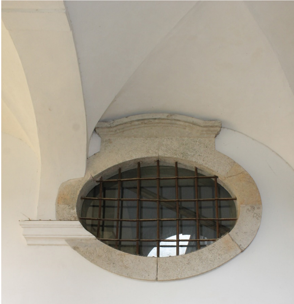
Figura 137 - Pormenor da solução de adaptação do arco abatido do teto com um dos óculos da parede interior da galeria térrea da ala sul do claustro.
