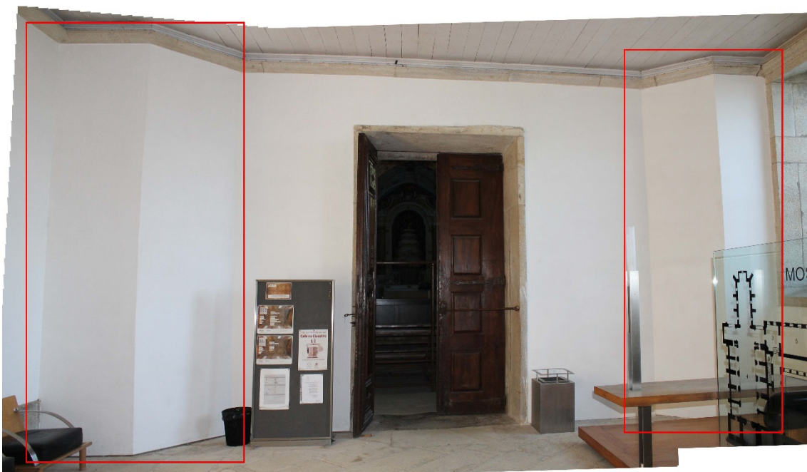
Figura 102 – Pormenor da localização dos contrafortes diagonais da capela sul, fossilizados pela estrutura do claustro dos finais do século XVIII.
