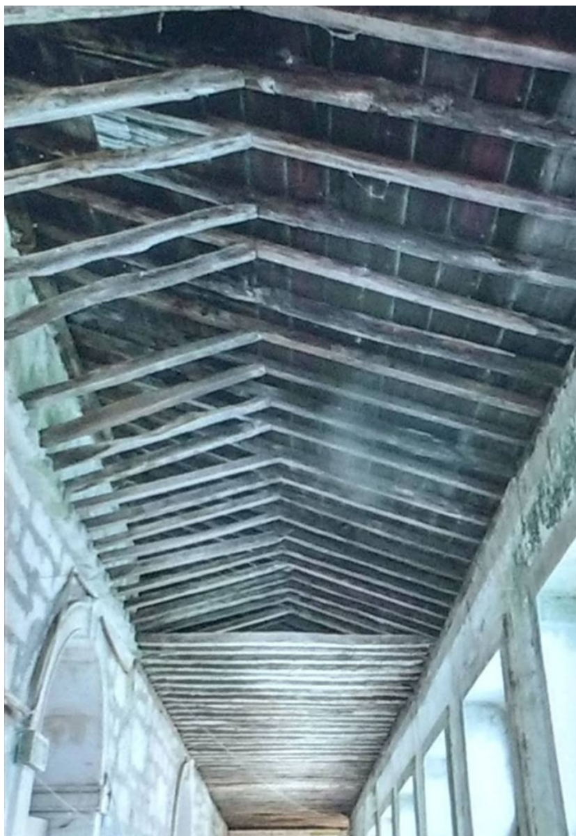
Figura 138 - Pormenor do vigamento e armação do telhado antes da última intervenção de conservação. Fotografia de Inês d'Orey cedida pela DRCN.
