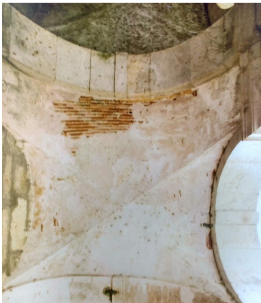
Figura 134 - Pormenor da abóbada de aresta de tijolo da galeria térrea da ala norte do claustro. Fotografia de Inês d'Orey cedida pela DRCN.
