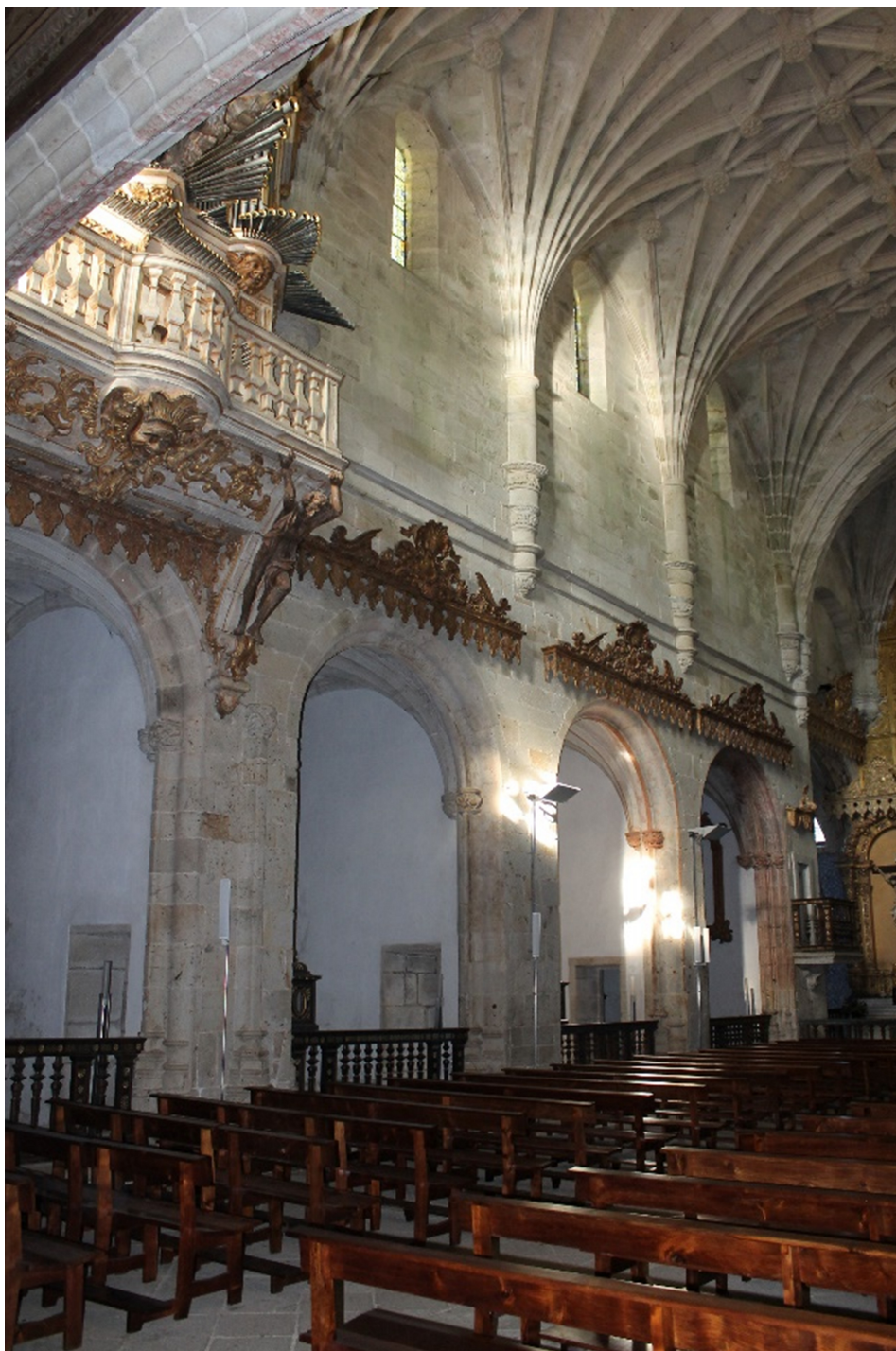
Figura 111 - Perspetiva geral do alçado sul da parede norte da nave (A-3-1).
