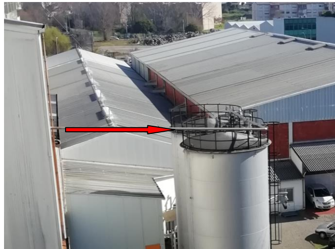
Figura 33 - Imagem aérea dos tanques de melaço (assinalada tubagem de saída do melaço da refinaria).
