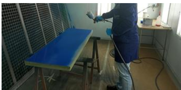
Figura 10* - Aplicação da pintura final.
