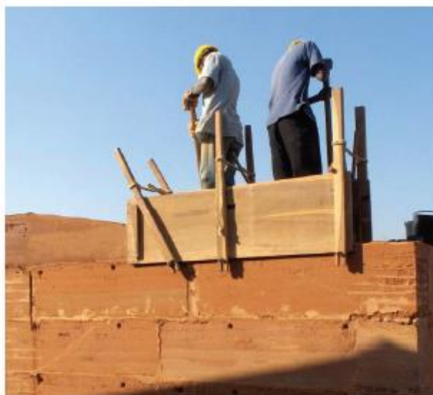
Figura 8: Construção em taipa tradicional, Mumemo, Moçambique [45]
