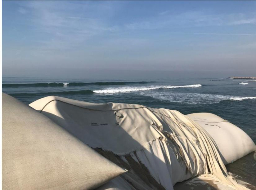
Figura 2-21 Exemplo de rotura dos geossintéticos, praia de Ofir.
