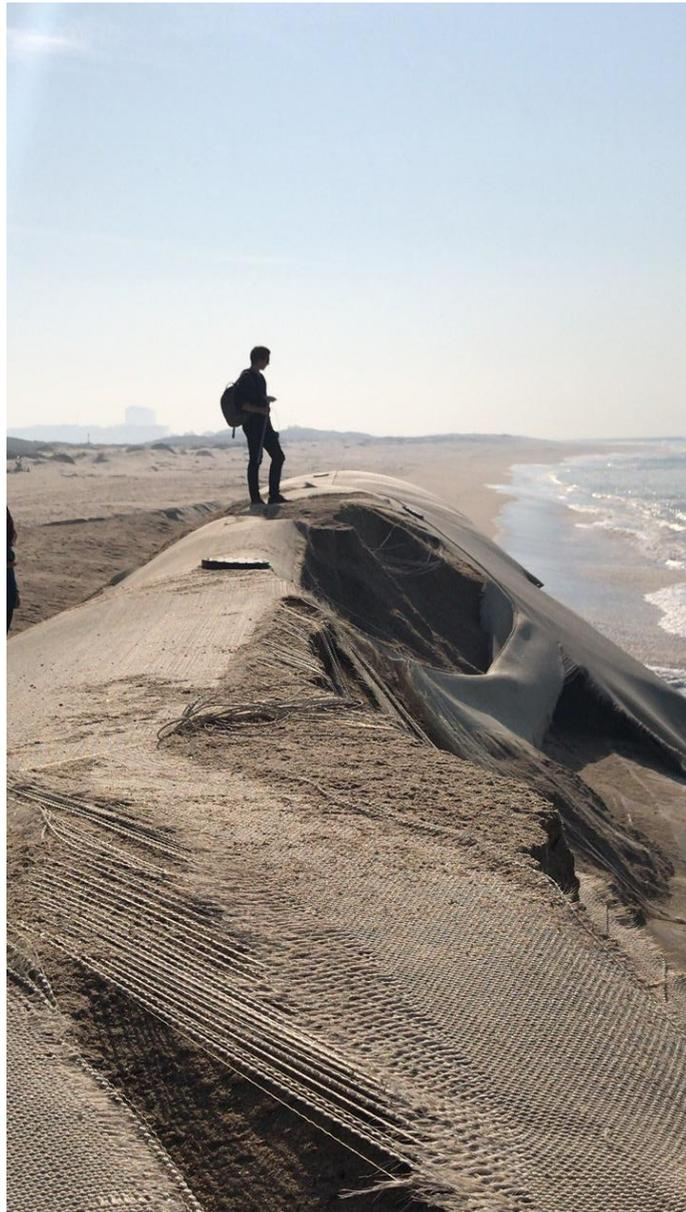
Figura 2-20 Exemplo de rotura dos geossintéticos, praia de Ofir.
