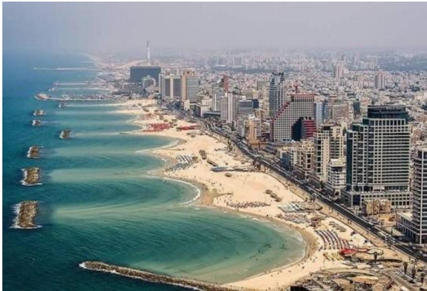
Figura 2-17 Exemplo de quebra-mar destacado ligado à costa (Lopes, 2018).
