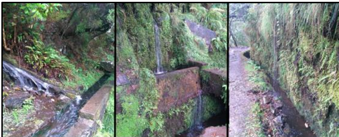
Figura 4. Galerias de captação nas duas primeiras imagens e águas de escorrência das vertentes, na terceira, constituem um reforço contínuo das águas para as levadas ao longo das vertentes. Fonte: elaborado pelo autor.
