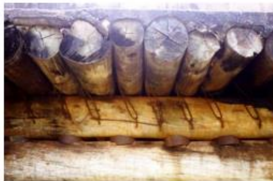
Figura 59 - Madeira Maciça (peças roliças). Fonte: Manual de Projeto e Construção de Pontes de Madeira
