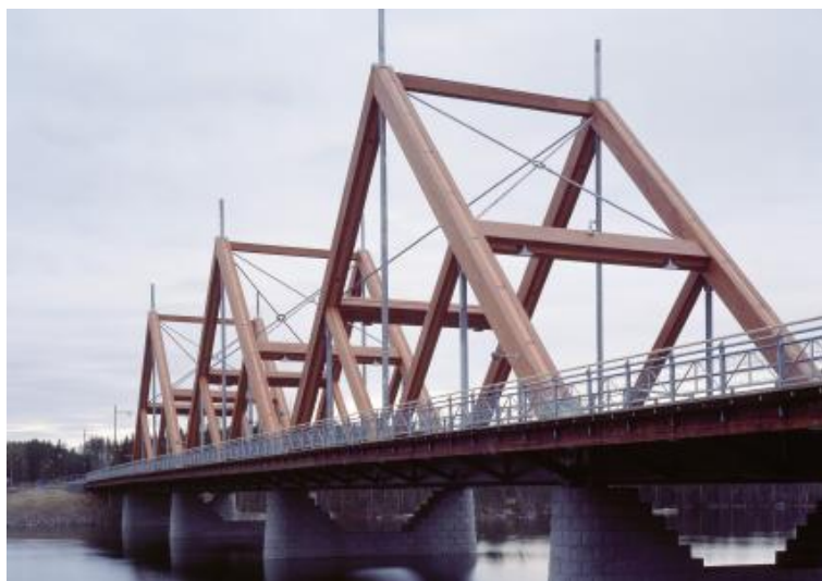
Figura 13 - Ponte VIHANTASALMI, Mantyharju, Finlândia. Fonte: http://www.woodarchitecture.fi/projects/vihantasalmi-bridge
