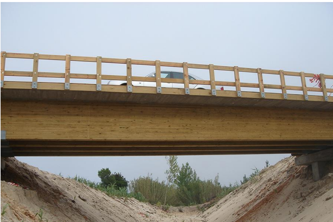
Figura 26 - Ponte Quiaios, Portugal. Fonte: http://www.jular.pt/empresa/referencias/referencias-construcoes-especiais/ponte-quiaios-figueira-da-foz
