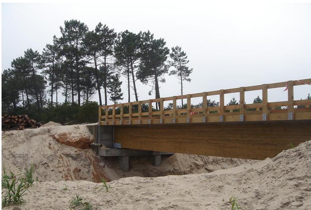
Figura 24 - Ponte Quiaios, Portugal. Fonte: http://www.jular.pt/empresa/referencias/referencias-construcoes-especiais/ponte-quiaios-figueira-da-foz
