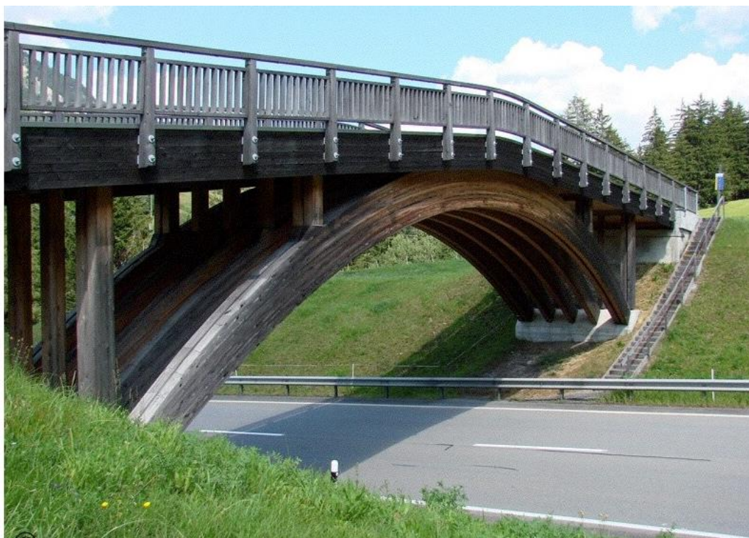
Figura 17 - Ponte Rodoviária – Cumpognabrucke, Tiefencastel, Suíça. Fonte: http://www.swiss-timber-bridges.ch/detail/436
