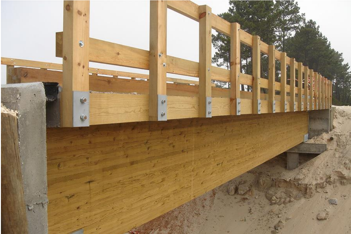
Figura 25 - Ponte Quiaios, Portugal. Fonte: http://www.jular.pt/empresa/referencias/referencias-construcoes-especiais/ponte-quiaios-figueira-da-foz
