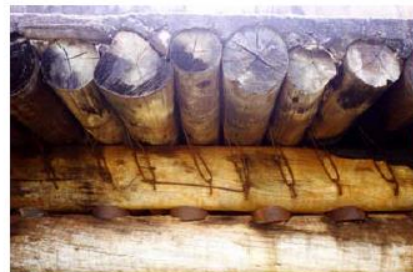
Figura 44 - Tabuleiros compostos de peças roliças de madeira e betão. Fonte: Manual de Projeto e Construção de Pontes de Madeira
