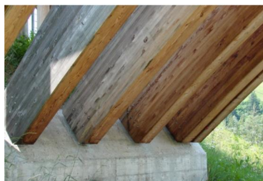
Figura 19 - Ponte Cumpognabrucke (Arcos). Fonte: http://www.swiss-timber-bridges.ch/detail/436
