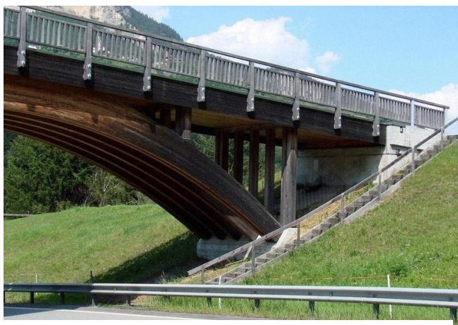
Figura 18 - Ponte Cumpognabrucke. Fonte: http://www.swiss-timber-bridges.ch/detail/436
