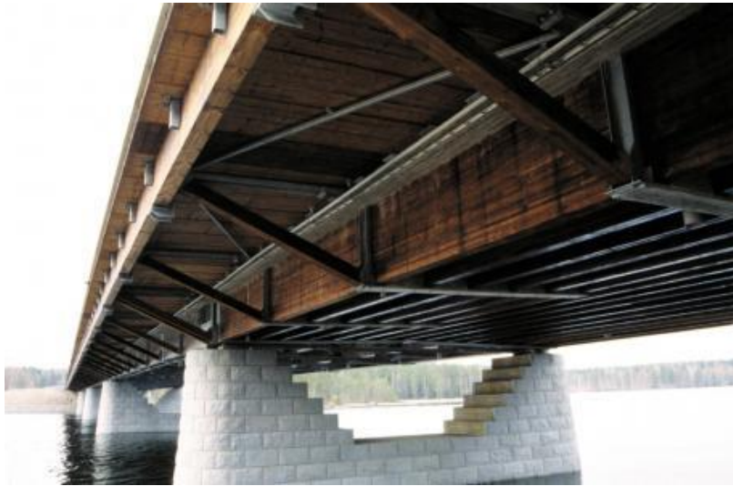
Figura 14 - Ponte VIHANTASALMI (parte inferior) Fonte: http://www.woodarchitecture.fi
