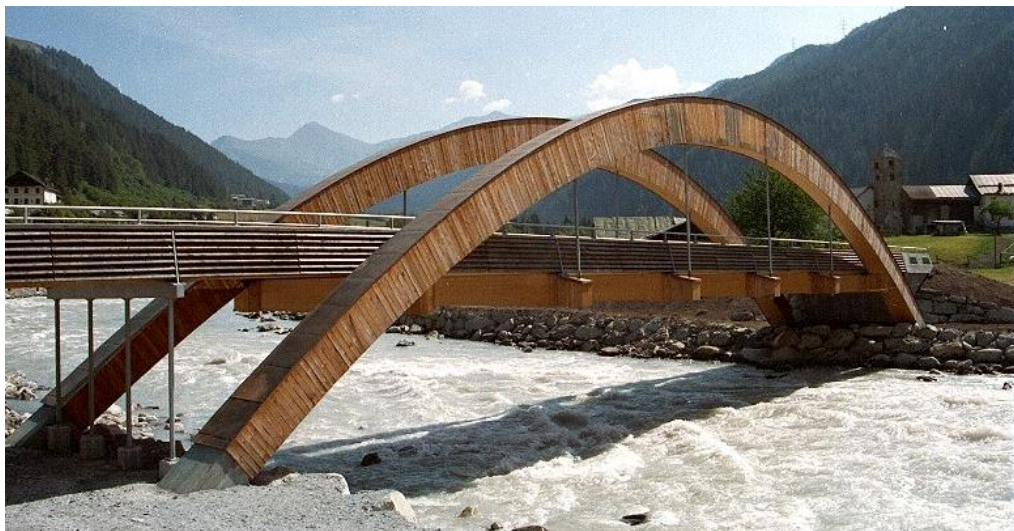
Figura 15 - Ponte Rodoviária - SAN NICLA, Tschlin, Suíça. Fonte: http://www.swiss-timber-bridges.ch
