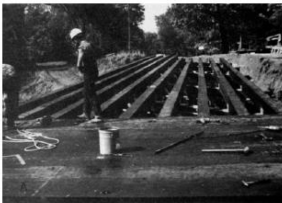
Figura 40 - Exemplos representativos de tabuleiros de madeira laminada colada. Fonte: Manual de Projeto e Construção de Pontes de Madeira
