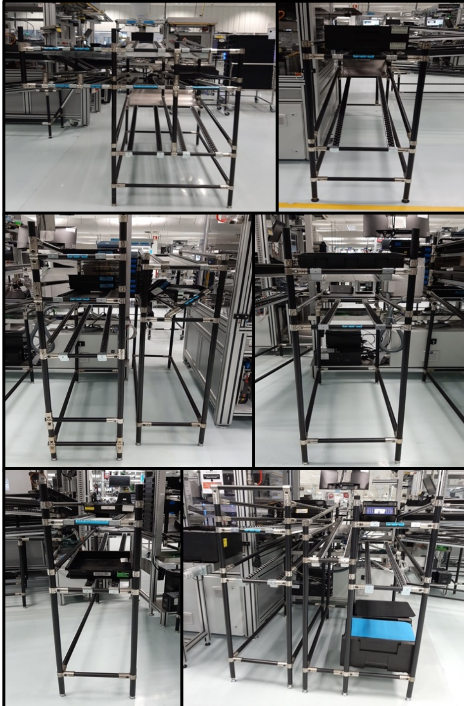
Figura 70 - Rampas de abastecimento instaladas na linha de montagem
