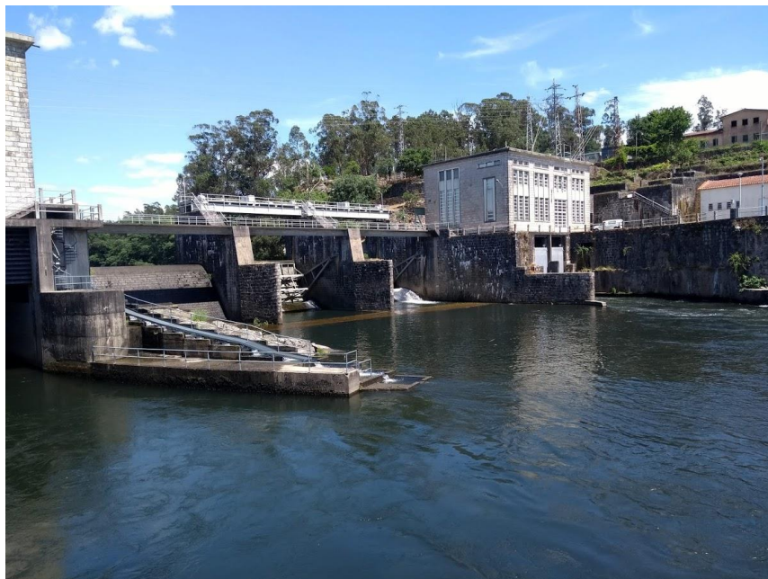
Figura 4 - Barragem de Penide vista de jusante
