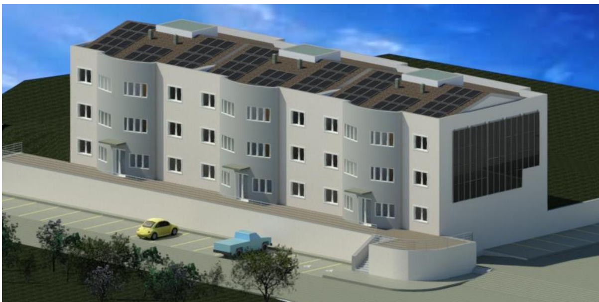
Figura 32 – Disposição dos coletores solares térmicos na fachada (sudeste) e dos painéis fotovoltaicos na cobertura (sudoeste)
