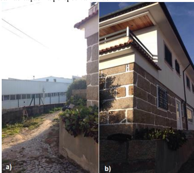
Figura 38 - Localização do Ponto 4: a) sonómetro instalado junto à habitação com o número de polícia 1185; b) essa habitação na perspetiva da fábrica
