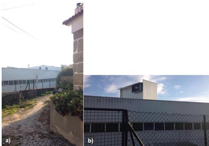
Figura 39 - Localização do Ponto 4: a) com sonómetro instalado junto à indústria; b) parte de trás da fábrica
