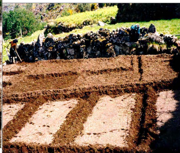
Foto 6 – Um talheiro concluído e outro em construção
