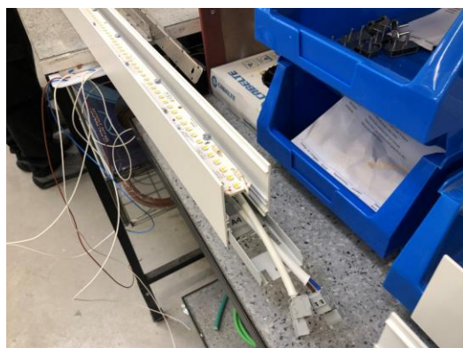
Figura 190 – Colocação de régua eletrificada
