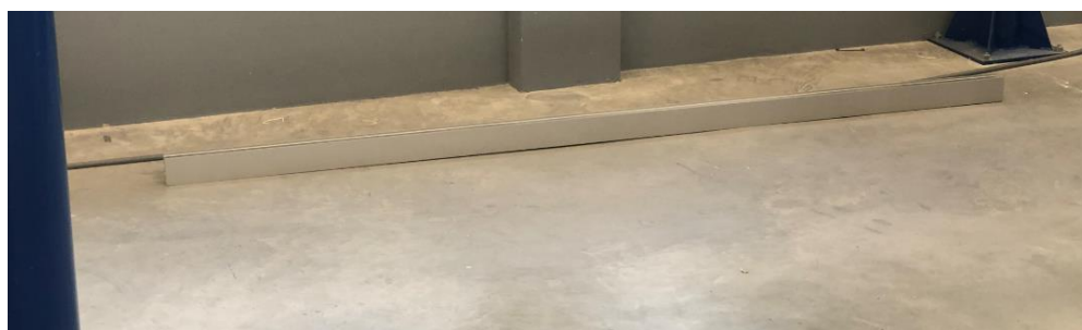
Figura 209 – Perfil no chão durante a pintura
