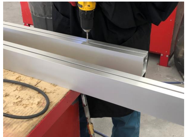
Figura 170 - Furação manual para furos de fixação
