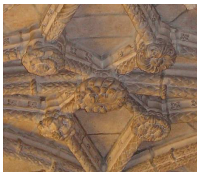
Figura 4.19 – Exemplo das chaves de pedra na zona central da abóbada.
