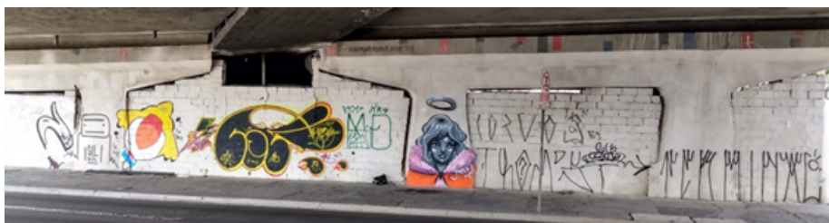
Figura 8: Parte inferior de viaduto próximo à Avenida Consolação, centro, 14 de Setembro de 2019
