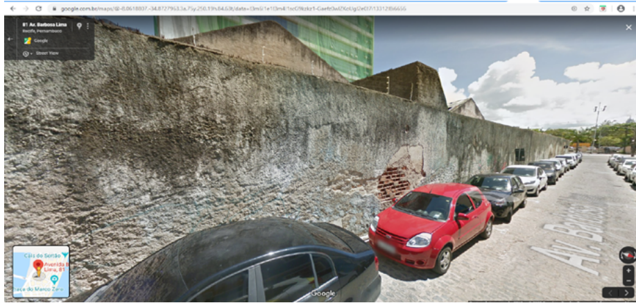
Figura 2: Rua Barbosa Lima, n. 81. Conjunto tombado do Bairro do Recife
