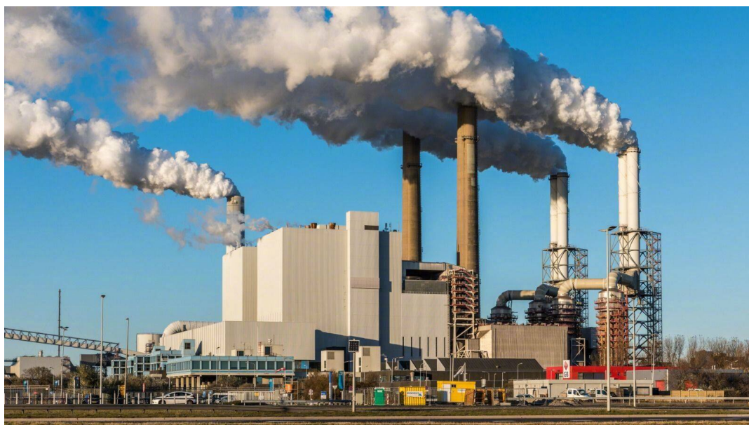
Figura 10 - Fábrica após a purificação e transformação dos gases de combustão. 219
