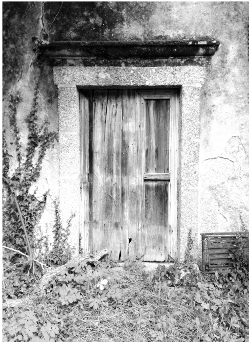
Fig. 83. Porta de entrada na Capela de São Miguel na fachada principal (Oeste)
