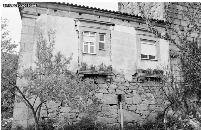
Fig. 93. Janelas de sacada alteradas na fachada do corpo residencial adossado à Torre de Dornelas no séc. XVIII (Retirado de: www.monumentos.gov.pt )
