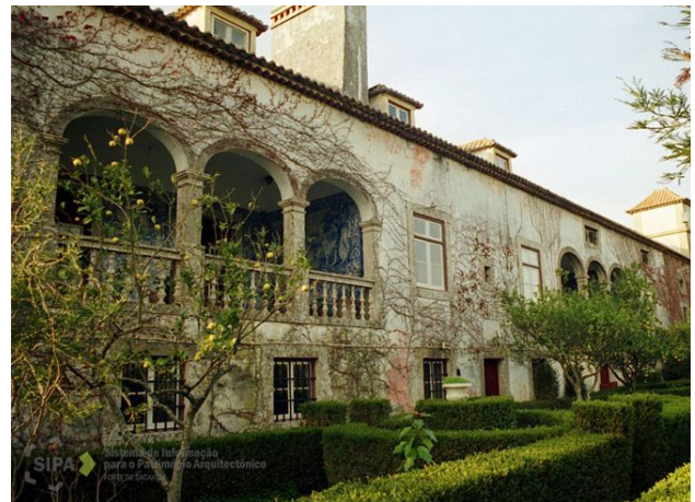
Fig. 97. Vista das traseiras da Casa da Quinta do Molha Pão em Sintra (Retirado de: www.monumentos.gov.pt/Site/APP_PagesUser/SIPA.aspx?id=6098 )
