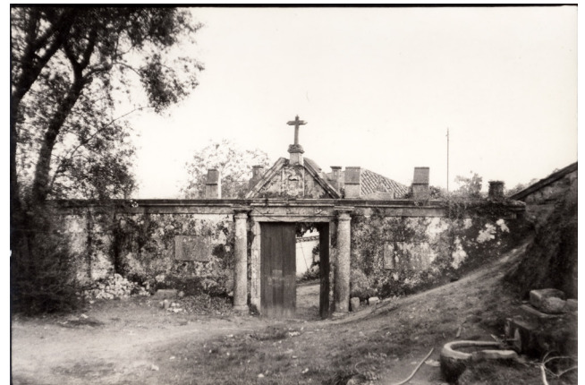
Fig. 116. Portal de Entrada
