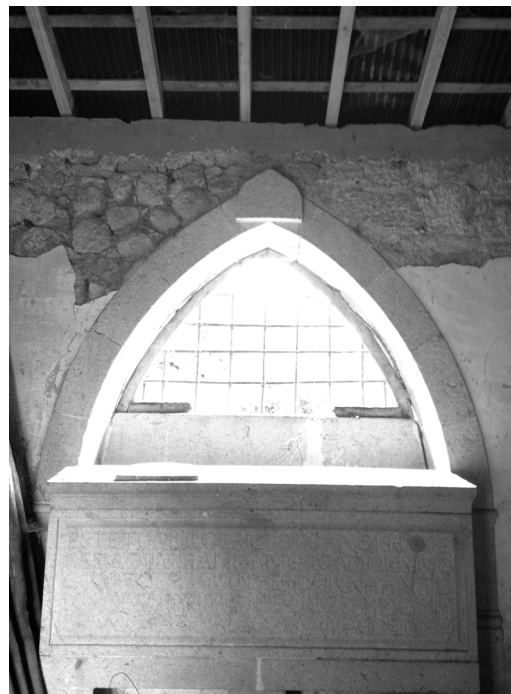
Fig. 86. Janela em arco quebrado na fachada Norte da Capela
