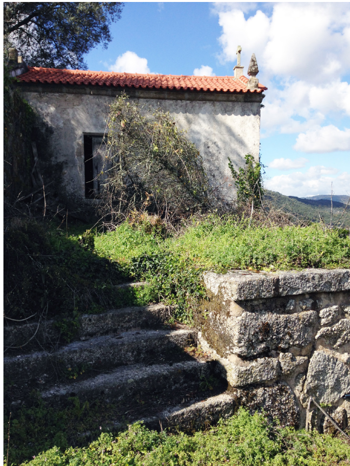
Fig. 36. Escadas de acesso ao patamar da Capela, para a entrada lateral
