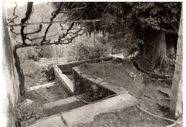
Fig. 126. Vista de cima das escadas para a cota inferior
