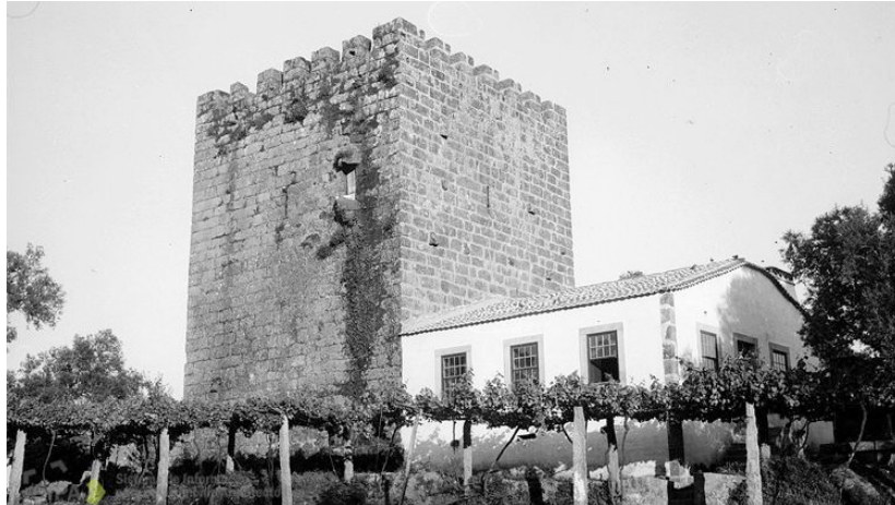
Fig. 62. Torre de Refios e o corpo residencial (Retirado de: http://www.monumentos.gov.pt )
