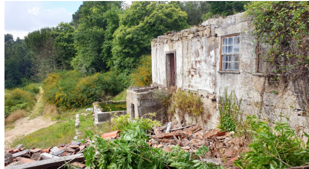
Vista do interior do piso superior da Casa (Vão P4) para Oeste
