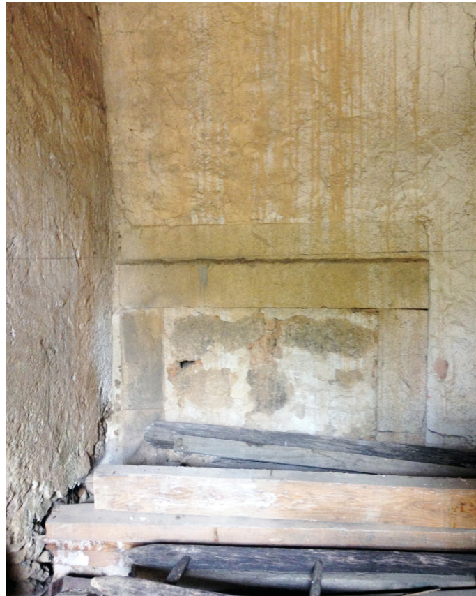
Fig. 40. Porta encerrada entre o V3 e a Casa.
