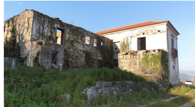
Vista das traseiras da Casa
