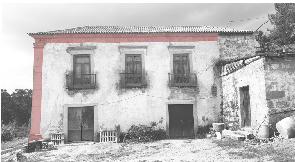
Fig. 82. Fachada principal (Alçado Nordeste) evidenciando o cunhal empilastrado com capitel a demarcar o volume a sudeste e o friso e cornija a rematar o volume.
