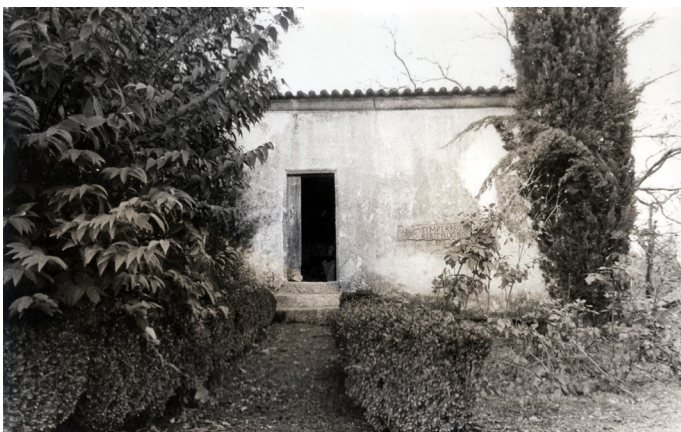
Fig. 117. Entrada lateral da Capela, na fachada Sul
