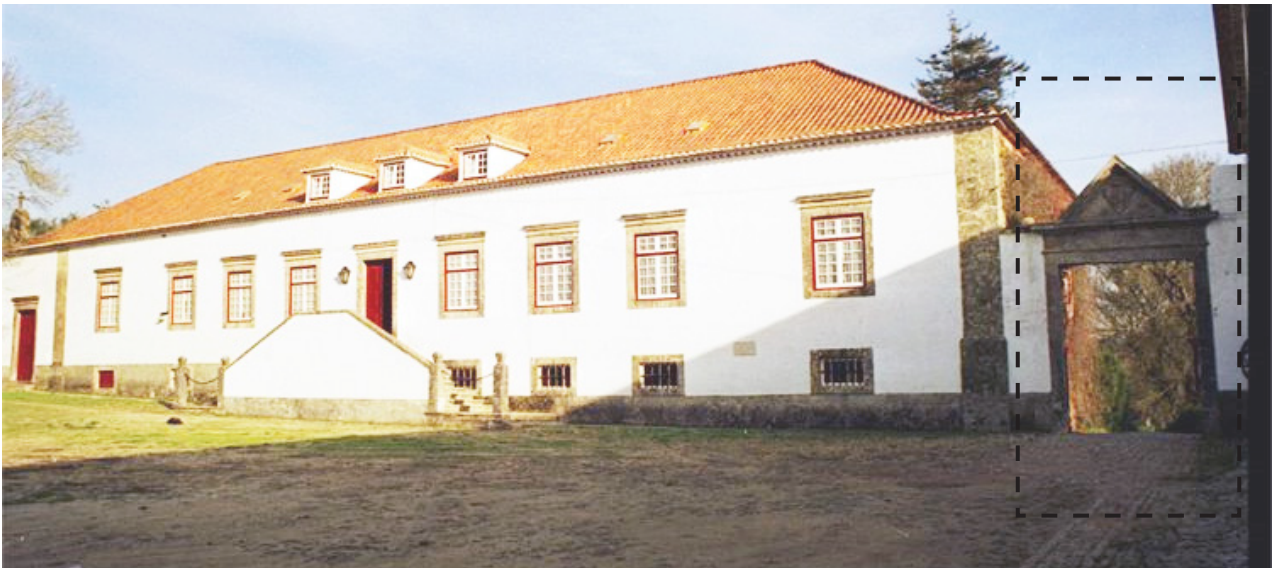
Fig. 95. Fachada principal da Quinta do Molha Pão em Sintra com a identificação do Portal de entrada, à direita. (Retirado de: http://www.monumentos.gov.pt/Site/APP_PagesUser/SIPA.aspx?id=6098 )
