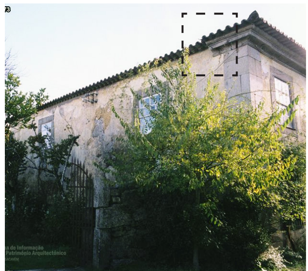
Fig. 99. Pormenor da fachada lateral da Casa de São Miguel em Viseu onde se denota a interrupção da cornija da fachada principal (Retirado de: www.monumentos.gov.pt ).
