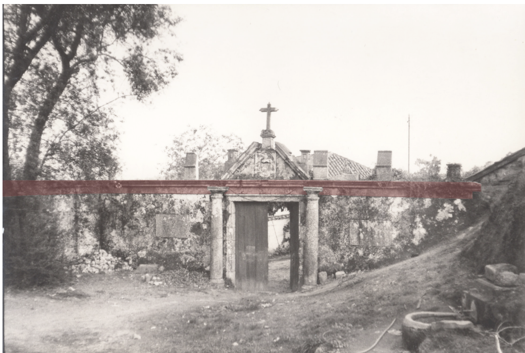
Fig. 81. Portal de São Miguel evidenciando a horizontalidade conferida pelo friso e cornija a encimar o muro (Fotografia cedida por Nuno Borges de Araújo).
