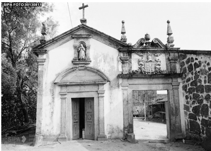
Fig. 91. Capela e Portal de entrada no conjunto edificado da Torre de Dornelas (Retirado de: www.monumentos.gov.pt )
