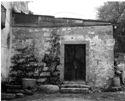
Fig. 58. Volume V3 (Fachada Sudeste)
