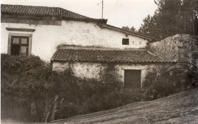
Fig. 121. Parte do Alçado Nordeste - a Casa e o V3
