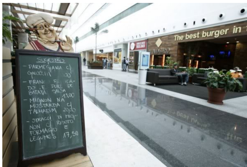
Fig.2 – Shopping cidade de Curitiba-PR. Piso sem estabilidade.
