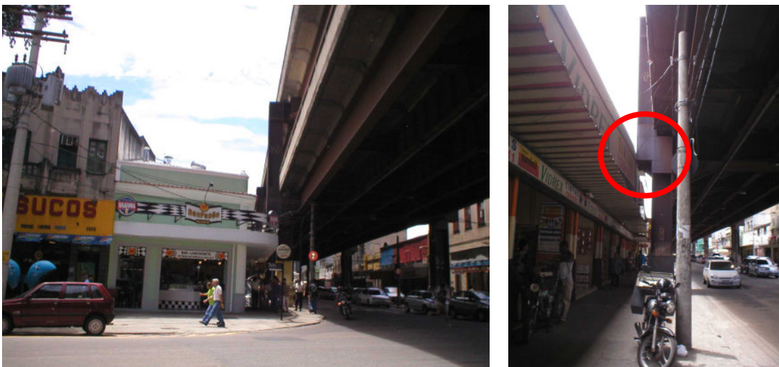
Fig. 8: À esquerda, cruzamento das Ruas Figueira de Melo e São Cristóvão. À direita, contato da estrutura do viaduto com beiral da loja.
