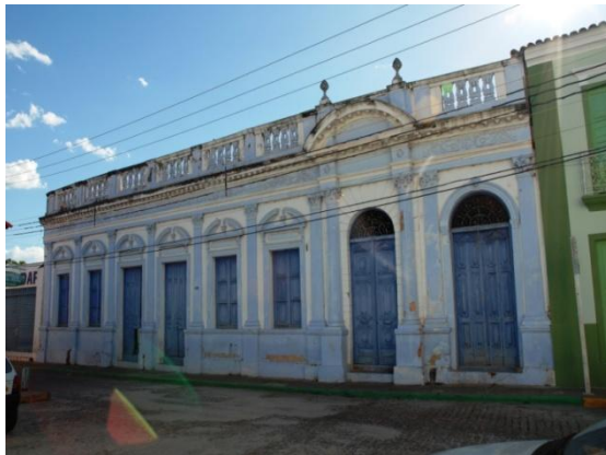
Fig. 1 Fachada da Rua 7 de Setembro
