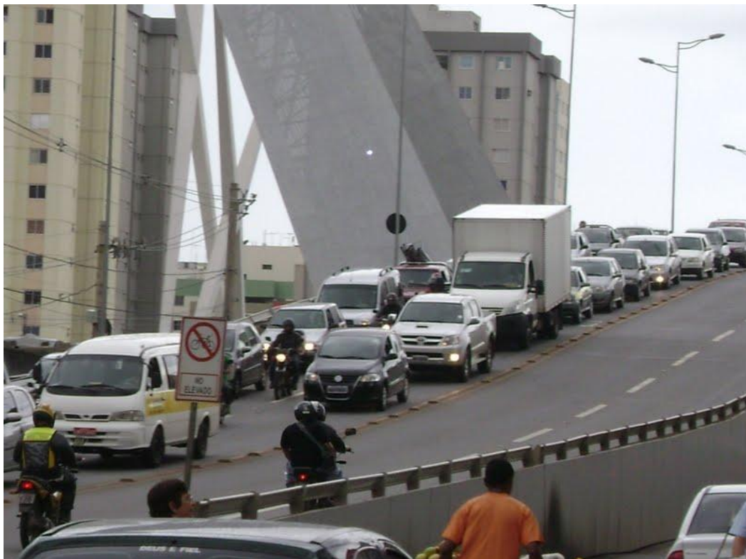
Figura 11 – Congestionamento no viaduto implantado.
