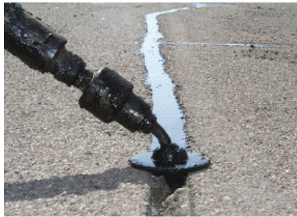
Fig. 3.1 Selagem de fendas
