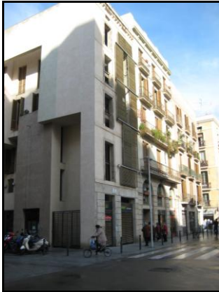
Foto 1 Fachada Rua Giralt el Pellisser Habitação de Proteção Oficial Fonte: SALCEDO, junho/ 2009
