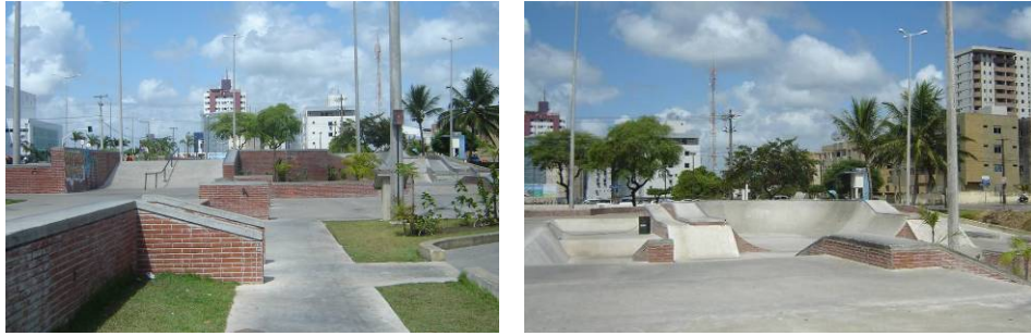
Fig. 6 e 7 Vista geral dos equipamentos urbanos do Parque.
