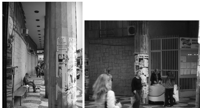
Ilustração 9 Descaracterização dos imóveis - Edifício das Diretorias Fonte: Arquivo pessoal 2009.
