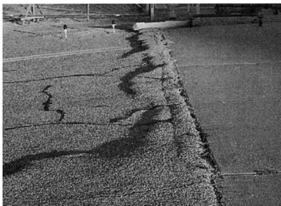
Fig. 2.2 Escorregamento lateral (Shahin, 2005)
