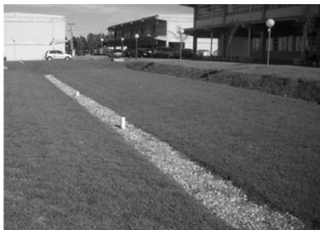
Fig.11 Trincheira de Infiltração.
