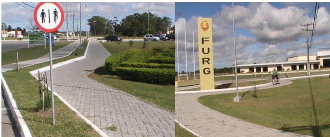
Fig. 5 – Ciclovia do campus: sinuosa, desconfortável, estreita e incoerente
