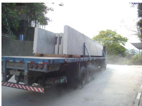
Figura 5 - Detalhe do posicionamento das peças no caminhão – Obra A
