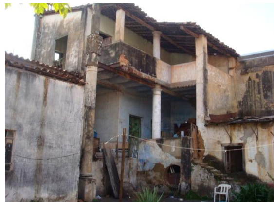
Fig. 4 Vista interna da edificação
