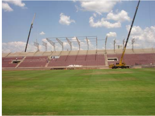
Figura 9 – Visualização dos guindastes no trecho 1 – Obra C
