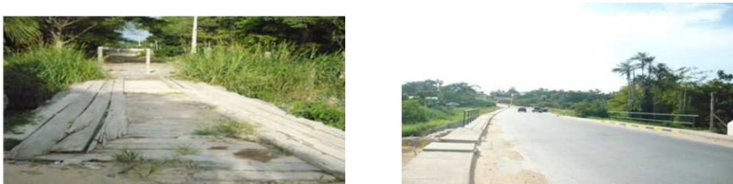
Fig. 5 e 6: Antiga e nova Ponte sobre o Igarapé do Goiabinha, respectivamente
