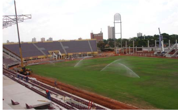
Figura 10 - Visualização dos guindastes nos trechos 1 e 2 – Obra C
