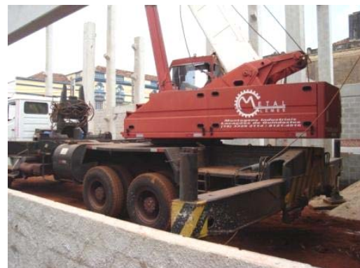
Figura 12 - Posicionamento do guindaste de montagem em canteiro restrito – Obra B
