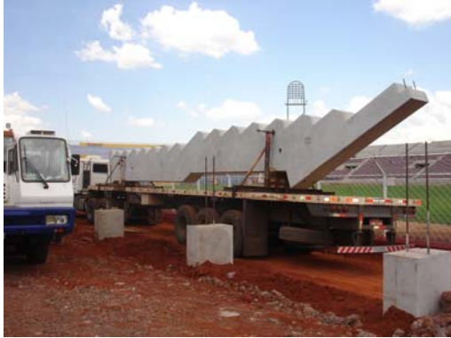
Figura 7 - Transporte e fixação da peça do estádio; localização para descarregamento – Obra C
