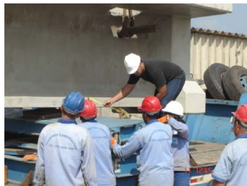
Figura 4 - Operários conferindo a distância dos apoios – Obra D
