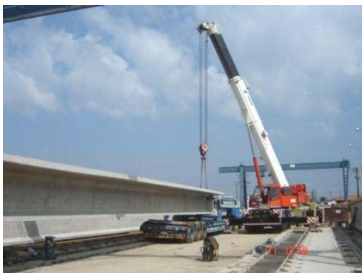
Figura 3 - Posicionamento da viga da passarela pelo guindaste durante o içamento – Obra D
