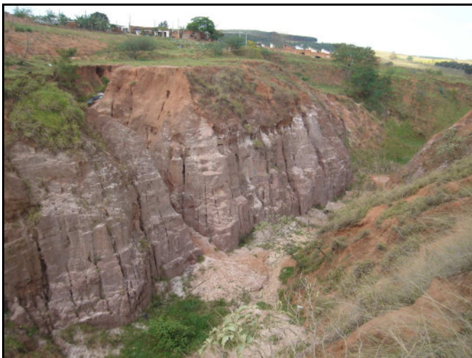
Fig. 03 – Talude erosivo com aproximadamente 25 metros de altura;
