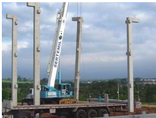
Figura 11 - Montagem do pilar com necessidade de rotação da peça – obra A
