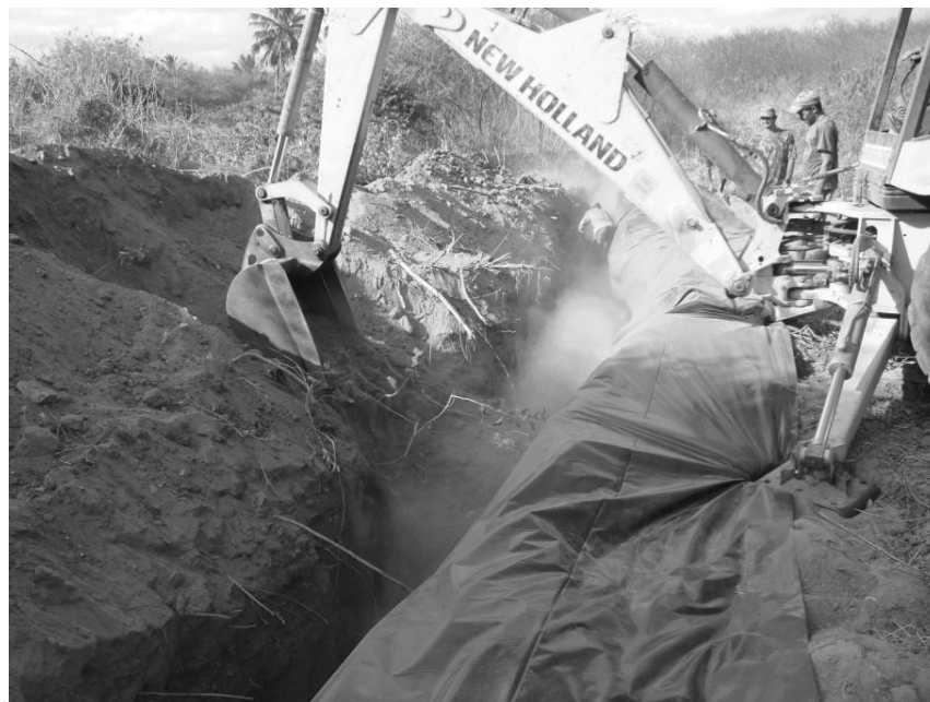
Fig. 4 Etapa final da construção da barragem subterrânea
