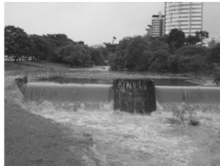
Fig.13 Bacia de detenção no município de São José do Rio Preto.
