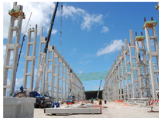
Figura 2 - Vista da montagem do Galpão (MILLEN, 2009)
