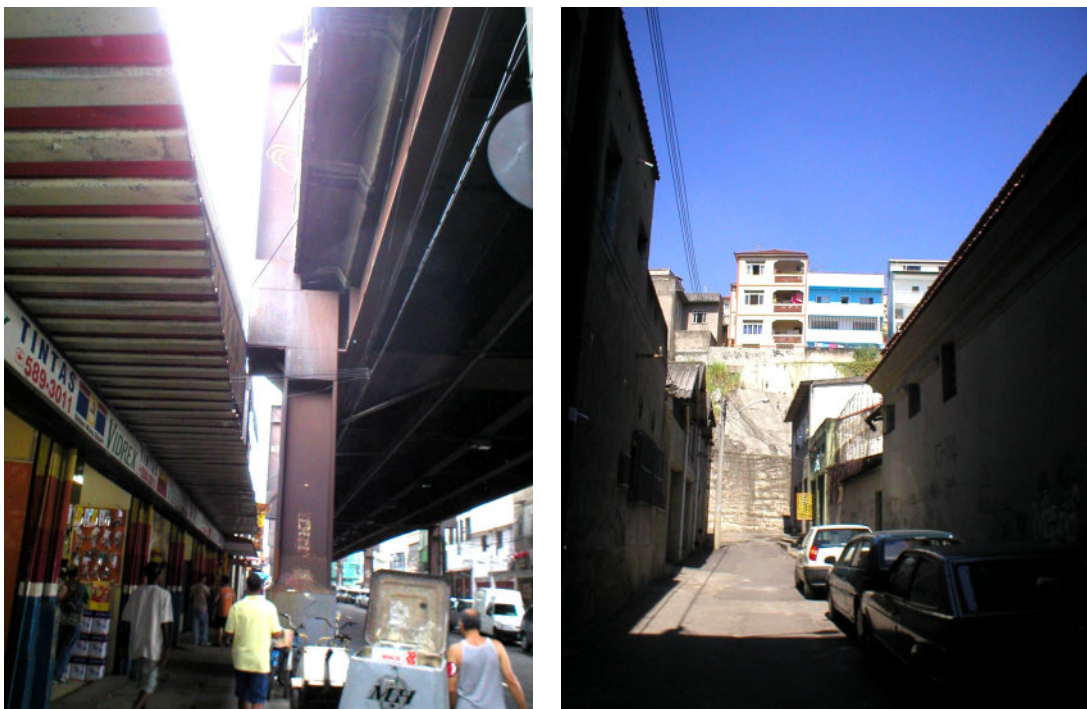
Fig. 10: À esquerda, contato da estrutura do viaduto com beiral da loja. À direita, sombra projetada pelo viaduto sobre via transversal.
