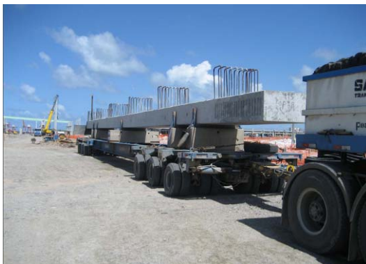
Figura 1 - Transporte de pilares com altura igual a 35 m (MILLEN, 2009)
