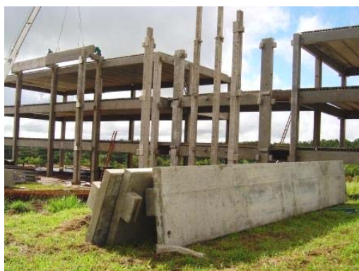
Figura 13 - Montagem e armazenamento provisório de peças – Obra A
