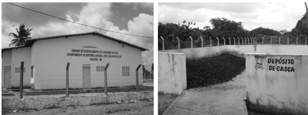
Figuras 4 e 5 – Respectivamente: fábrica de beneficiamento de castanhas e depósito de resíduos (cascas)
