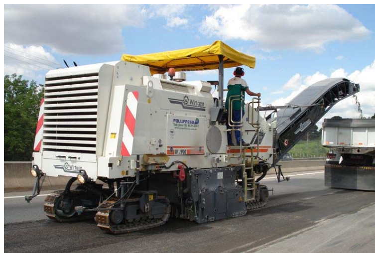
Fig. 4.1 Fresadora de pavimentos
