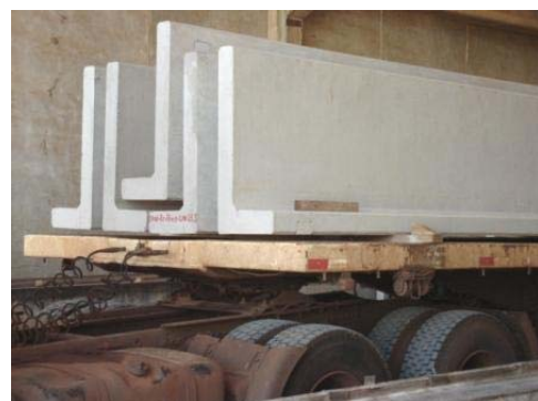
Figura 6 - Detalhe do posicionamento das peças no caminhão – Obra C
