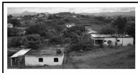
Fig. 4 Aspecto de grande parte das habitações no Mutirão Coqueiral
