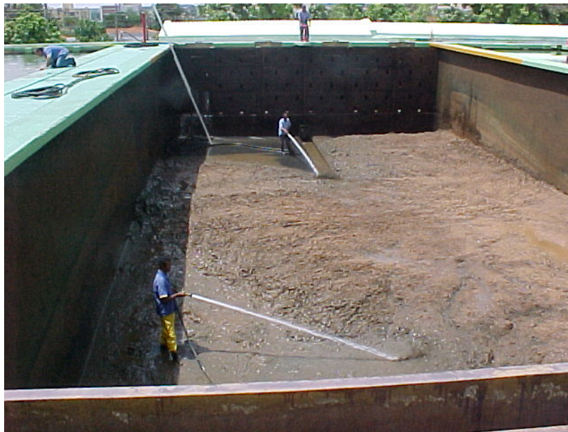
Fig. 1 Procedimento de limpeza dos tanques de decantação para remoção do lodo
