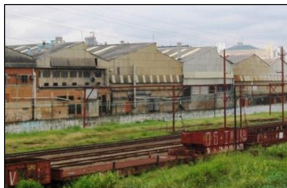
Figura 9: Galpões enfileirados junto à linha férrea trecho Mooca
