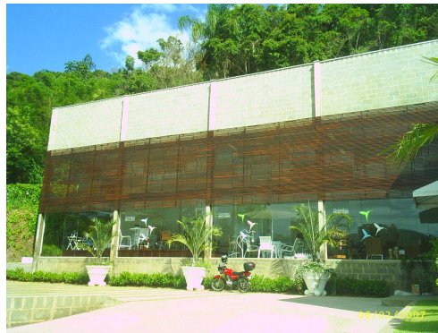
Fachada frontal NO
