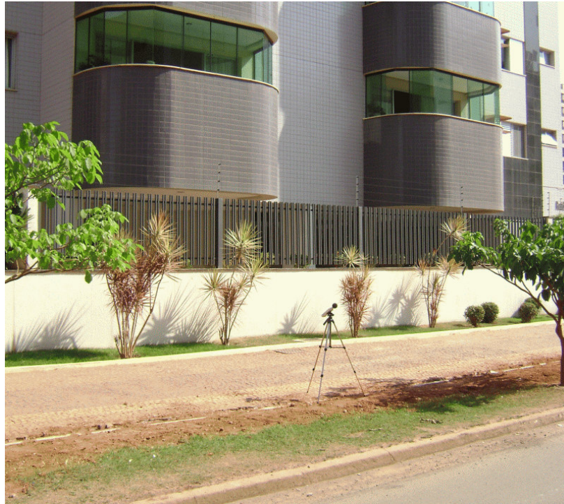
Figura 4. Medidor colocado nas proximidades da Rua 19 sul, Avenida das Araucárias
