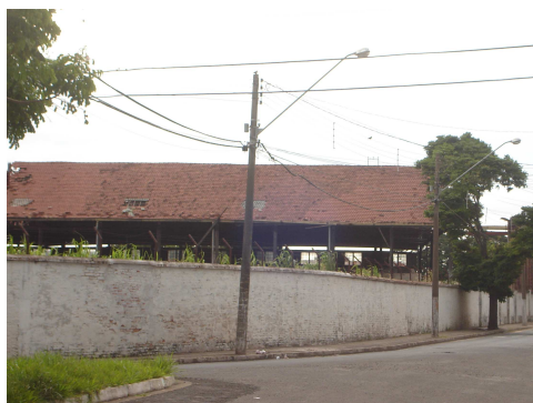
Figura 4: Muro da ferrovia e galpões abandonados cortando a cidade
