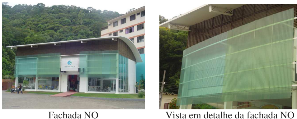
Fig. 10 Vista geral da fachada e em detalhe
