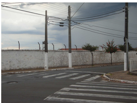
Figura 3: Muro da ferrovia cortando a cidade
