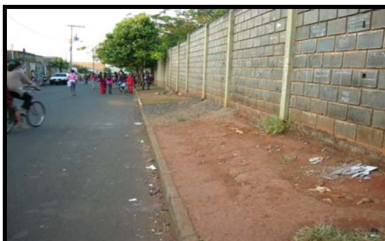
FIGURA 2: Calçada de acesso à Escola Municipal Profª Jacy de Assis, Uberlândia/MG, Junho/2007.
