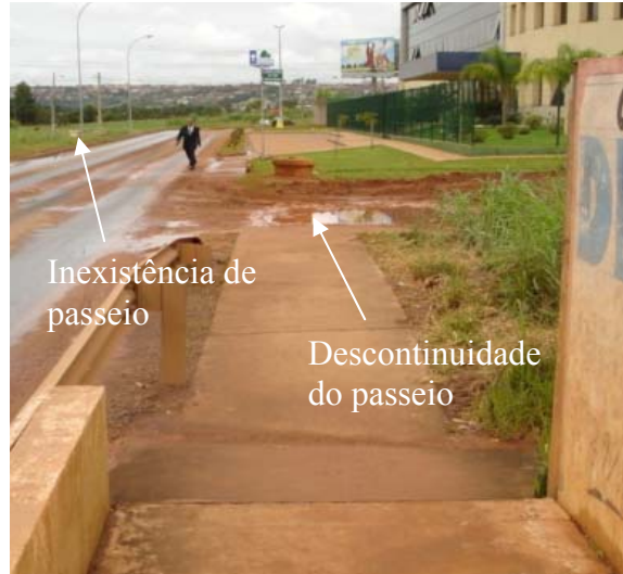
Foto 2: Inexistência e descontinuidade do passeio
