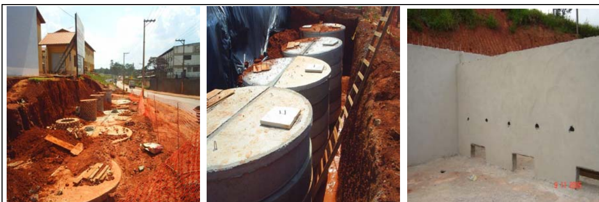
Fig. 3 Exemplos de micro-reservatórios em construção (Fonte: Soares, 2005).
