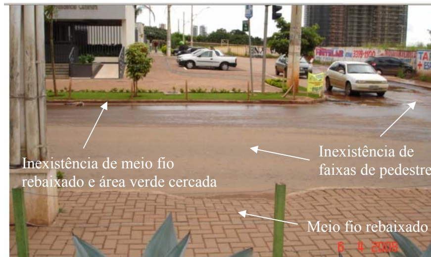
Fig. 4: Travessia em frente ao Shopping de Águas Claras
