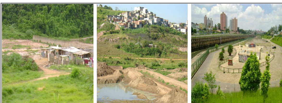
Fig. 2 Intervenções realizadas: Reservatórios Aricanduva 1, Caaguçu e Jabaquara (Fonte: Soares, 2007).
