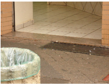
Figura 8 – Grelha na entrada da loja.
