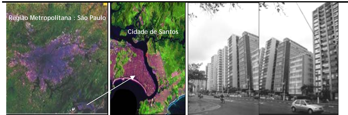
Figura 1: Localização da cidade de Santos e edifícios na área de estudo
