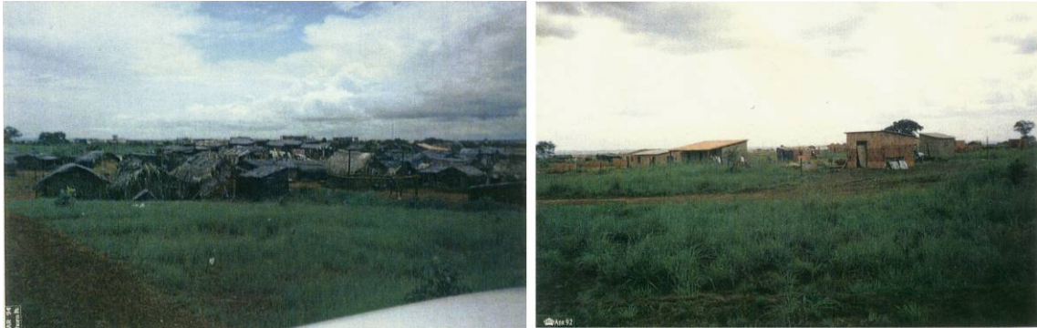
Fig. 06 Primeiras construções da Vila União. (Fonte: LIRA, 1995)
