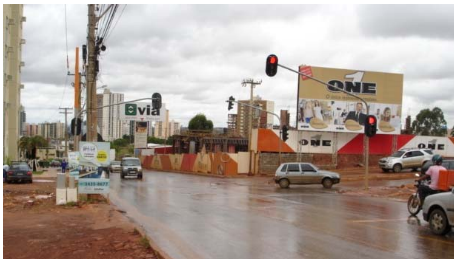
Fig. 6: Inexistência de passeios, faixas e semáforos para pedestres
