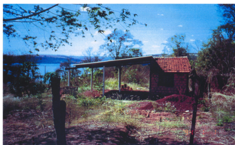
FIGURA 02 - Chácaras no seco próximas ao lago da UHE de Miranda, situadas a mais de 200 metros da cota máxima de inundação.
