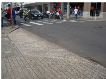
Figura 1 – Faixa de pedestres e rebaixamento de guia não coincide
