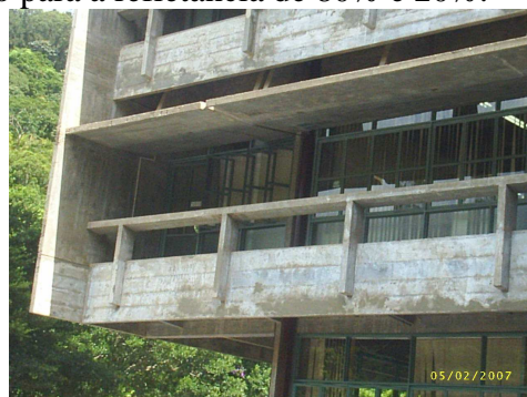
Vista da Marquise N-NE
