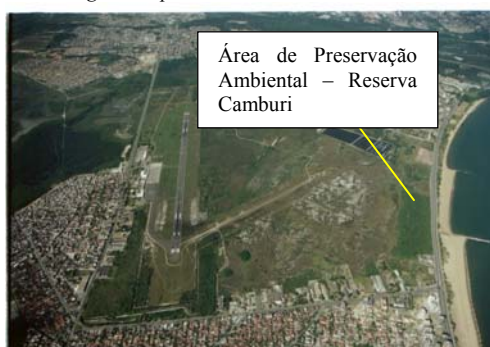
Figura 5 - Aeroporto de Vitória – Vista Aérea da área de restinga a ser preservada
