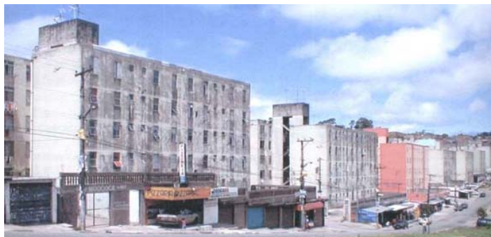
1. Fachadas dos prédios e comércio local improvisado em frente aos blocos. Fonte: USINA
