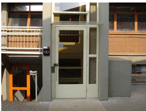
Figura 11: Plataforma destinada às PPD's que dá acesso as salas de aula do piso térreo e banheiros do ciclo básico
