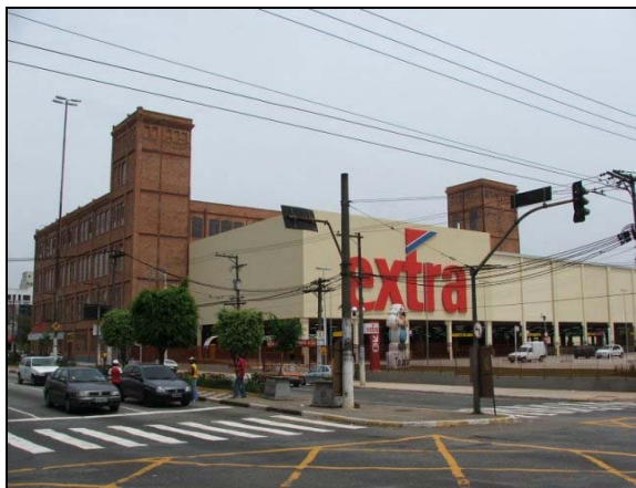
Fig. 3 Edifício da fiação do Cottonificio Crespi, parcialmente demolido para a instalação de um hipermercado. Foto da autora, 2005
