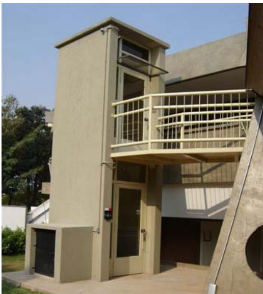
Figura 15: Plataforma destinada às PPD's que dá acesso as salas de aula do piso superior
