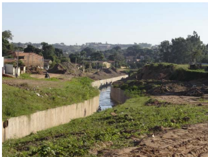
Figura 5. Canalização do Córrego do Saltinho.
