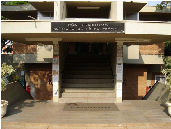
Figura 13: Acesso ao prédio da pós-graduação do Instituto de Física atendido somente por escadas
