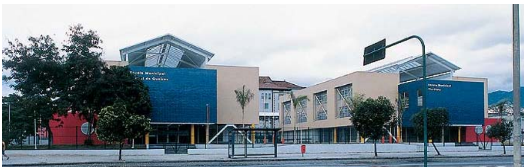
Figura.08 – Escolas sujeitas à reverberação do pátio interno
