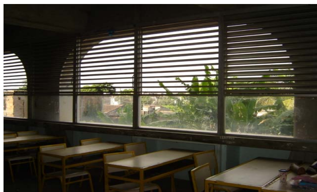
Figura. 10 – Vista interna da janela
