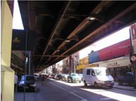
Figura 3 Passagem da Linha Vermelha sobre rua Figueira de Mello
