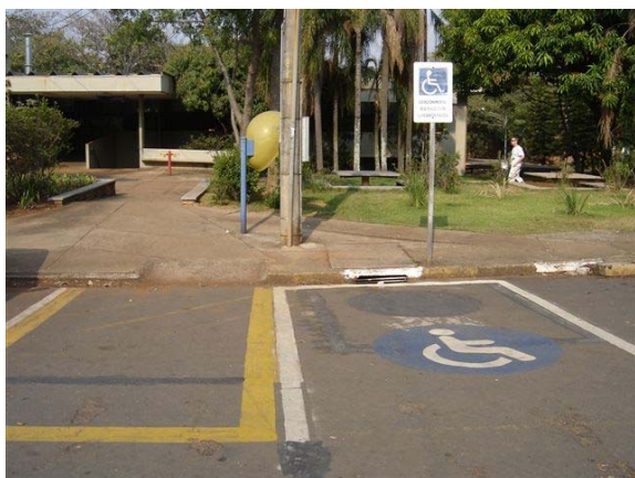
Figura 9: Vaga destinada às PPD's com simbologia em desacordo com a Norma
