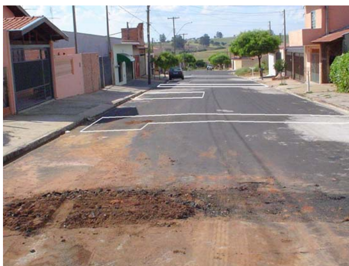
Fig. 2 Exemplo de interferências do SAAE nos pavimentos de São Carlos
