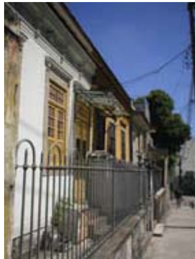
Figura 6 Residências Térreas rua Fonseca Teles
