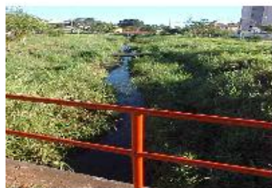
B: Forma de obstrução do canal: tubulação de esgoto.
