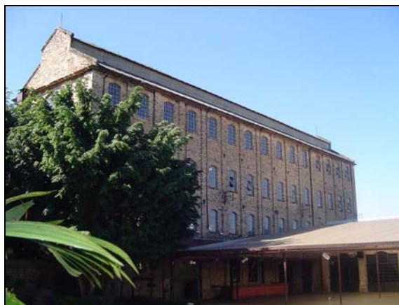
Fig. 4 Antigo Moinho Gamba. Rua Borges de Figueiredo. Foto da autora, 2004
