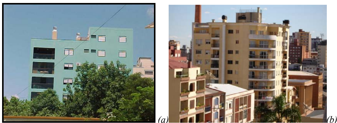
Figura 3 Edifício A (a) e Edifício B (b)
