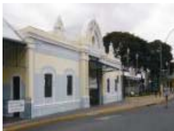
FIGURA 7 e 8: Estação Ferroviária
