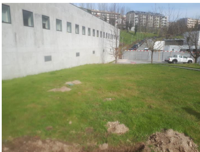
Figura 17 – Início de Obra 02
