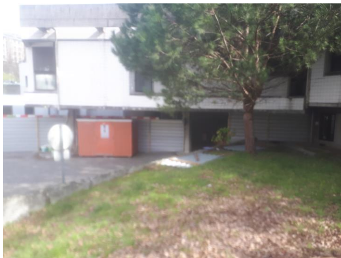
Figura 16 – Início de Obra 01
