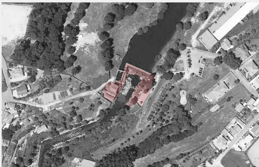
CENTRAL HIDROELÉCTRICA DO AMIEIRO GALEGO
