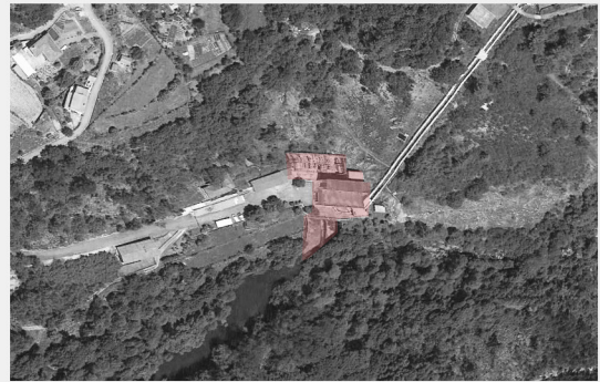
COMPANHIA HIDROELÉCTRICA DO ERMAL
