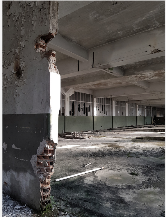
FIGURA 82 A MATERIALIDADE DA FÁBRICA
