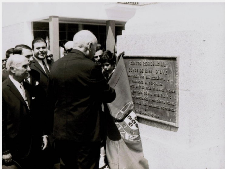
FIGURA 34 INAUGURAÇÃO DO CENTRO RESIDENCIAL CONDE DE RIBA DE AVE NO ANO DE 1969
