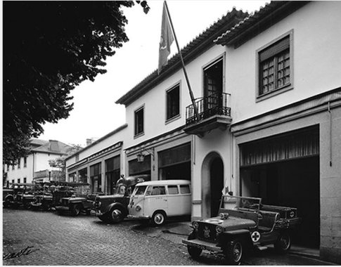
QUARTEL DE BOMBEIROS
