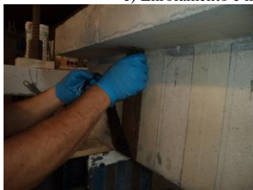
f) Colagem da faixa de manta em U (alma da viga)
