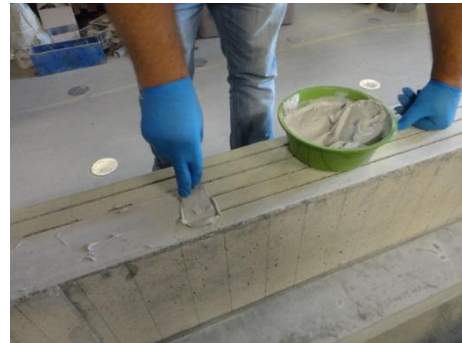
d) Aplicação do adesivo no entalhe
