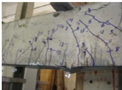
B1F – Ruptura do reforço
