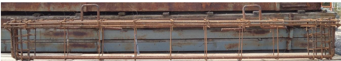
Aspetto geral das armaduras das vigas da série 1
