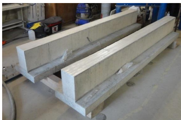
g) Aspeto geral das vigas após o reforço à flexão
