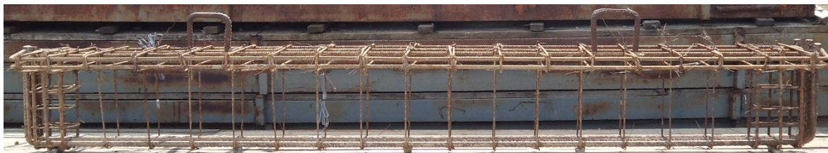
Aspetto geral das armaduras das vigas da série 2
