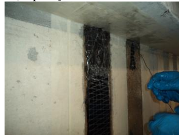
e) Enrolamento e introdução na manta nos orifícios (U invertido)
