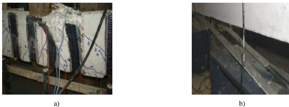
Figura 8 - Rotura por destacamento do CFRP colado externamente: a) ao corte (El-Ghandour, 2011), b) à flexão (Coelho et al. , 2012).
