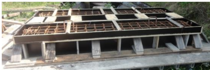
Aspetto geral das armaduras inseridas na cofragem
