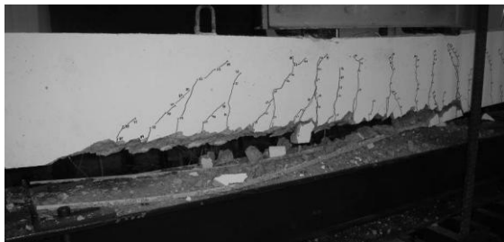
Viga reforçada com dois laminados
