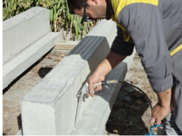
c) Limpeza das zonas do sistema de fixação
