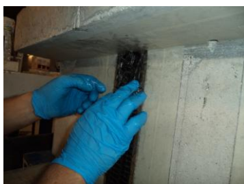
h) Verificação da correta aplicação do reforço
