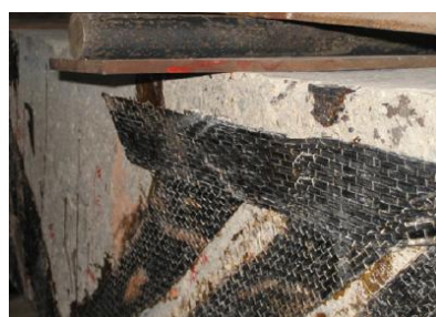
SR5 - Descolagem das mantas de ancoragem
