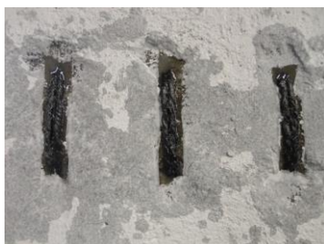
j) Aspeto das mantas na parte superior da viga
