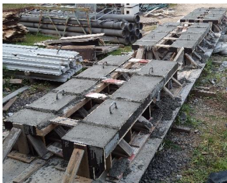
Betonagem das vigas
