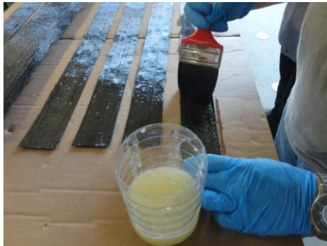
c) Aplicação de resina na manta
