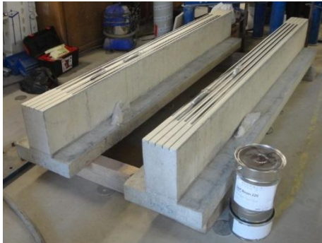
a) Vigas a reforçar, laminados e componentes do adesivo
