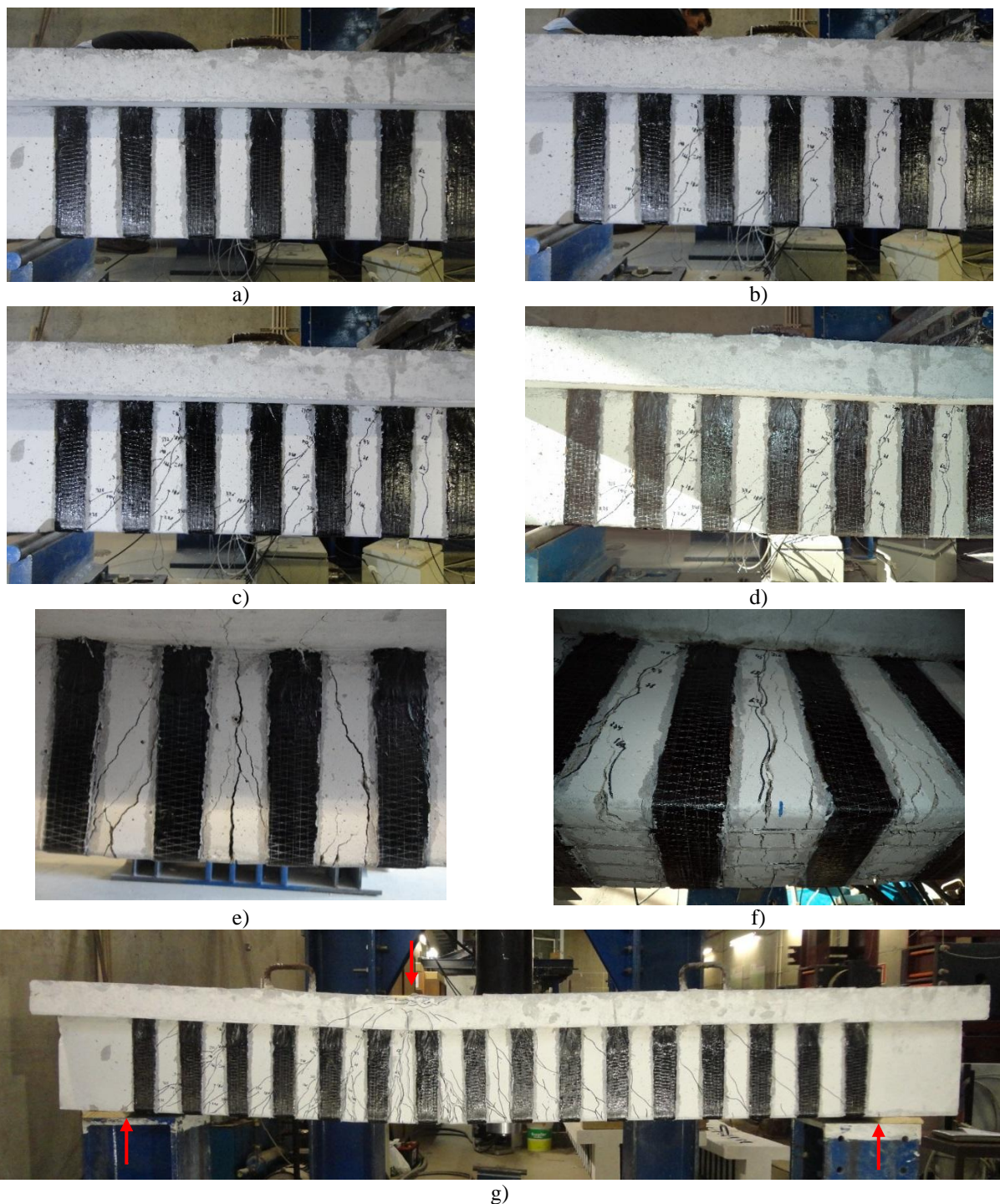
Figura 82 - Comportamento da viga S1SFS-A: a) aparecimento da primeira fenda de flexão, b) padrão de fendilhação registado para uma carga de 312 kN, c) padrão de fendilhação registado para uma carga de 368 kN, d) momento em que a viga atinge a capacidade de carga máxima, e) rotura por flexão (fenda de flexão vertical na secção de aplicação da carga), f) rotura dos laminados, g) padrão de fendilhação final registado na viga.
