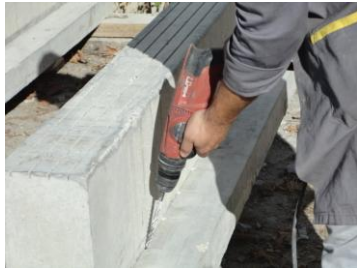
a) Realização de orifícios no banzo da viga
