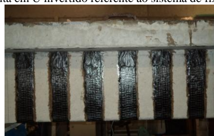
i) Reforço ao corte com manta em forma de U com o sistema de fixação das extremidades
