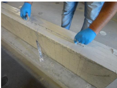
e) Inserção do laminado no entalhe
