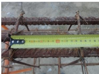
Verificação da posição dos estribos
