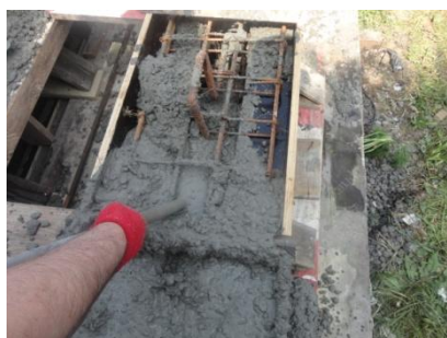
Verificação da posição dos estribos
