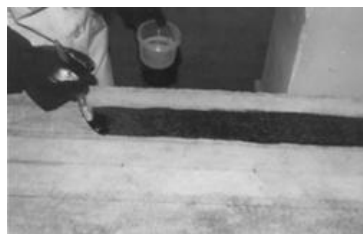
Aplicação do primário
