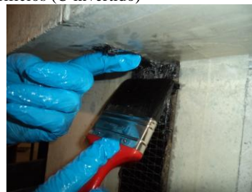
g) Impregnação conjunta da faixa de manta em U com a manta em U invertido referente ao sistema de fixação
