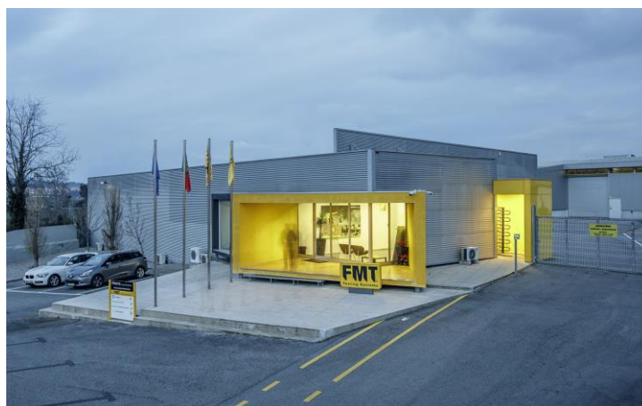
Figura 15 - Instalações da FMT na Trofa
