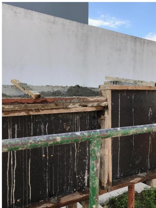
Figura 4: Improviso inadequado na cofragem.
