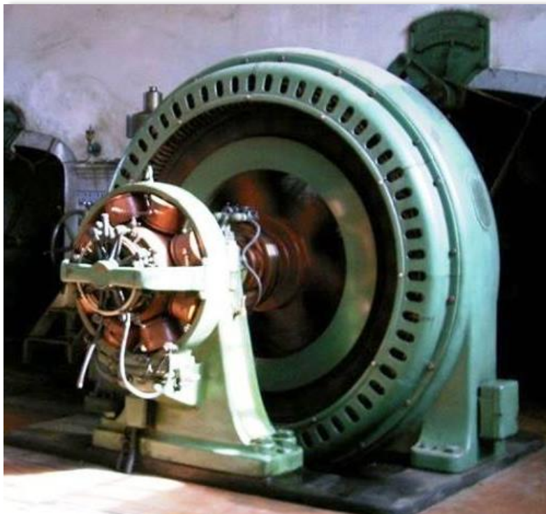
Figura 6.3. Antigo alternador síncrono de eixo horizontal da CMH.
