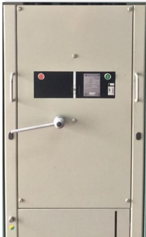
Figura 3.8. Disjuntor de pequeno volume de óleo.
