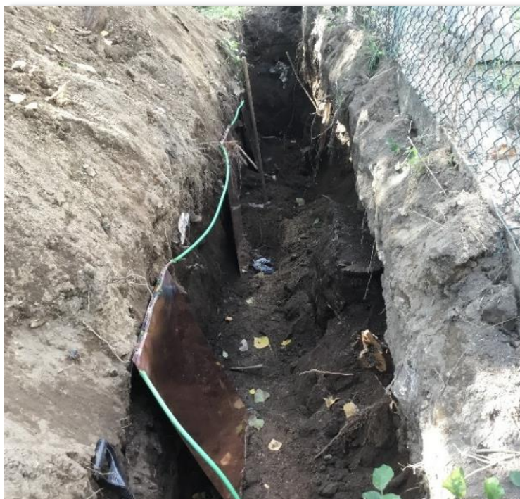
Figura 3.60. Vala com as chapas de cobre para o aterramento.
