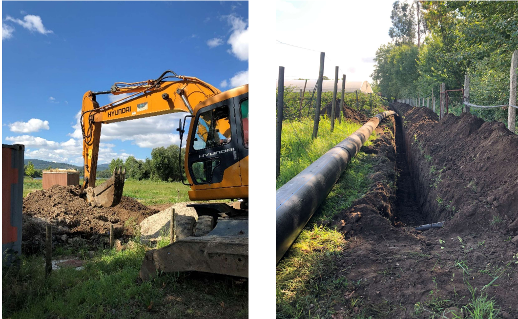
Figura 19 - Abertura de valas
