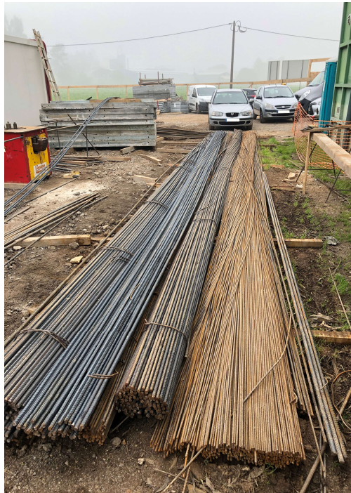
Figura 26 - Armazenamento dos varões de aço
