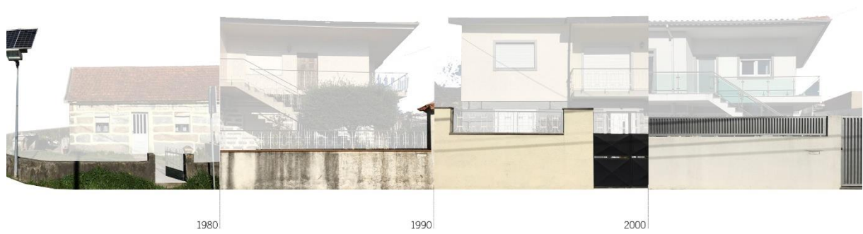
FIGURA 16_ A PROGRESSIVA PERDA DE PERMEABILIDADE
