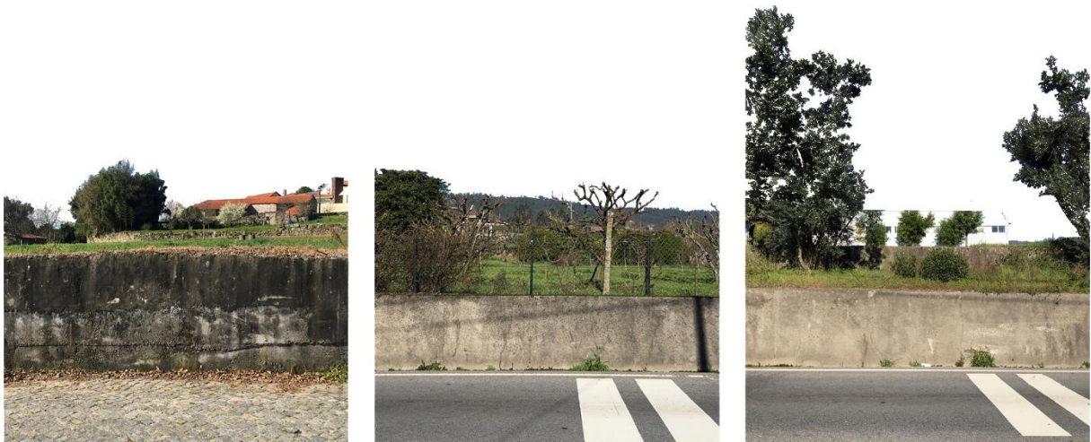
FIGURA 19_ MUROS DE CONTENÇÃO DE TERRA
