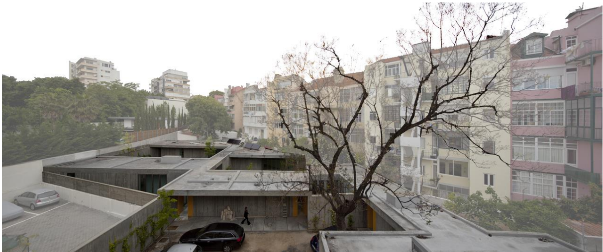
FIGURA 47_ DISSIPAÇÃO DE OLHARES DE UMA ENVOLTE INTENSA PELA COBERTURA, “LIMITE DE PROPRIEDADE” SUPERIOR, ATRAVÉS DE ABERTURAS E FECHOS, 2 CASAS EM SANTA ISABEL, RICARDO BAK GORDON, 2008, CARNAXIDE.
