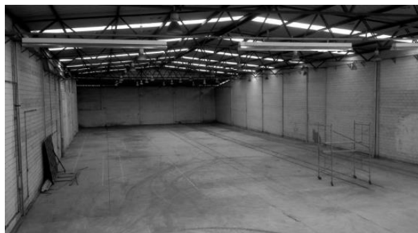
Figura 21 – Galpão antes das obras iniciadas Fonte: Site Medium 1
