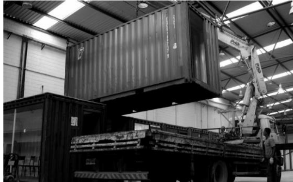
Figura 22 – Processo de Montagem do galpão – Instalação de Contentores Fonte: Site Medium 1
