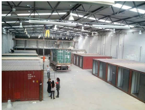
Figura 23 – Processo de Montagem do galpão – Contentores quase todos instalados Fonte: Site Medium 2
