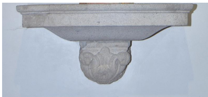
Figura 10 - Mísula de pedra, suporte do antigo púlpito
