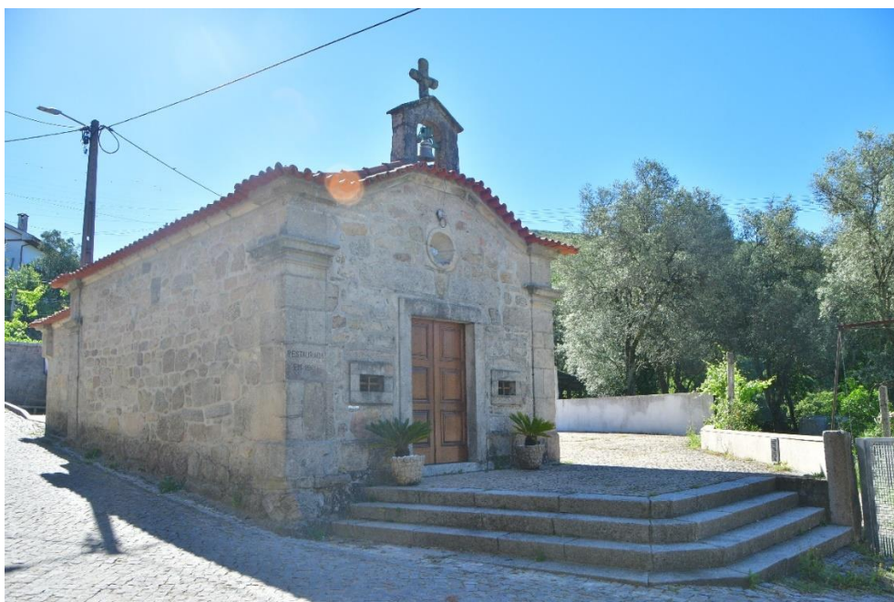
Figura 15 - Aspeto geral da capela de S. Simão e S. Judas Tadeu, após o último restauro de 1990
