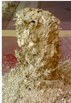
Figura 2: Desagregação de um provete cilíndrico de betão após exposição a 1000 °C
