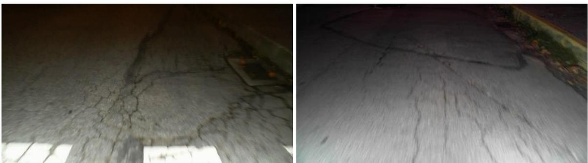
Figura 60: Imagens com alguma qualidade captadas no levantamento de outubro de 2018 à noite, com holofotes e a 25 km/h (câmara 1 à esquerda e 2 à direita).
