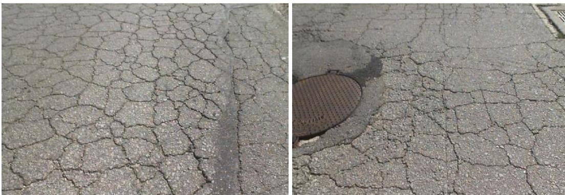
Figura 48: Imagens com qualidade captadas com a câmara 1 no levantamento de julho de 2018 e que permitiram a avaliação do nível de fendilhamento
