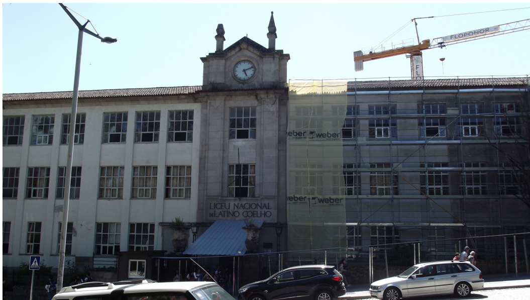
Figura 2: Fachada da ESLC
