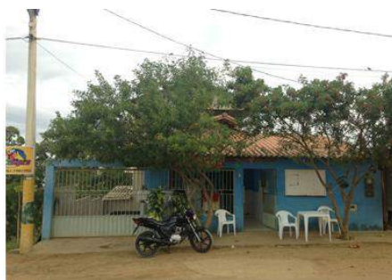
Figura 3. Fachada frontal Unidade Residencial denominada Amostra 1
