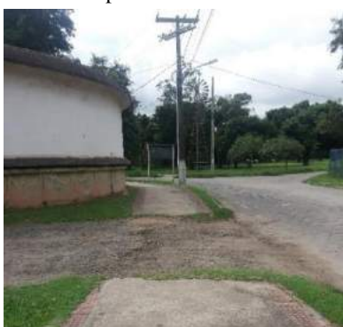
Figura 3. Travessia do tipo acesso de veículos sem pavimentação
