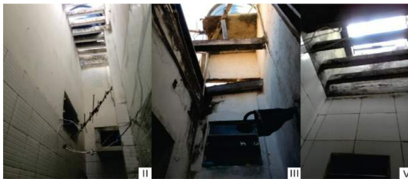
Figura 5. Imagens dos poços de luz para ventilação natural nas residências de estudo II, III e V
