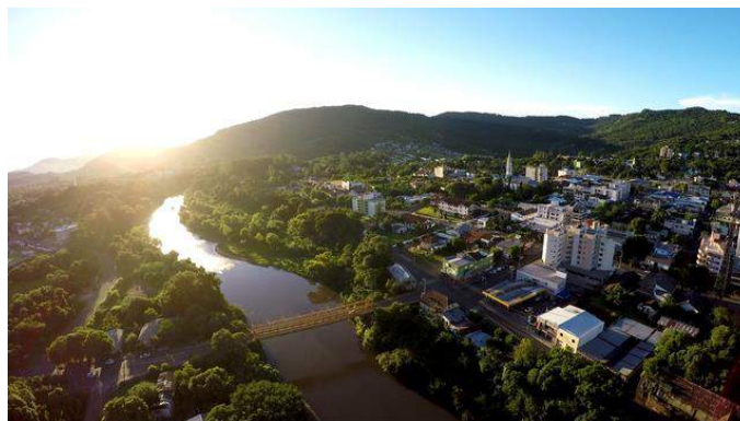
Figura 1. Vista aérea do Município de Feliz com destaque para o Rio Caí.
