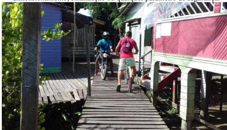
Figura 4. Passarelas são compartilhadas entre pedestres, ciclistas e motociclistas, mas não apresentam dimensionamento, sinalização ou qualquer parâmetro de segurança.
