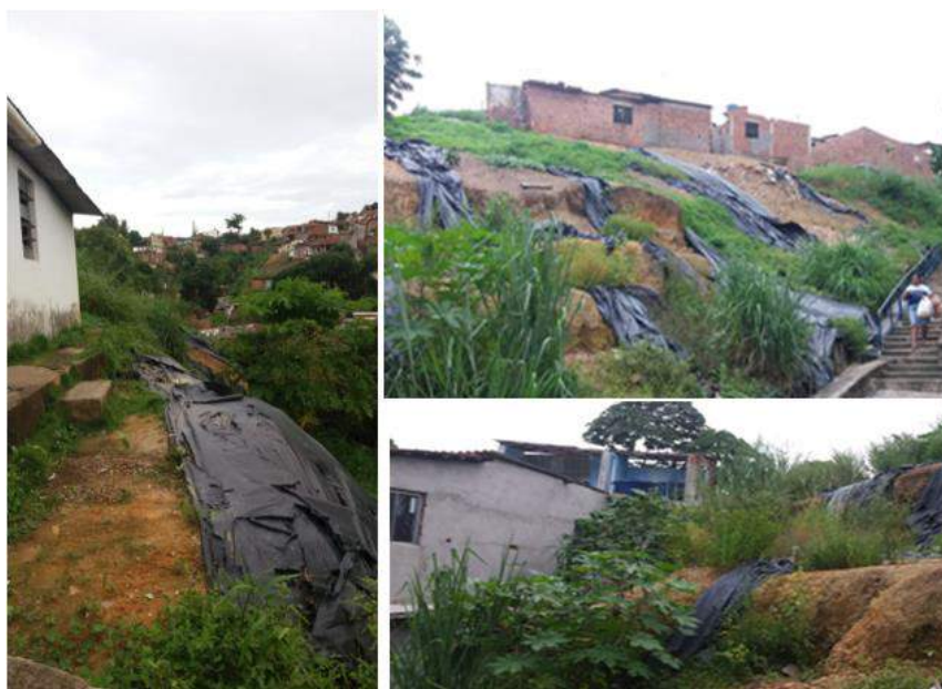
Figura 2. Construções próximas a encostas no bairro Dois Unidos – Recife/PE
