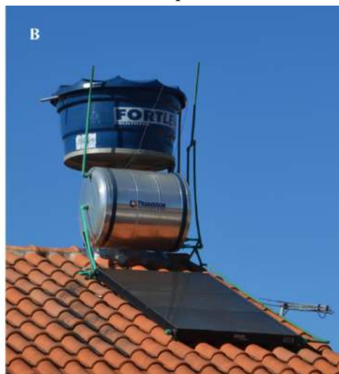
Figura 3. Sistema de aquecimento solar de água: a) vista lateral; b) foto aproximada
