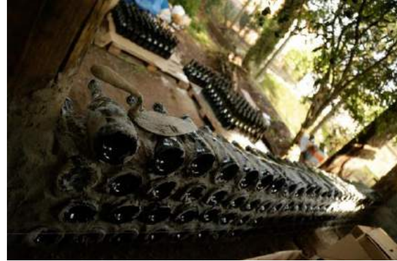
Figura 2: parede de garrafas e pilares de postes
