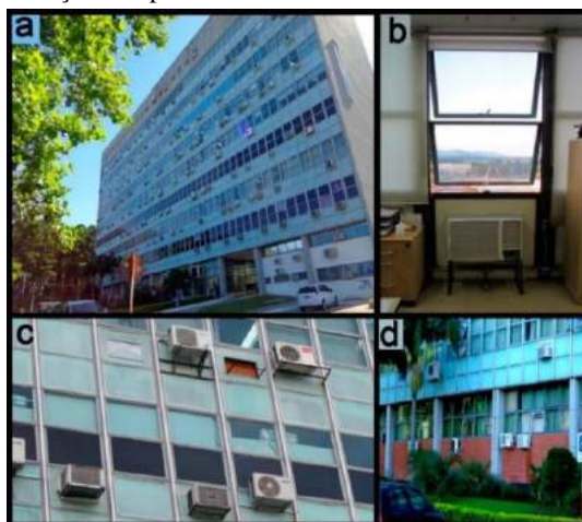
Figura 4. Inserção de aparelhos de ar condicionado na fachada leste.
