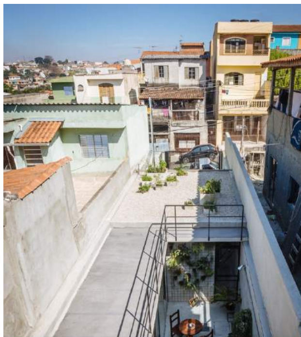
Figura 04. Casa de Vila Matilde – Terraço
