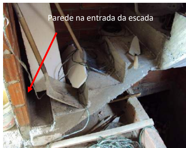
Figura 3: Escada terminando na parede
