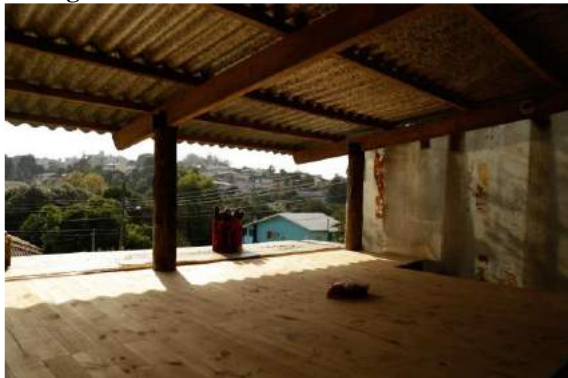
Figura 5: telhado de telhas com caixa de leite
