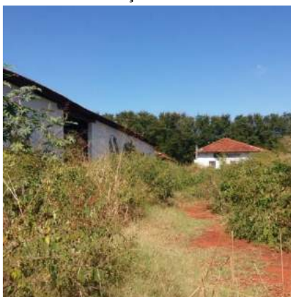
Figura 2. Obras abandonadas da Estação de Tratamento de Esgoto de Nerópolis.
