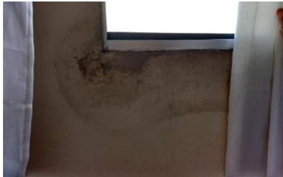
Figura 6 - Infiltração
