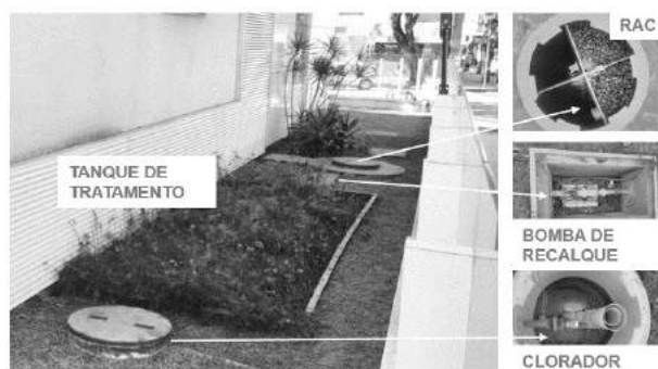
Figura 5. ETAC com wetland implantada no banco SICOOB.
