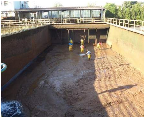
Figura 1. Limpeza de um decantador
