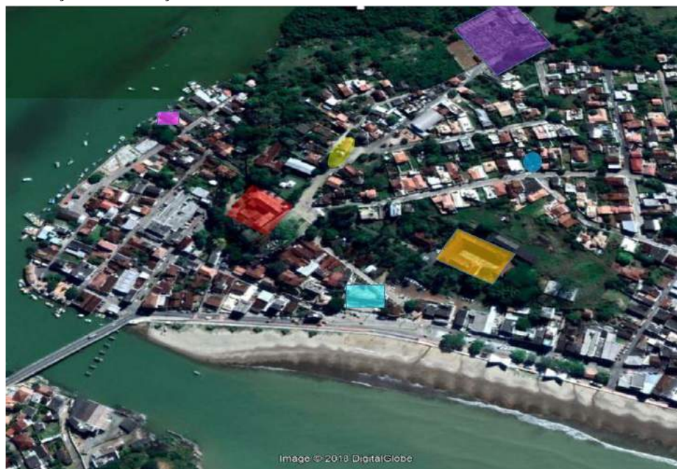
Figura 4. Localização das edificações históricas no entorno do santuário Nacional José Anchieta – Anchieta- ES
