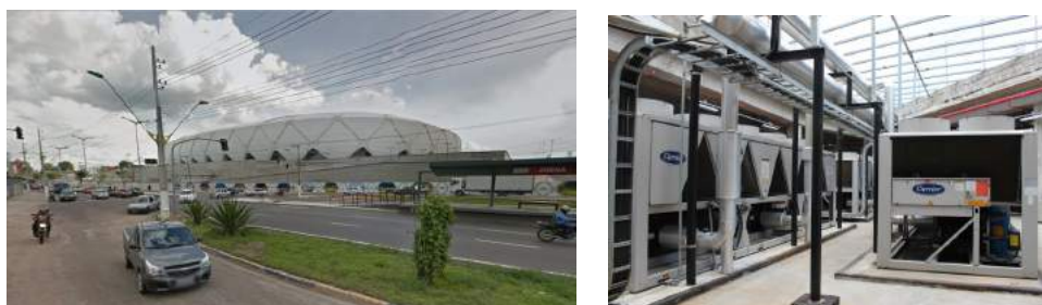
Figura 4 – Entorno da arena e Central de ar condicionado
