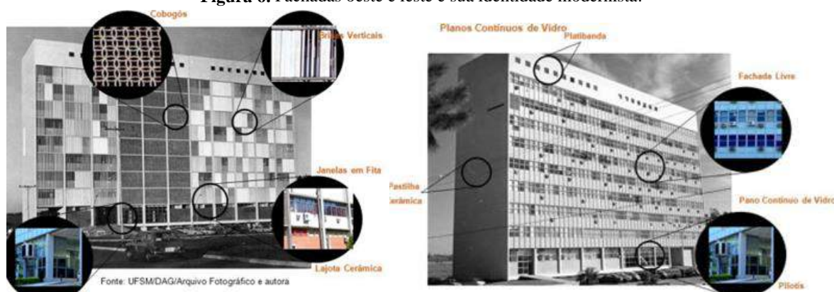
Figura 6. Fachadas oeste e leste e sua identidade modernista.
