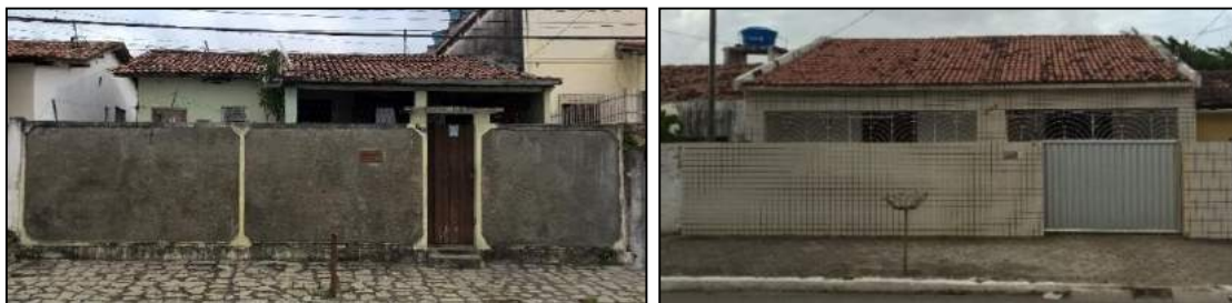
Figuras 3 e 4: Fotos das fachadas das edificações.
