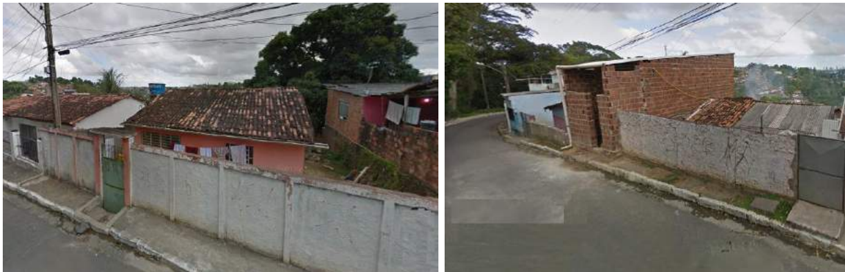
Figura 1. Tipologias construtivas do bairro Dois Unidos – Recife/PE
