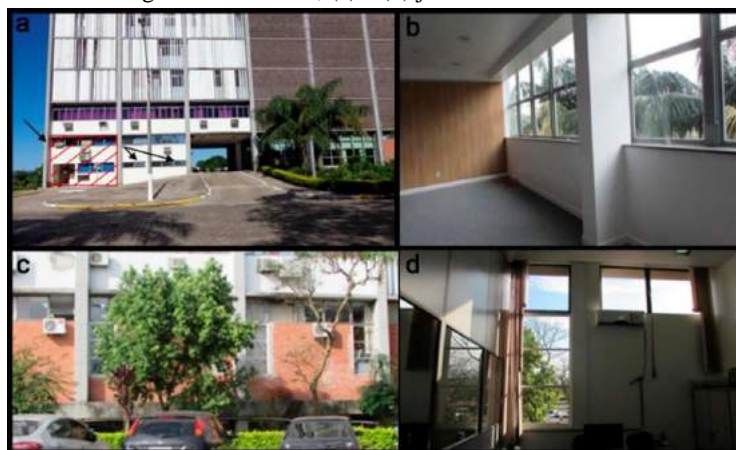
Figura 5. Alterações das fachadas do prédio da Reitoria: (a) fechamento da passagem no térreo; (b) peitoris internos em gesso acartonado; (c) e (d) janelas verticais.
