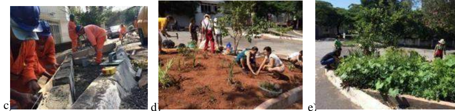
Figura 5. (c) Funcionários da Subprefeitura de Pinheiros executando o Jardim de Chuva; (d) Finalização da infraestrutura; e (e) Jardim de Chuva sendo cuidado pela população nove meses após o plantio.
