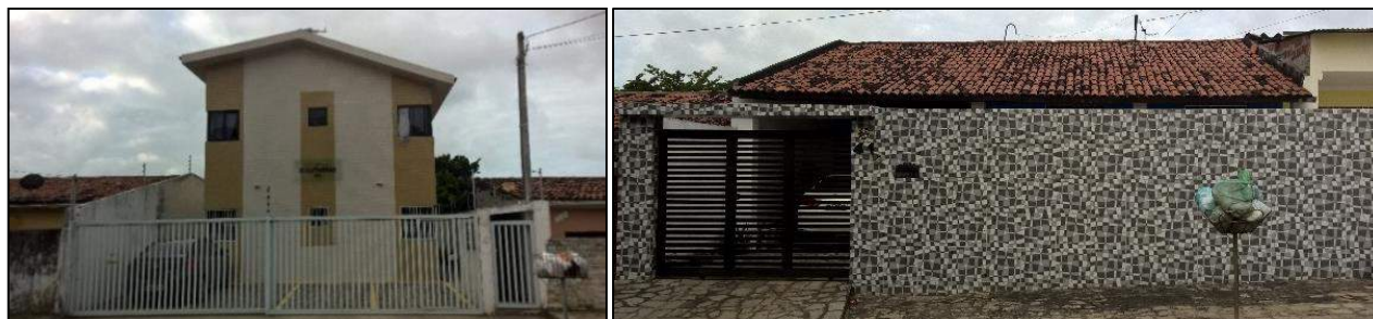
Figuras 6 e 7: Fotos das fachadas das edificações.
