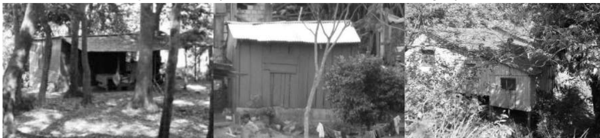
Figura 5. Edificação afastada do solo, uso de beiral e de vegetação.
