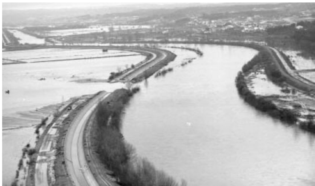
Figura 4.4 – Regularização fluvial do Baixo Mondego: leito central e canais de rega
