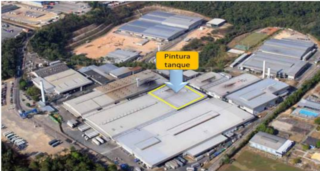
Figura 10 - Localização da pintura tanque na fábrica
